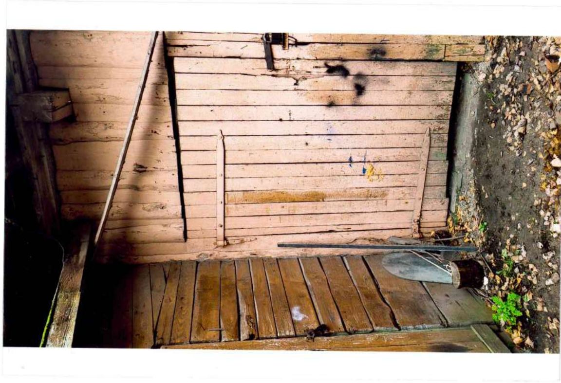
34. attēls. Saimniecības ēkas dēļu durvis D-3 ar kaltām metāla virām kāšos.
