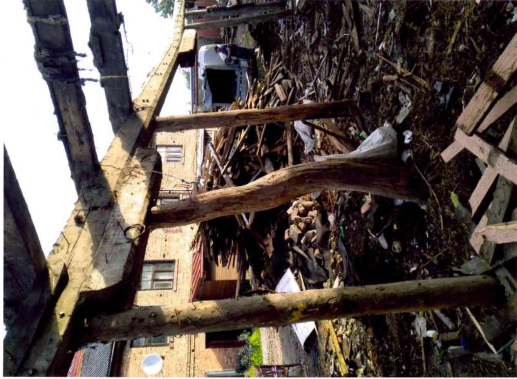
36. attēls. Saimniecības ēkas nesošā koka karkasa konstrukcija pēc sienu jumta un sienu demontāžas. Konstrukcijām atsevišķās vietās izmantoti neapzāģēti apaļkoki. Iekšpagalma fasādes R daļa.
