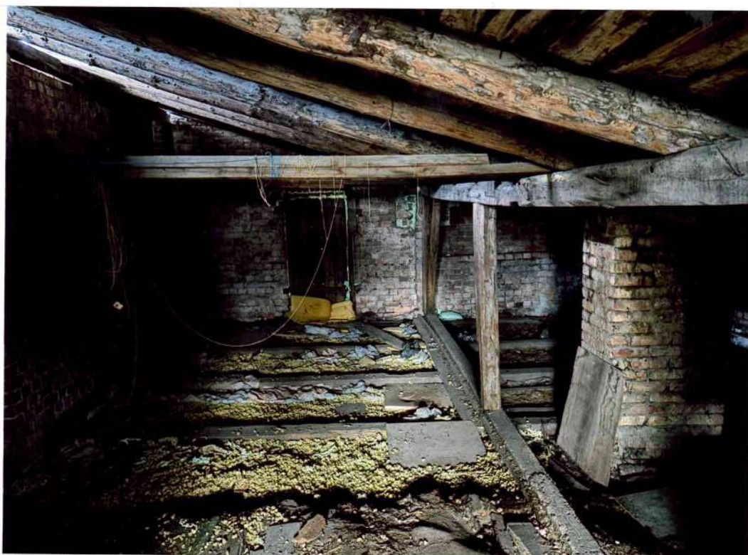
29. attēls. Dzīvojamās ēkas Nr.32 mūra apjoma bēniņtelpa. Saglabājusies sākotnējā jumta konstrukcija, apaļkoka spāres, jumta krēsls, dēļu bēniņu lūka ar kaltām metāla virām.
