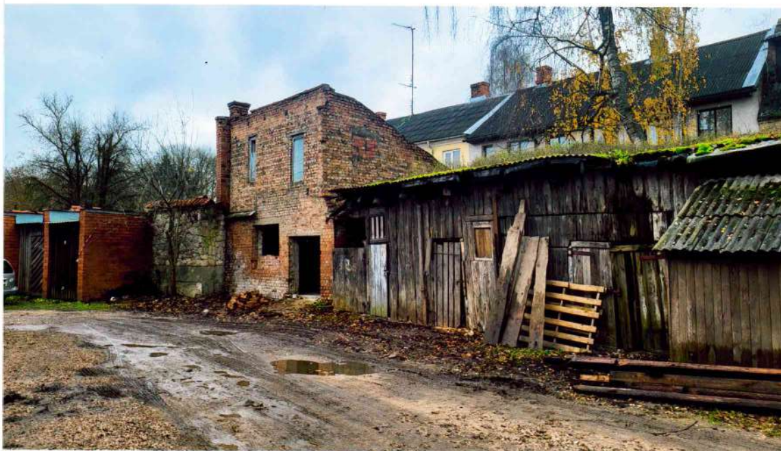
14. attēls. Dzīvojamās ēkas un palīgēkas Z fasādes iekšpagalma DA daļā
