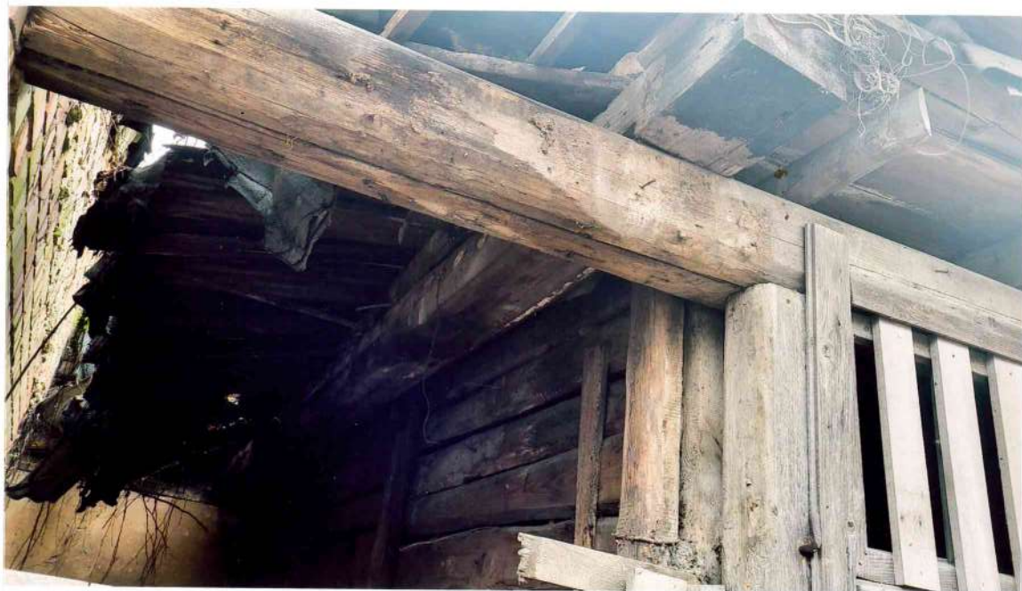
16. attēls. Saimniecības ēkas jumta dzegas mezgls pie savienojuma ar neapdzīvoto mūra dzīvojamo ēku.
