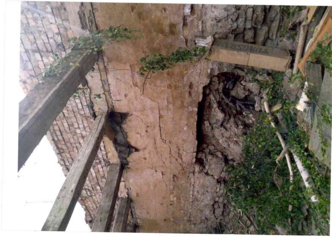
20. attēls. Saimniecības ēkas ārsienas ( mūra žogs pret Kalēju ielu) fragments (Austrumu daļa) ar koka pārseguma sijām no sākotnējās ēkas. Sienas apakšējā daļa bojāta ar ieaugušo koku saknēm.
