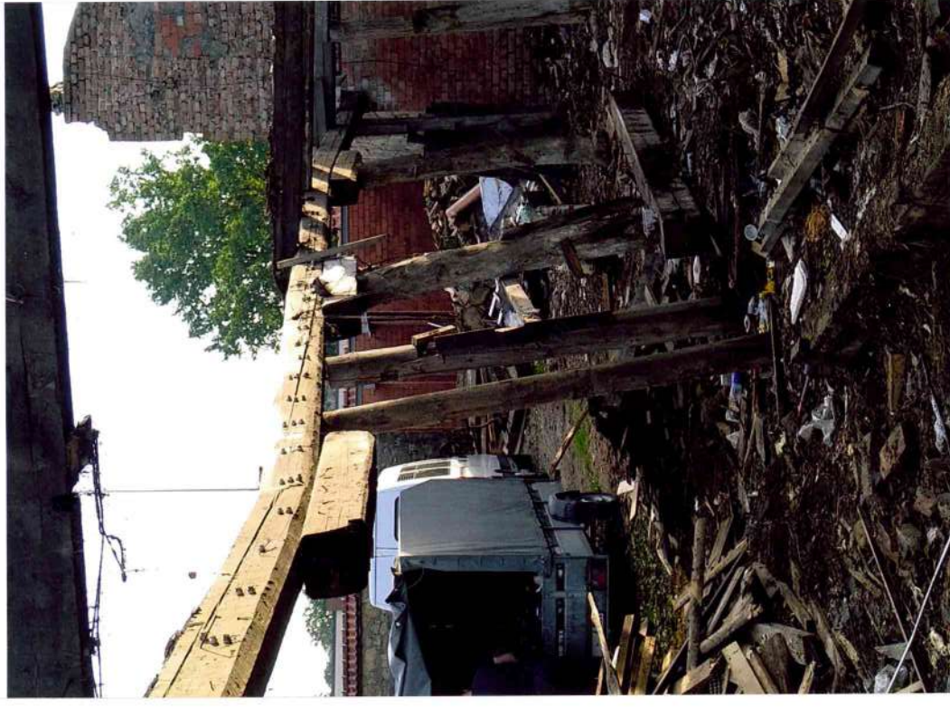
37. attēls. Saimniecības ēkas nesošā koka karkasa konstrukcija pēc sienu jumta un sienu demontāžas. Vertikālās konstrukcijām iekšpagalma fasādes A daļa.
