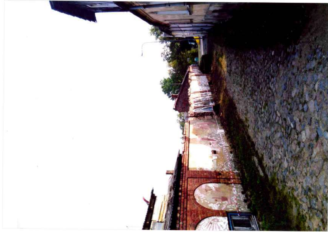
8. attēls. Esošais mūra žoga kopskats pēc koku nozāgēšanas, mūraposmapie koku celmiem saskrējies uz iekšpagalma pusi.
