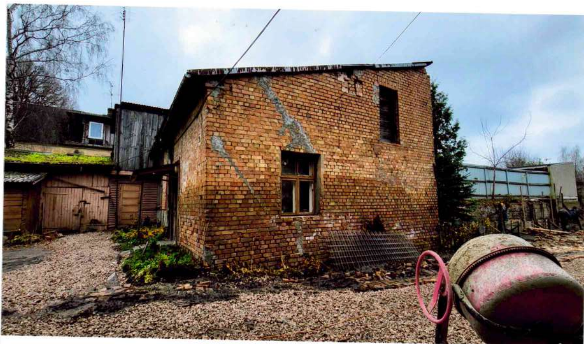
27. attēls. Dzīvojamās ēkas Nr.32 mūra apjoma Z fasāde. Mūra lejasdaļā mitruma plankumi. Saglabājies sākotnējais koka logs L-1 (112X155cm), koka dēļu bēniņu lūka.
