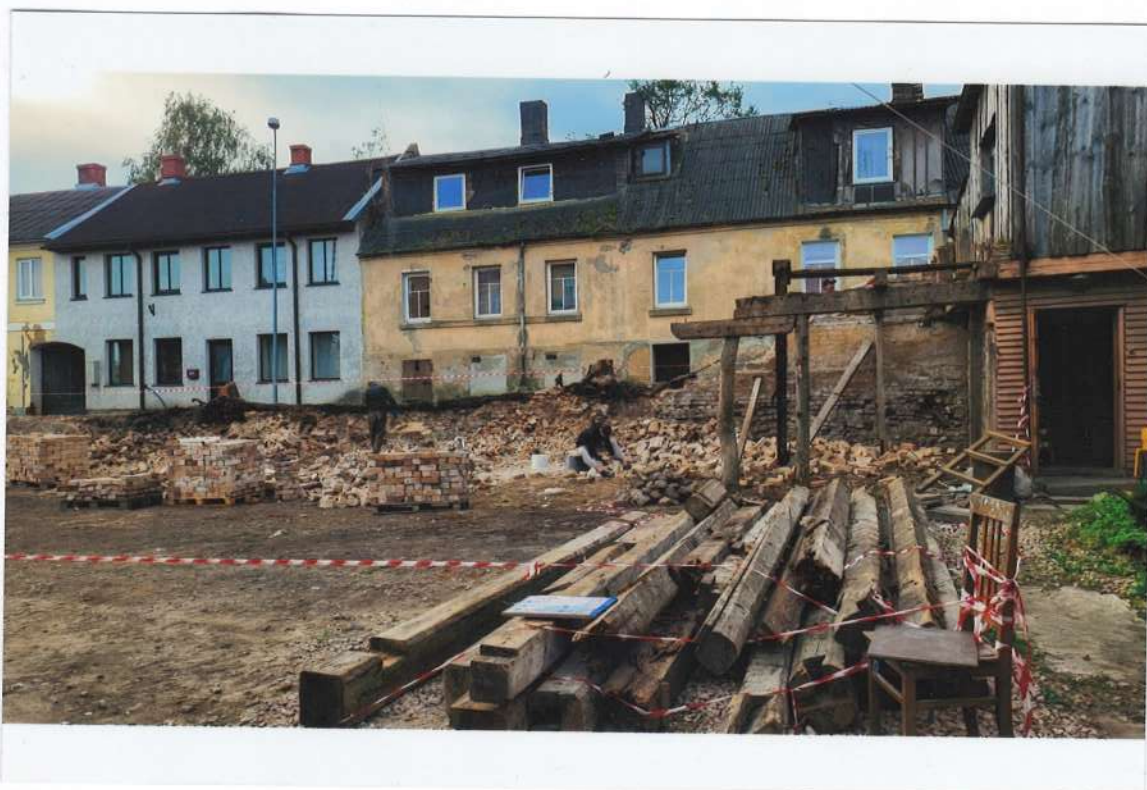
39. attēls. Iekšpagalma D malas apbūves kopskats pēc saimniecības ēkas demontāžas. A galā saglabāta dzīvojamā ēka Nr.32. Koka konstrukcijas saglabātas atkārtotai izmantošanai.
