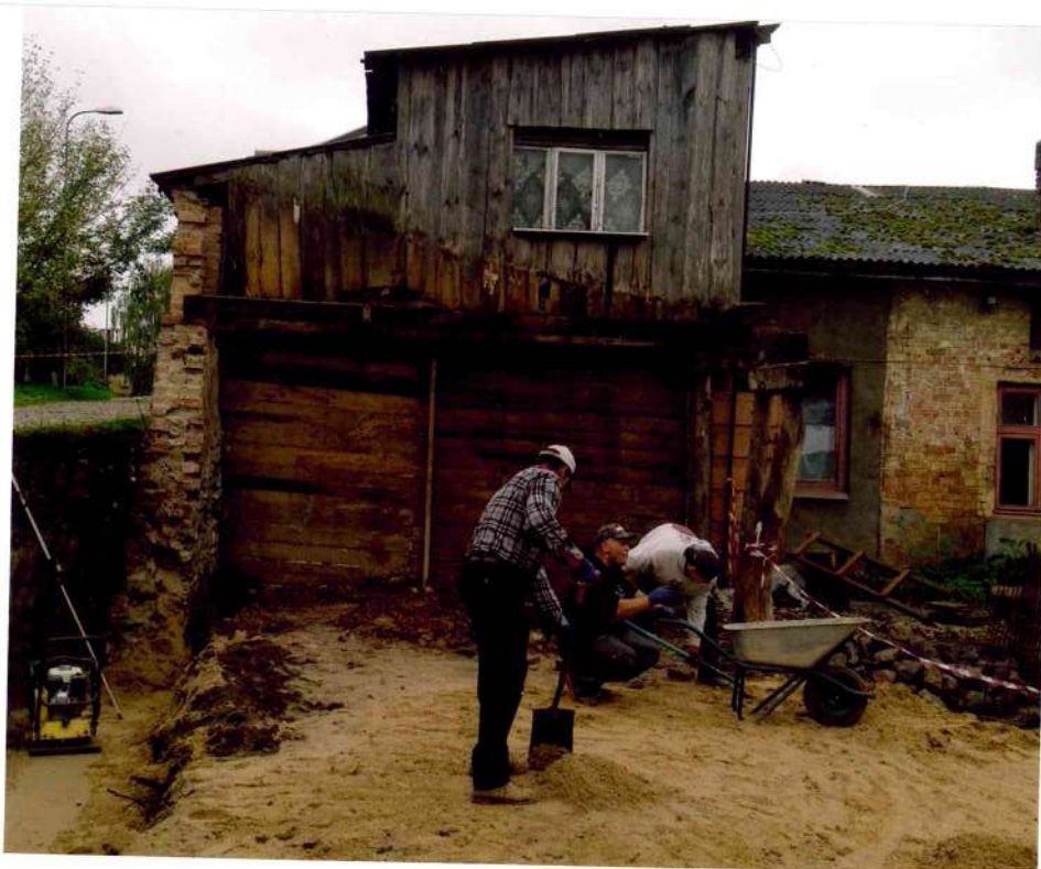
25. attēls. Dzīvojamās ēkas Nr.32 koka apjoma A ārsiena. Skats no demontētās koka saimniecības ēkas puses. Koka apjoms piebūvēts pie mūra žoga gar Kalēju ielu.
