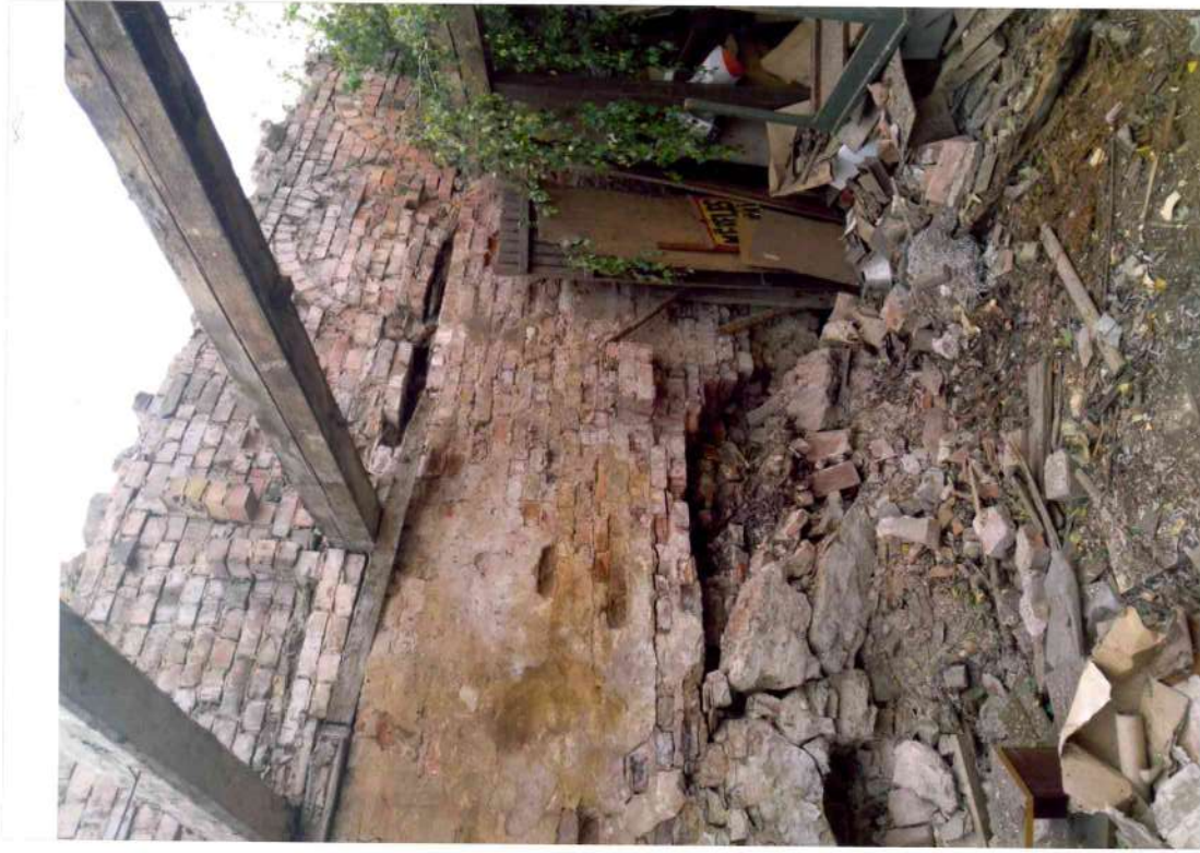
22. attēls. Saimniecības ēkas ārienesas ( mūra žogs pret Kalēju ielu) fragments (Rietumu daļa) ar koka pārseguma sijām no sākotnējās ēkas. Sienas apakšējā daļa bojāta ar ieaugušo koku saknēm.
