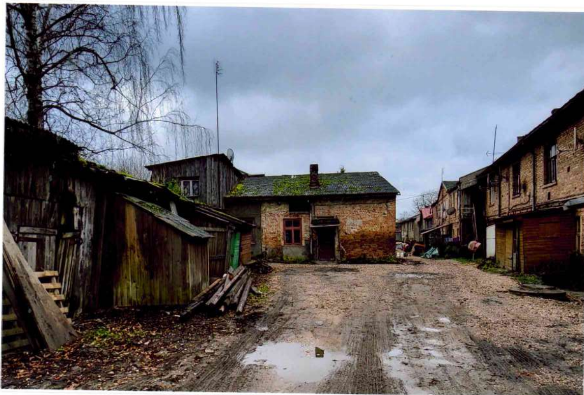
24. attēls. Dzīvojamās ēkas Nr.32 kopskats no iekšpagalma. Ēka veidojusies no diviem apjomiem: koka daļa Kalēju ielas pusē pie mūra žoga un ķieģeļu mūra daļa iekšpagalma pusē.
