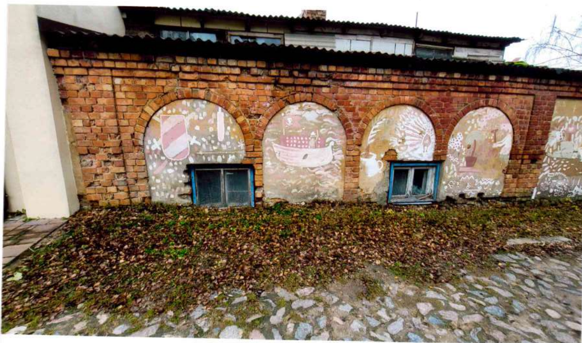
7. attēls. Mūra žoga fragments gar Kalēju ielu grunts gabala R stūrī. Žogā sekundāri iebūvētas logu aillas, ignorējot sākotnējo žoga arhitektūru.
