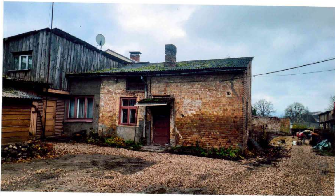
26. attēls. Dzīvojamās ēkas Nr.32 mūra apjoma A fasāde. Mūra lejasdaļā mitruma plankumi. Saglabājies sākotnējais koka logs L-1 (112X155cm).
