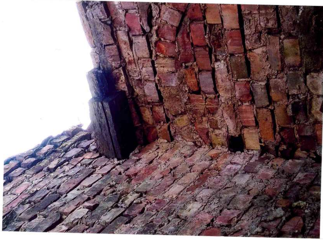
19. attēls. Dzīvojamās ēkas mūrlatas fragments. Iespējams, saglabājies no sākotnējās mūra saimniecības ēkas (atradusies tagadējās koka vietā 19.gs. b.).
