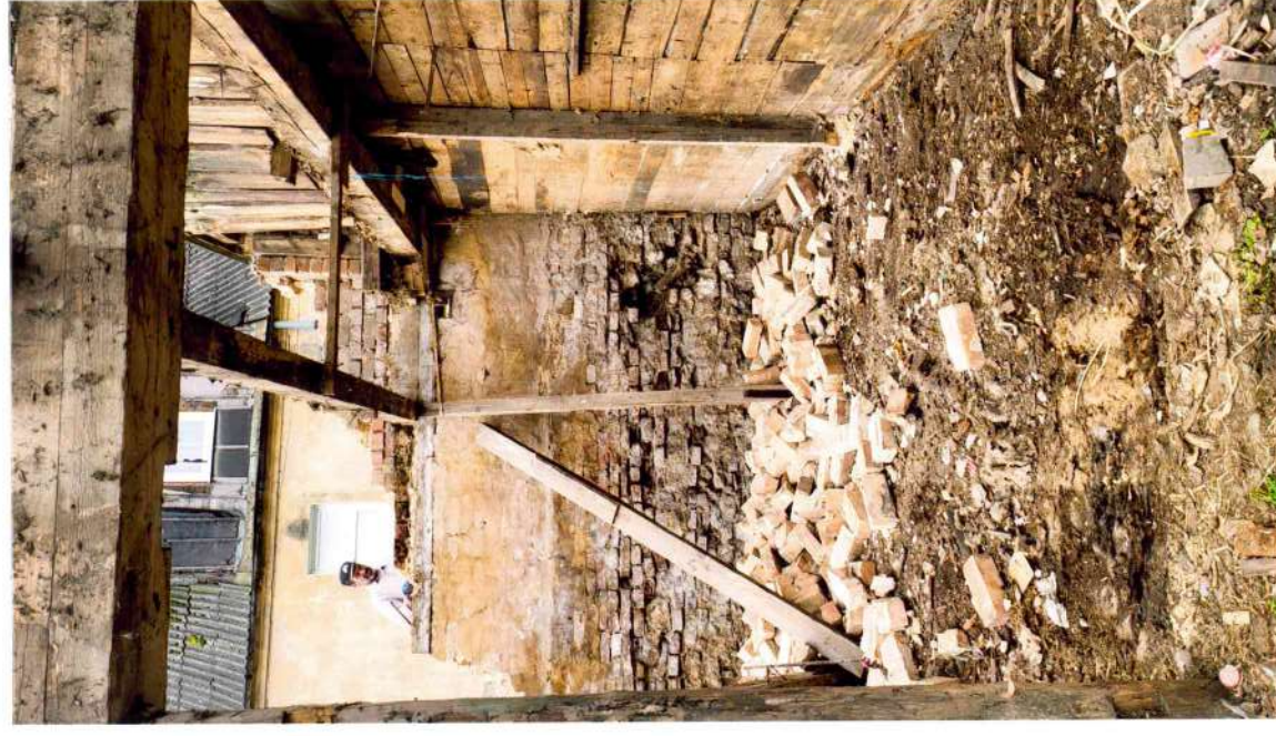
23. attēls. Saimniecības ēkas ārienesas ( mūra žogs pret Kalēju ielu) fragments (Rietumu daļa) ar koka pārseguma sijām no sākotnējās ēkas. Sienas apakšējā daļā erodējuši un izdrupuši ķieģeļi. Uzsākta mūra žoga bojātās daļas demontāža. Dzīvojamās ēkas nr.32 koka apjoma gala siena, kas bloķēta ar koka saimniecības ēku..
