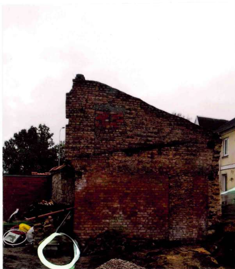
17. attēls. Dzīvojamās ēkas (kad.apz. 4001 0030081 004) R fasāde pēc saimniecības ēkas demontāžas. Siena mūrēta no dažādas markas (sekundāri izmantotiem) māla ķieģeļiem.
