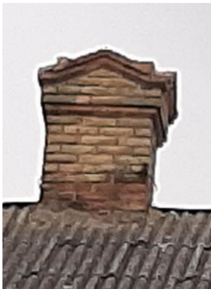
72. attēls. Ēkas pamatapjoma vēsturiskā skursteņa "galva"
