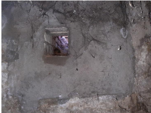
125. attēls. Aismūrēta logaila D sienā un ventilācijas lūka
