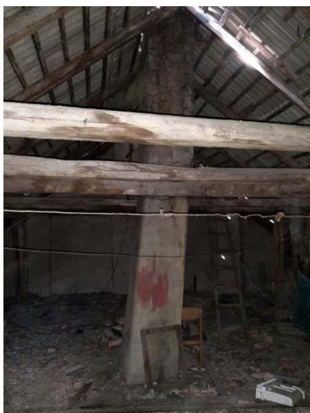
74. attēls. Slīpi izbūvētais skurstenis ēkas R daļā
