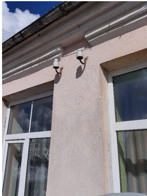
26. attēls. Divpakāpju jumta dzega un virslogu dzega
