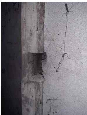
55. attēls. Vēsturiskais balķis izmantots kā statnis jumta konstrukcijā
