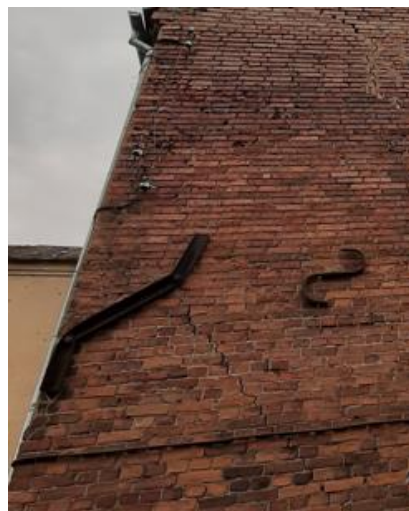
38. attēls. Metāla detaļas fasādē
