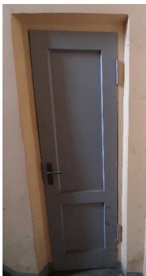
100. attēls. Pirmā stāva koka durvis uz piebūvi ( plānā D1/6), kurā atrodas gāzes apkures katls
