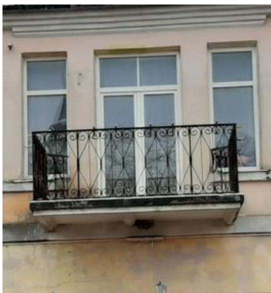
30. attēls. Balkons D fasādē
