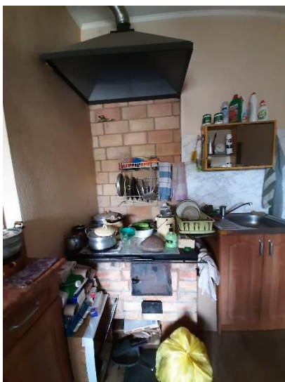
117. attēls. Plīts un sildmūris otrajā dzīvoklī
