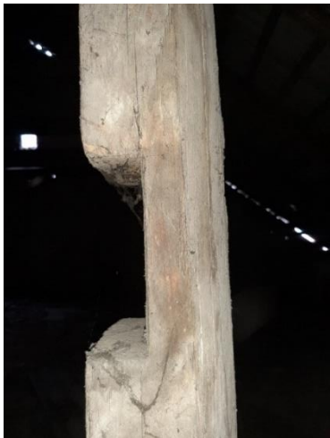
55. attēls. Vēsturiskais balķis izmantots kā statnis jumta konstrukcijā
