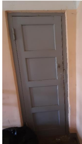
103. attēls. Durvis uz piebūvi otrajā stāvā
