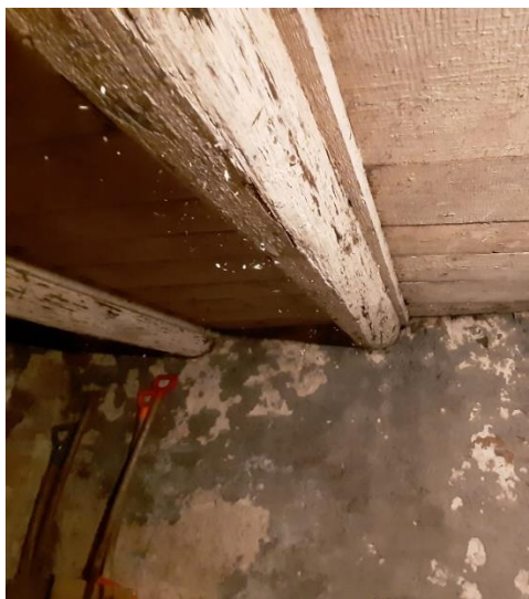
128. attēls. Pagraba griestu pārseguma sijas un dēļu klājs virs tām
