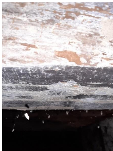
129. attēls. Melna un balta krāsojuma paliekas uz pārseguma sijas pagrabā
