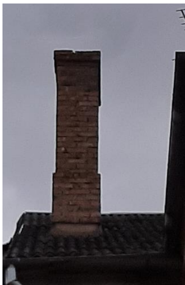
76. attēls. A puses skurstenis, izbūvēts cauri abiem ēkas stāviem
