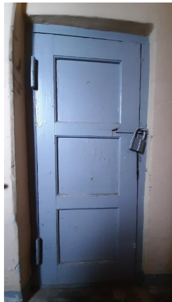
99. attēls. Pirmā stāva durvis uz telpu zem kāpnēm (plānā D1/5)
