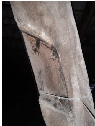
58. attēls. Vēsturiskais balķis izmantots kā statnis jumta konstrukcijā
