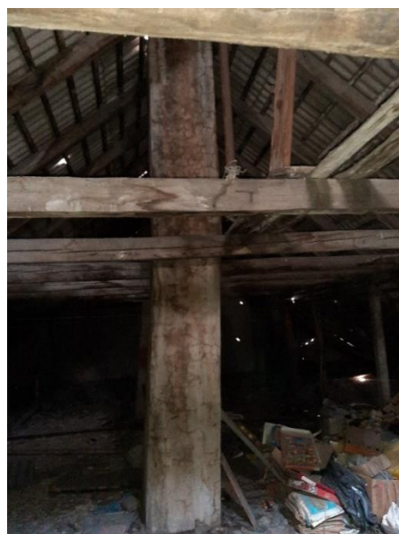
75. attēls. Slīpi izbūvētais skurstenis ēkas A daļā
