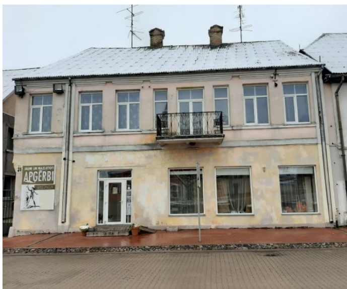
23. attēls. Ēkas kopskats no Rīgas ielas puses
