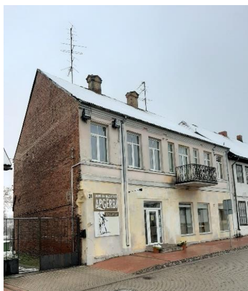
24. attēls. Ēkas R un D fasāde
