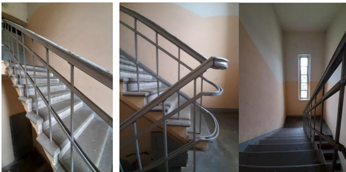
119. attēls. Kāpnes uz ēkas otro stāvu
