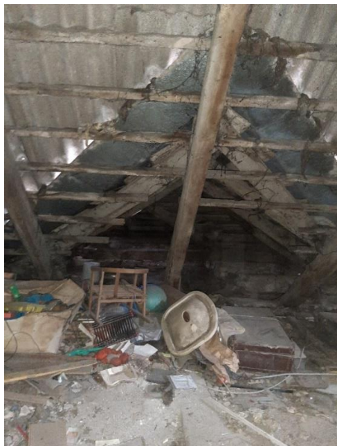
62. attēls. Skats uz Z. Redzamas izzāgētās pamatkorpusa jumta lats un piebūves jumta konstrukcija
