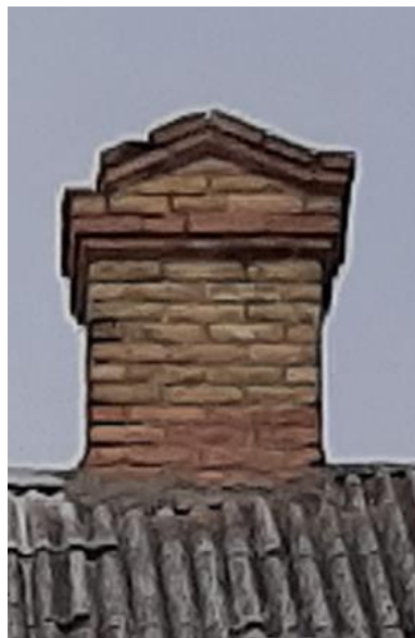
73. attēls. Ēkas pamatapjoma vēsturiskā skursteņa "galva"
