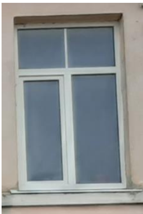
82. attēls. Tips nr. 1. Daļēji verams vienas vērtnes trīsdalīgs balts PVC logs ar vertikālu dalījumu loga augšdaļā – L2/1, L2/2, L2/3, L2/6, L2/7, L2/9, L2/10, L2/11,
