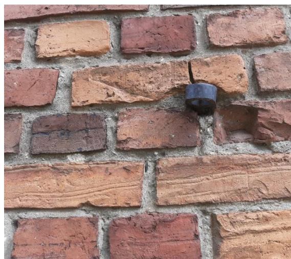
40. attēls. Vārtu stiprinājuma cilpa R sienā
