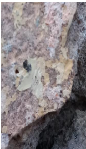
32. attēls. Dzeltenā krāsojuma paliekas pirmā stāva fasādē
