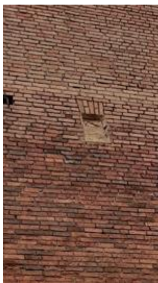
36. attēls. Aizmūrētais ventilācijas lodziņš R sienā
