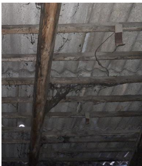
60. attēls. Latojums, virs kura ieklāts padomju laika viļņotais “šīferis”
