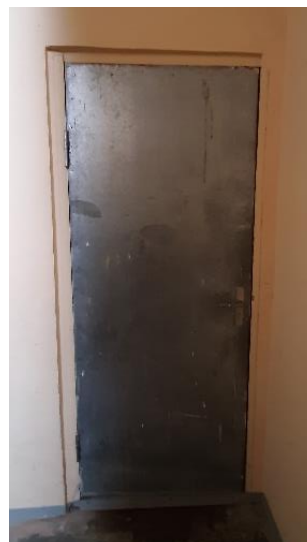
101. attēls. Pirmā stāva metāla durvis uz tirdzniecības telpu ( plānā D1/7)
