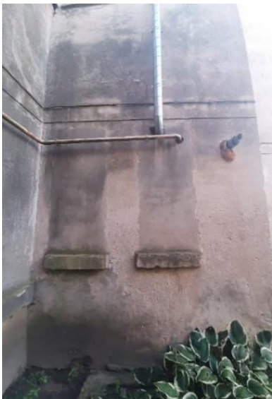
88. attēls. Aizmūrētās logailas A sienā pirmajā stāvā.
