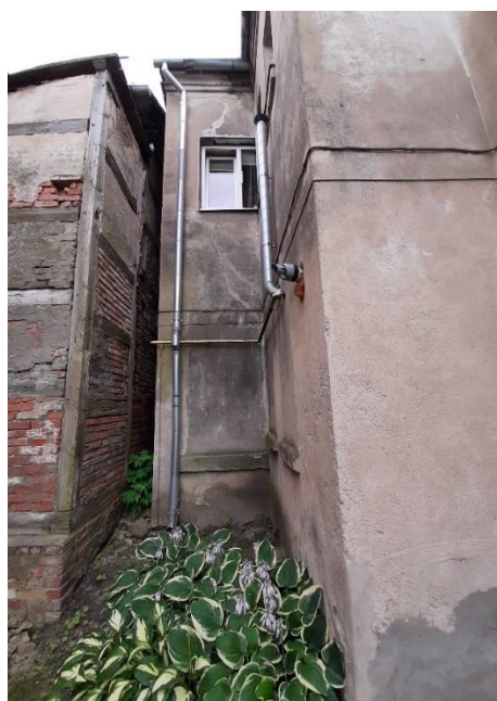
43. attēls. Pagalma fasāde ar blakusēku
