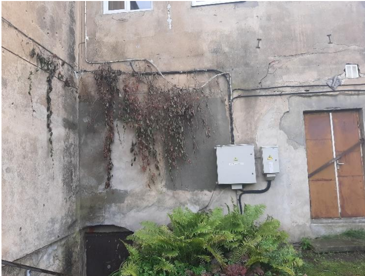
86. attēls. Pēc 1967. gada aizmūrētās logailas pagalma fasādē.
