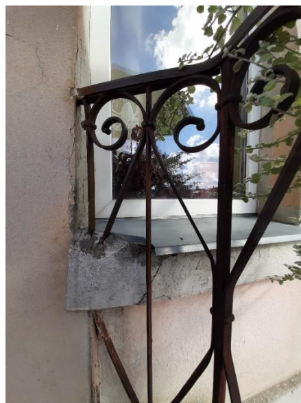
31. attēls. Balkona stiprinājuma vieta ēkas sienā
