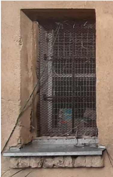
90. attēls. Verams vienas vērtnes divdaļīgs koka logs R fasādes pirmajā stāvā, L1/4
