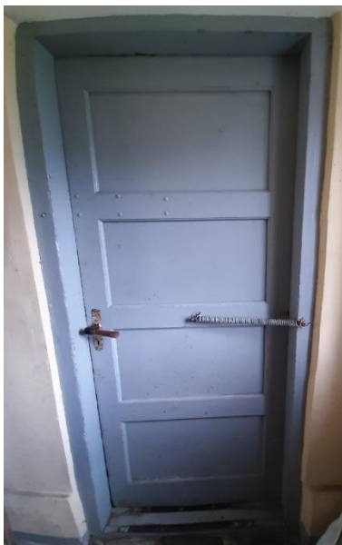
98. attēls Pirmā stāva durvis uz kāpņu telpu (plānā D1/4)
