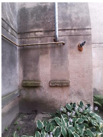
44. attēls. Aizmūrētās logailas ēkas piebūves A sienā
