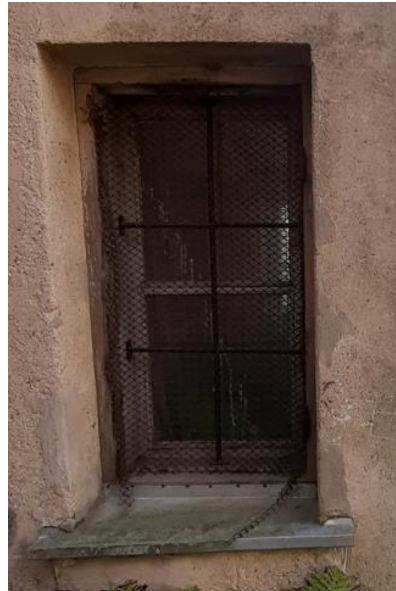
91. attēls. Verams vienas vērtnes divdaļīgs koka logs A fasādes pirmajā stāvā, L1/5
