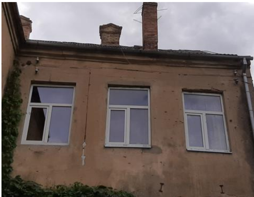
84. attēls. Otrā stāva logi pagalma fasādē. Plānā L2/9, L2/10, L2/11
