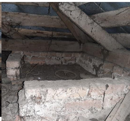
65. attēls. Ķieģeļu mūrējums piebūves daļā
