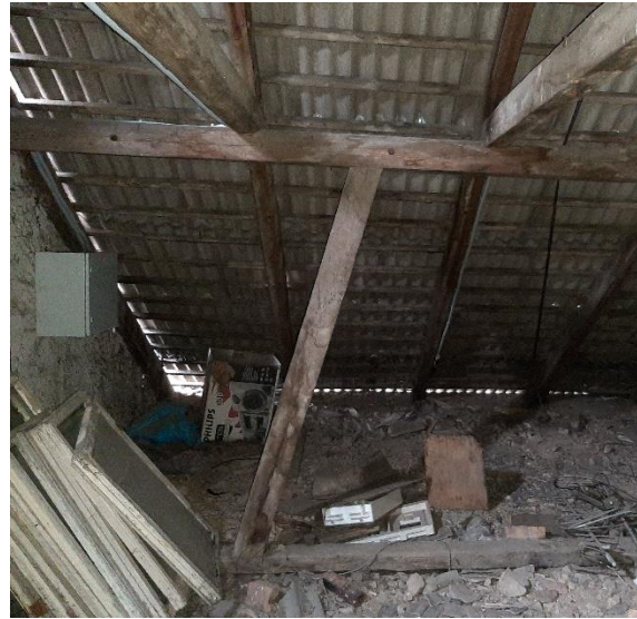
50. attēls. Pamatapjoma jumta konstrukcijas kopskats uz D
