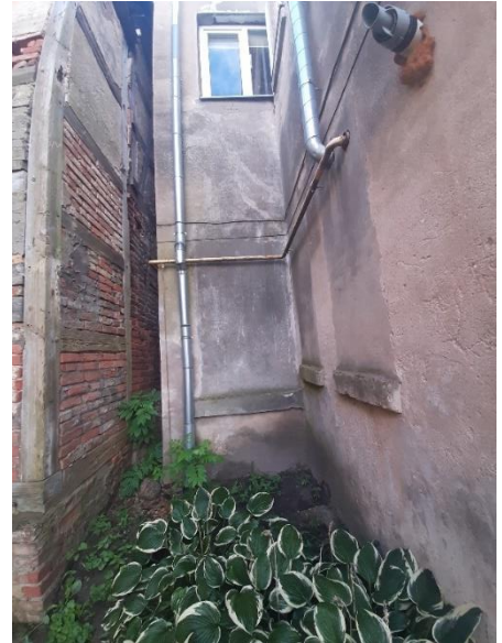
87. attēls. Pēc 1967. gada aizmūrētās logaila Z fasādē.
