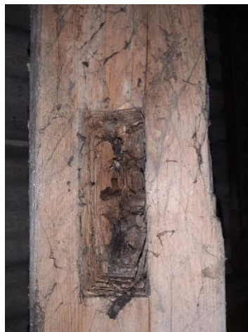
56. attēls Vēsturiskais balķis izmantots kā bendele jumta konstrukcijā
