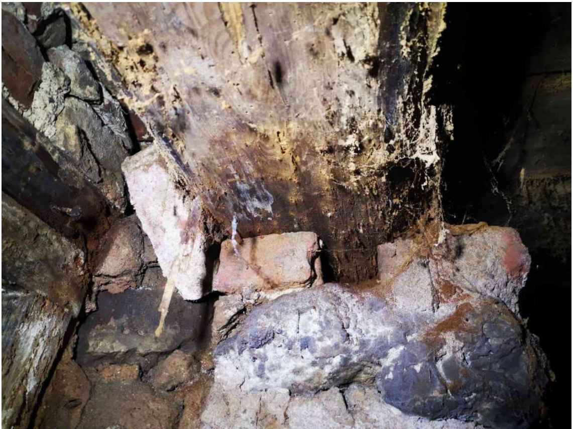
29.fotoattēls Satrupējis pagraba pārseguma pasiju balstmezglis.
