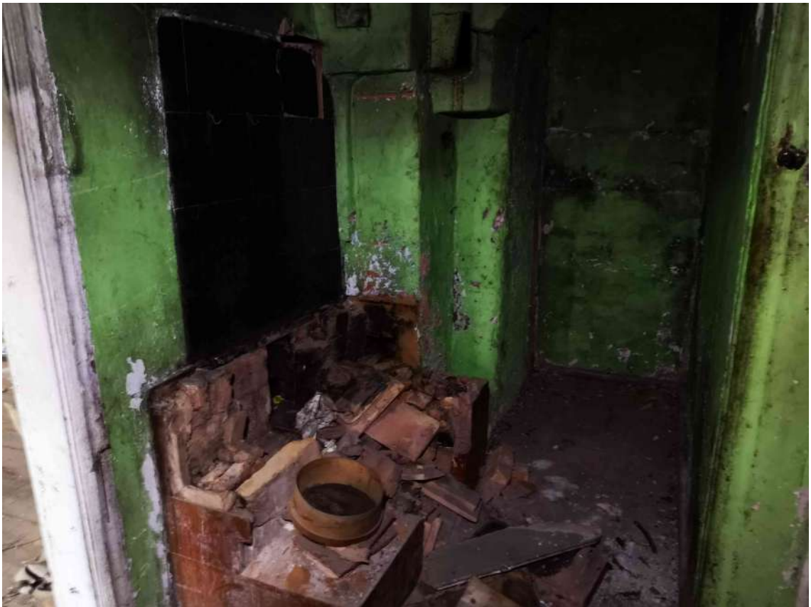
50.fotoattēls Izdemolētas plīts konstrukcijas 2.stāvā.
