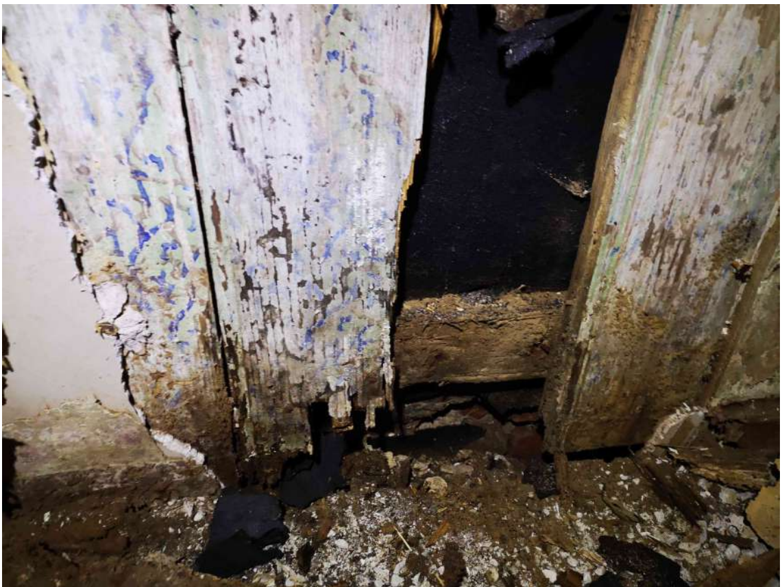
58.fotoattēls Satrupējuši telpas apdares dēļu fragmenti 1.stāvā.
