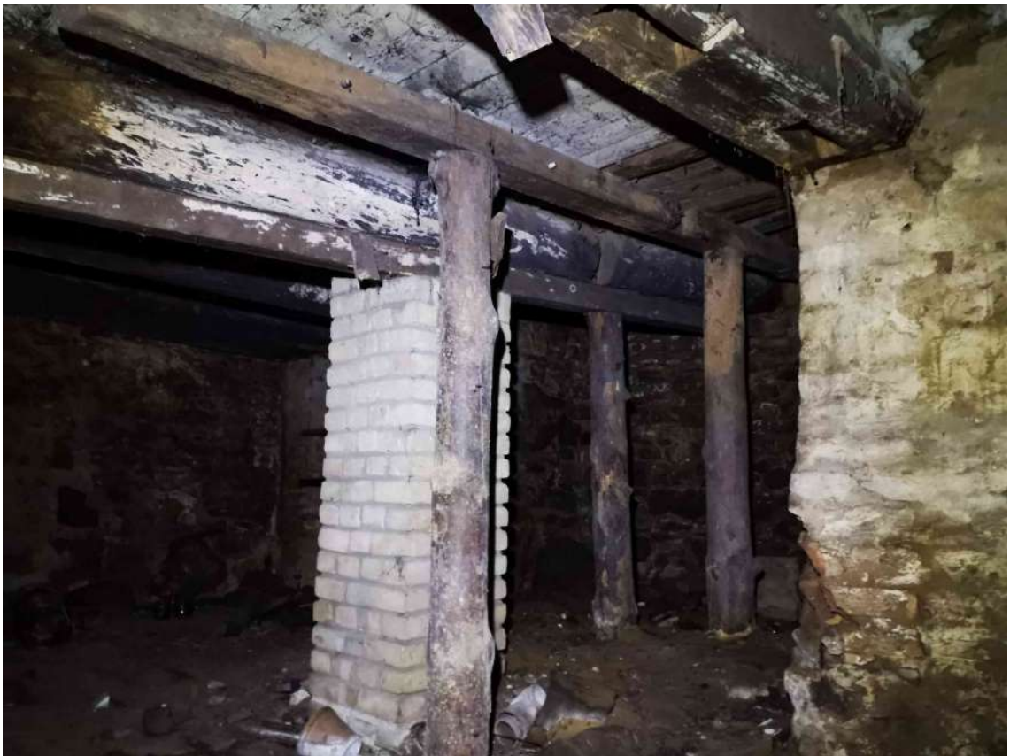
19.fotoattēls Sekundāri izbūvētas pagraba pārseguma pasijas un statī.
