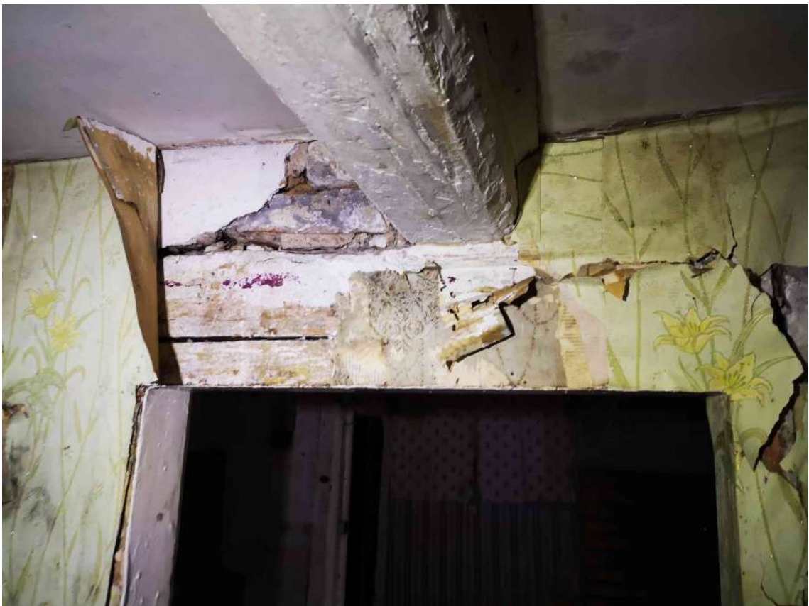
44.fotoattēls Pārseguma pasijas balstmezglis virs durvju ailas.
