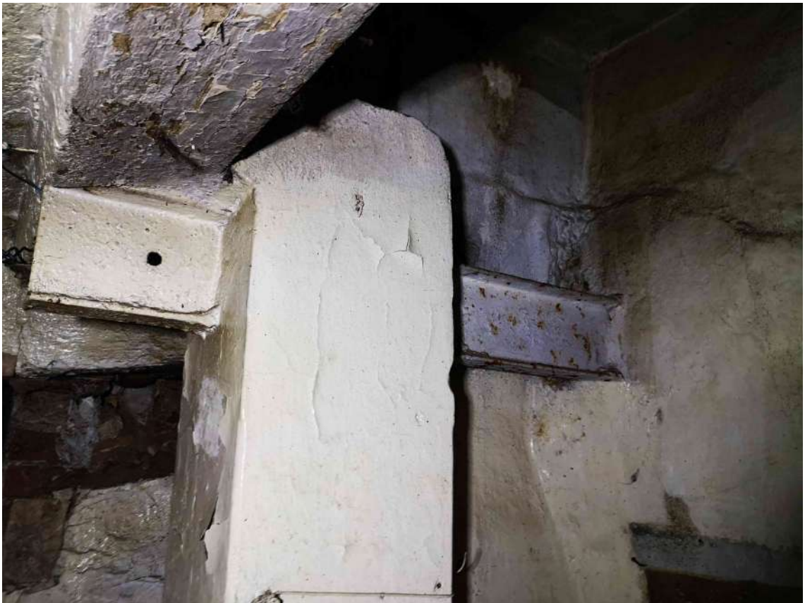
41.fotoattēls 1.stāva pārsegumu pasijas balstmezls.
