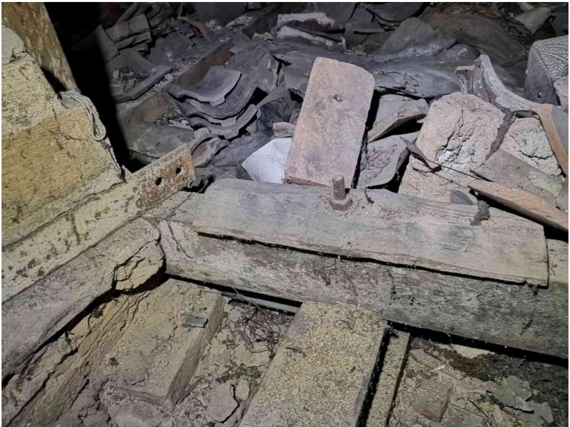
68.fotoattēls 2.stāva pārseguma siju un jumta krēsla apakšējā koptura savienojuma mezgls ar bultskrūvi.
