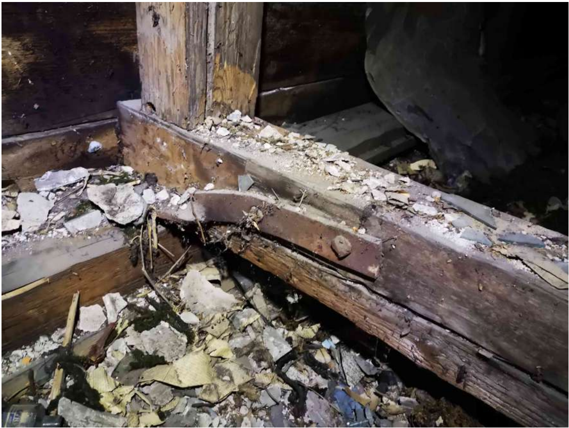
69.fotoattēls Jumta krēsla apakšējā koptura iesējuma mezgls ārsienā.
