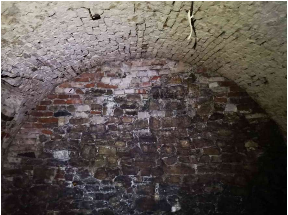
22.fotoattēls Mucveida velves konstrukcija A puses pagraba telpā.
