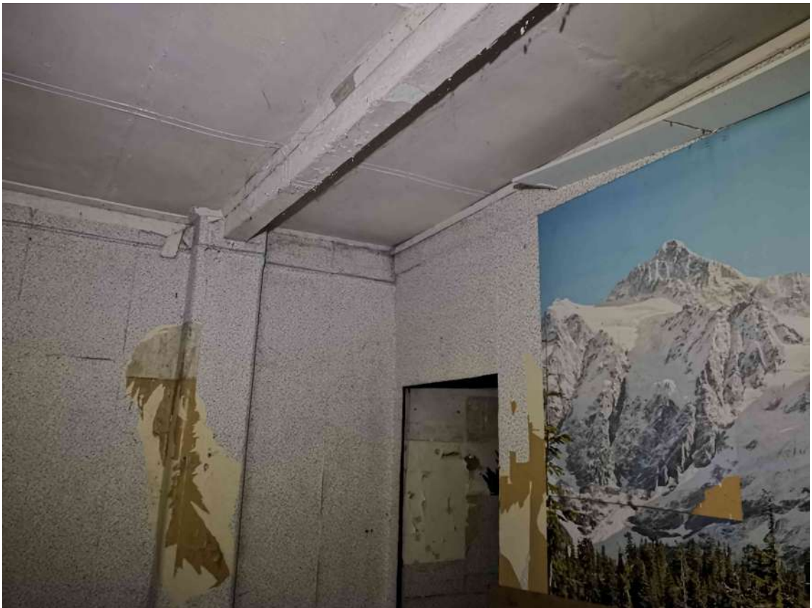
57.fotoattēls 1.stāva pārseguma siju pasijas konstrukcija.
