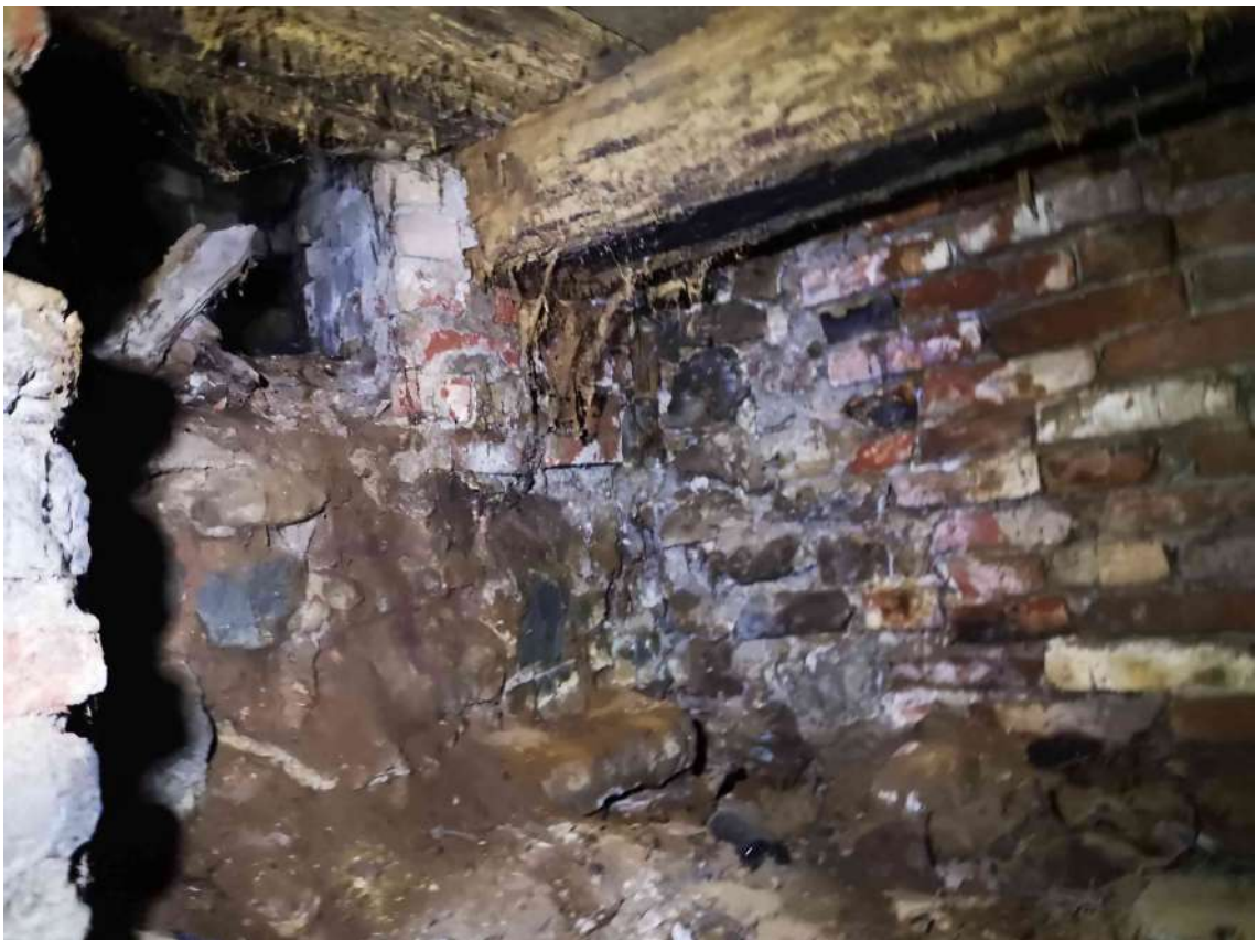
28.fotoattēls Satrupējis pagraba pārseguma pasiju balstmezglis.
