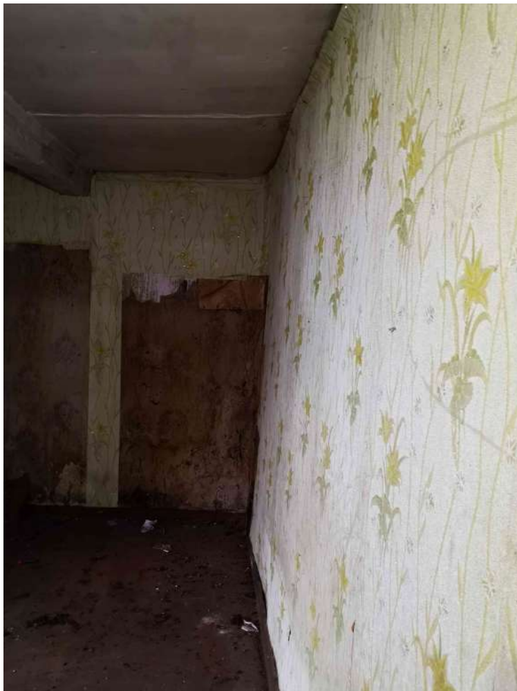
46.fotoattēls 1.stāva starpsienas deformācijas. Nobīdes no vertikalitātes.
