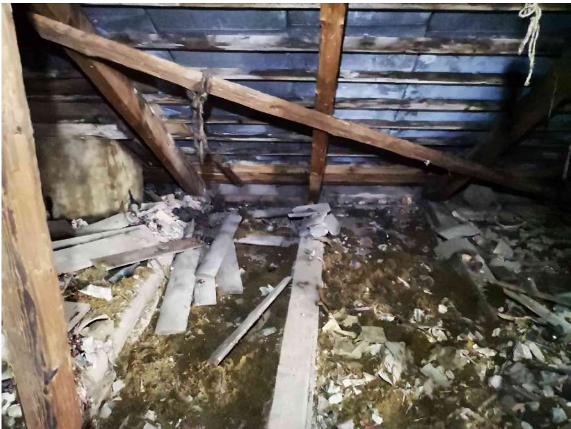
73.fotoattēls Jumta stinguma diagonālelementi pie spāru apakšējām virsmām.
