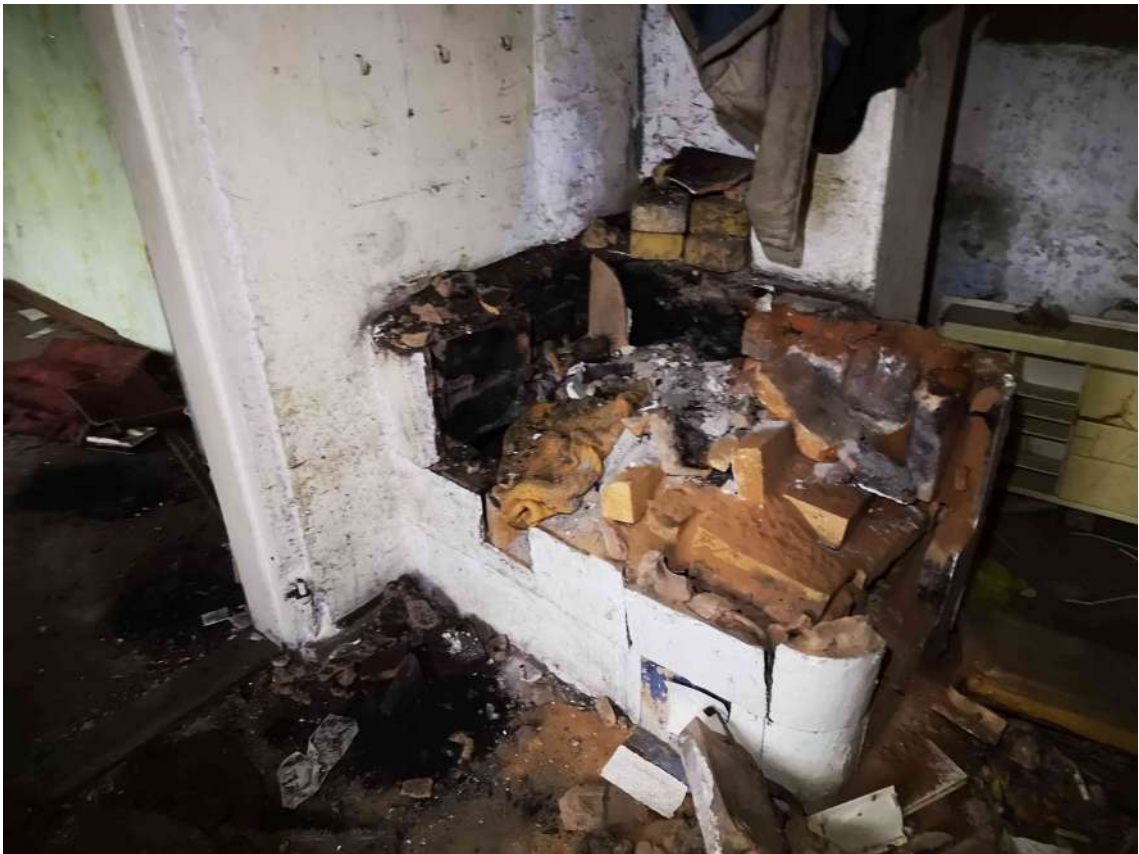
45.fotoattēls Izdemolētas plīts konstrukcijas.
