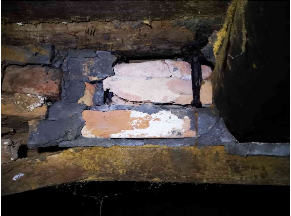
30.fotoattēls Satrupējis un deformējies ailas pārsedzes fragments. Korodējis 1.stāva sienas enkurojums.
