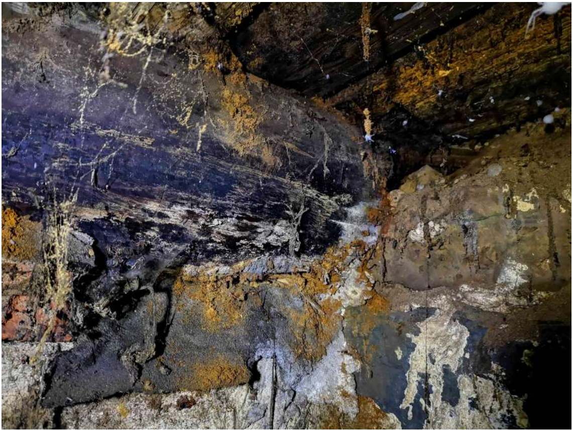
27.fotoattēls Satrupējis pagraba pārseguma pasiju balstmezglis.
