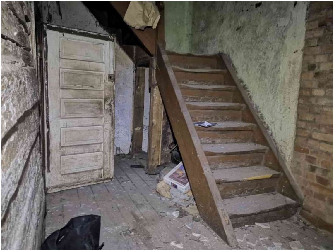
47.fotoattēls Kāpņu konstrukcija uz 2.stāvu.
