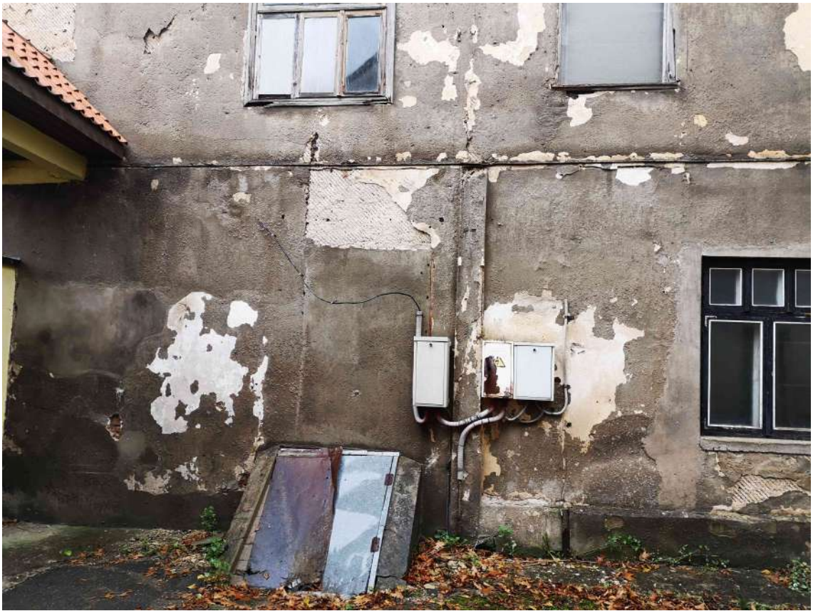
5.fotoattēls Skats uz D puses fasādi.
