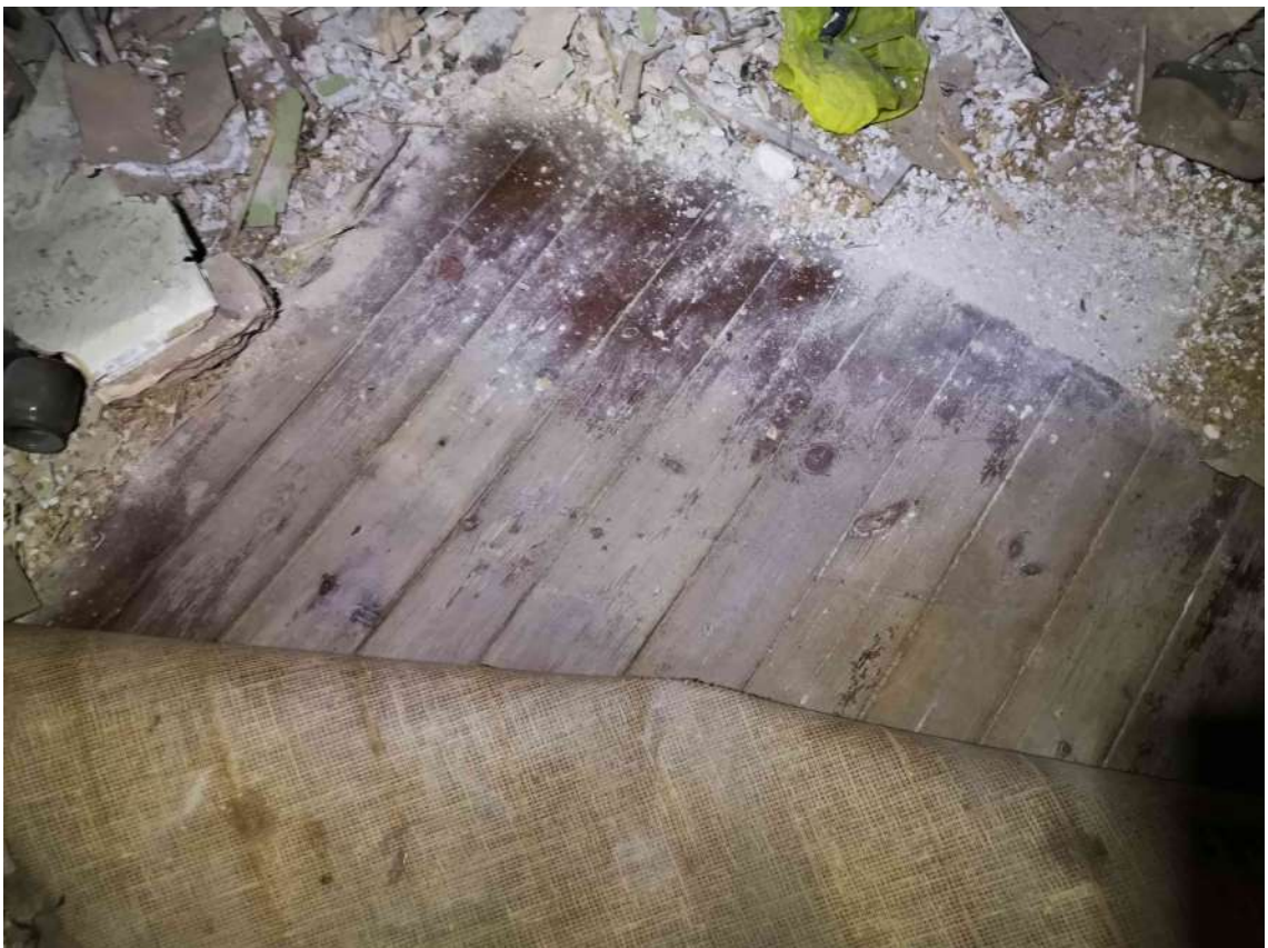
62.fotoattēls 2.stāva grīdas dēļu konstrukcija.
