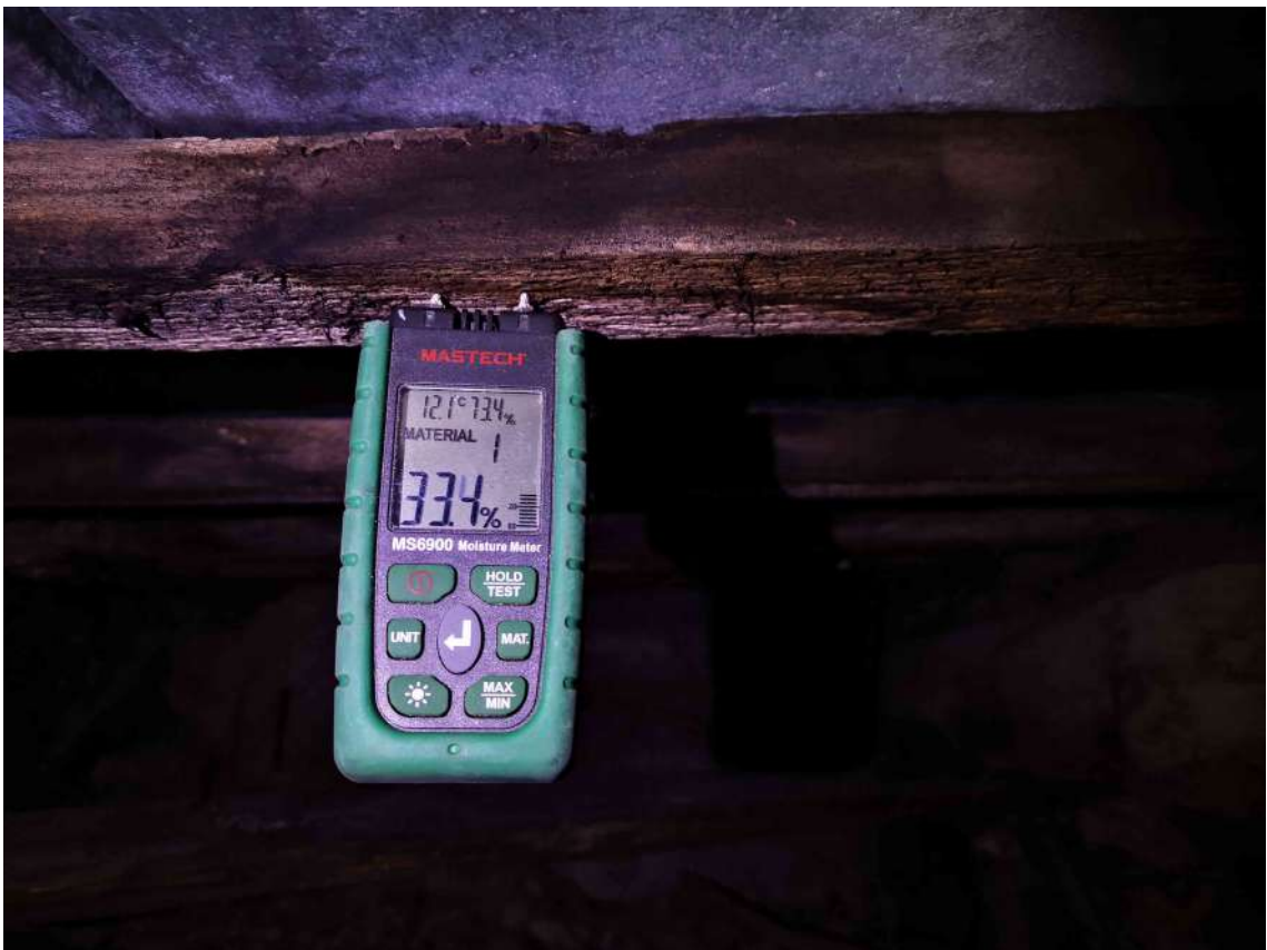
76.fotoattēls Jumta latojuma mitruma mērījumi.
