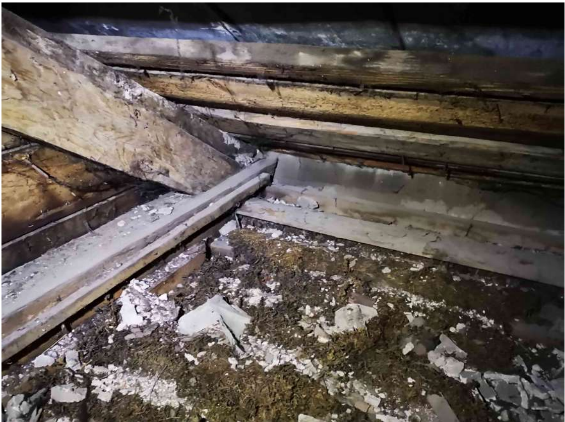
70.fotoattēls Spāru balstmezgls. Starpsiju aizpildījums ar sūnām.
