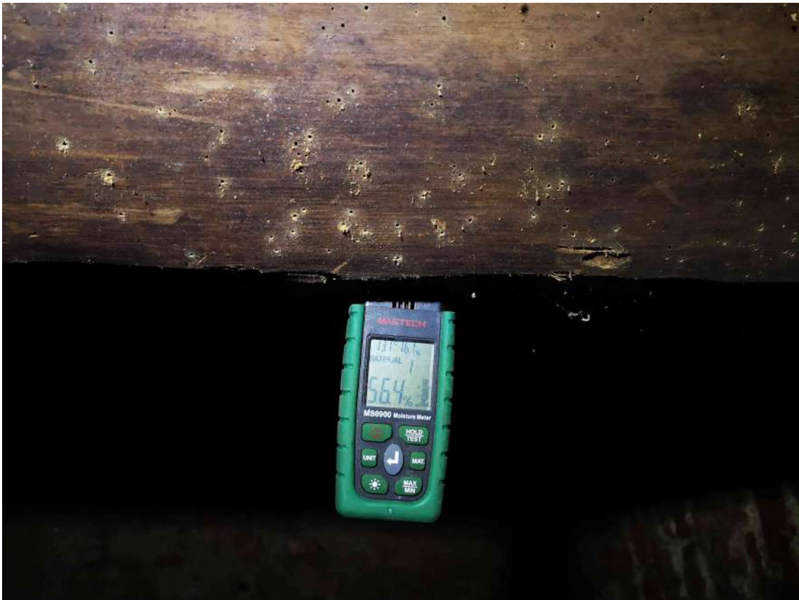
39.fotoattēls Pagraba pārseguma nesošo konstrukciju mitruma mērījumi.
