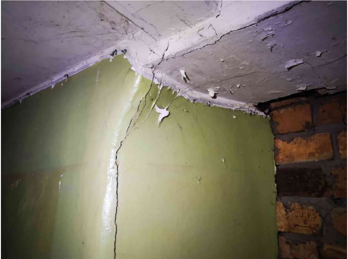
52.fotoattēls 2.stāva pārseguma pasijas balstmezgls. Mezgla sēšanās deformācijas.
