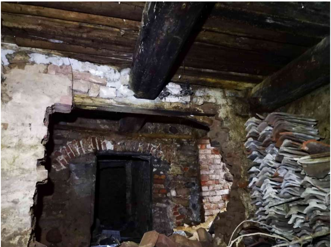
18.fotoattēls Lokāli demontēti mūra sienas posmi.
