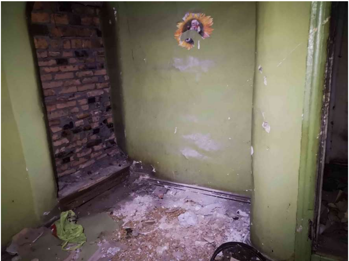
51.fotoattēls Aizmūrēta aila uz ēkas Z puses būvapjoma telpām.
