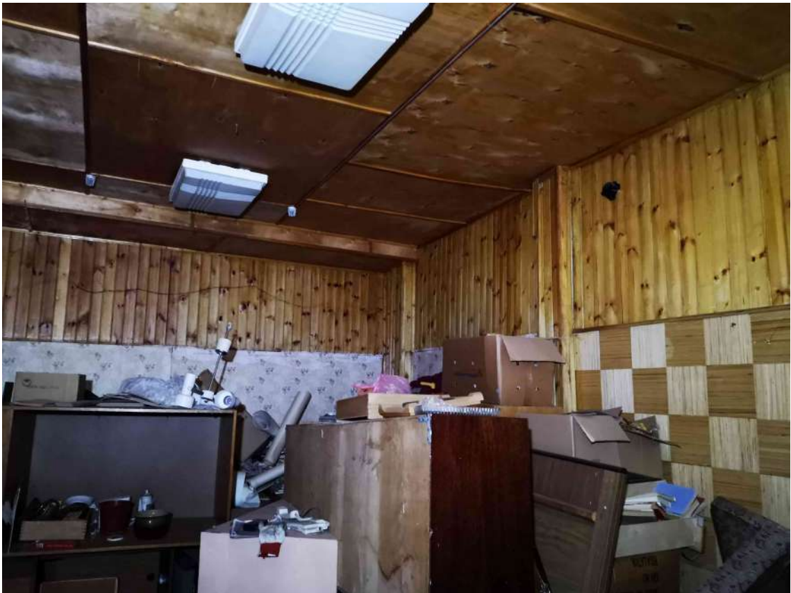
55.fotoattēls Sekundāri izbūvēta 1.stāva iekšsienu un griestu apdare.
