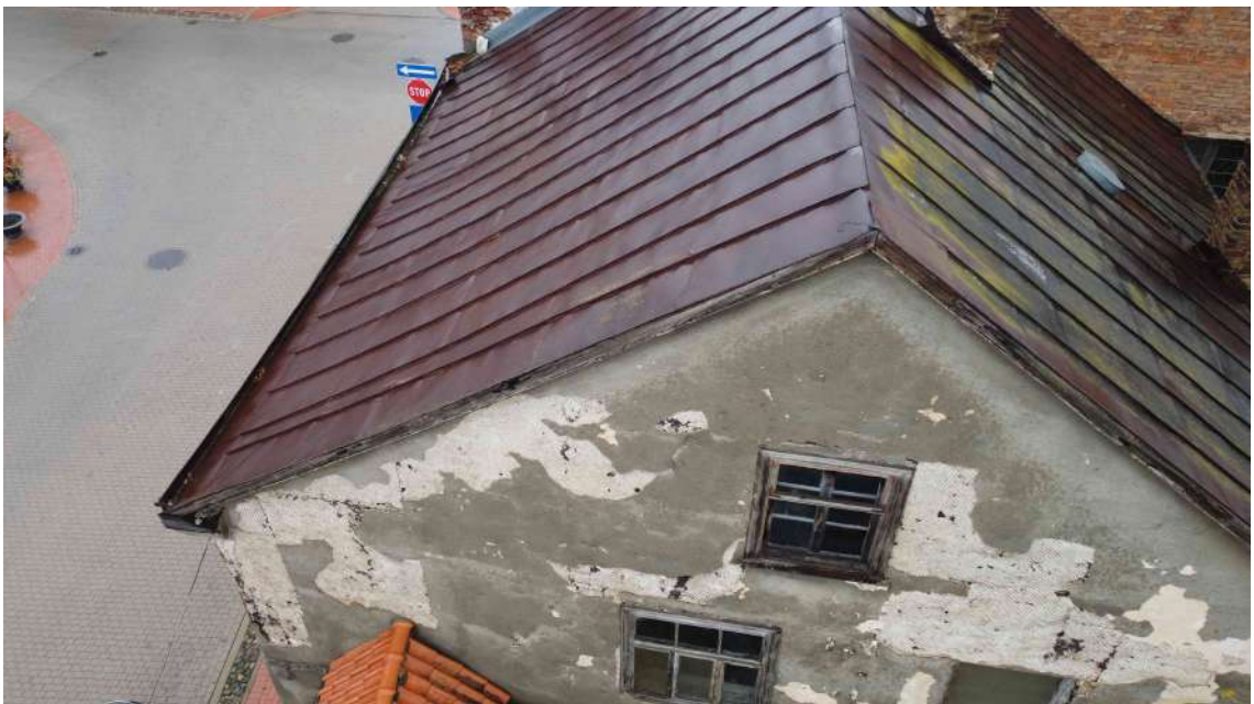
4.fotoattēls Skats uz D puses fasādi.
