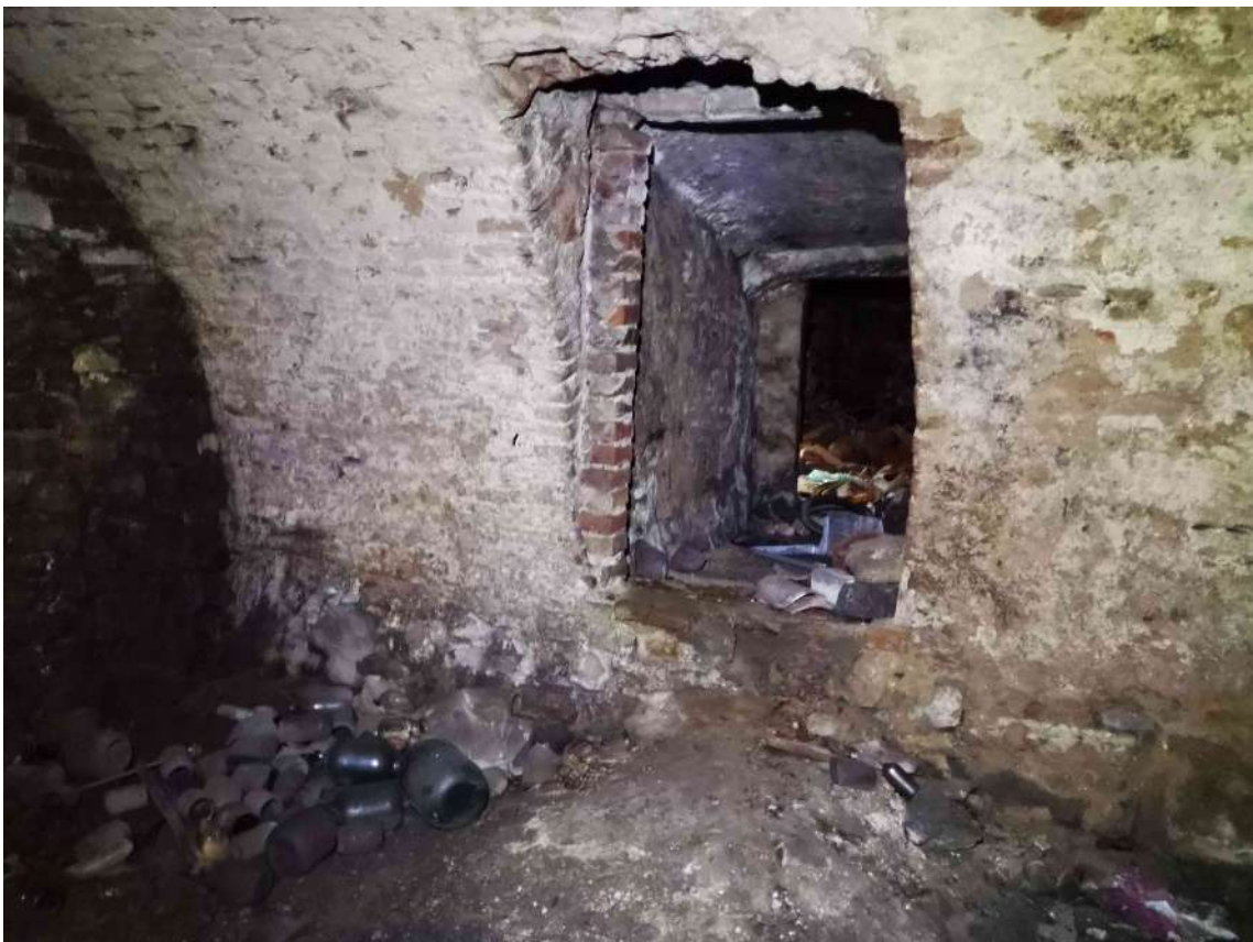
23.fotoattēls A puses pagraba telpas ieejas ailas konstrukcijas.
