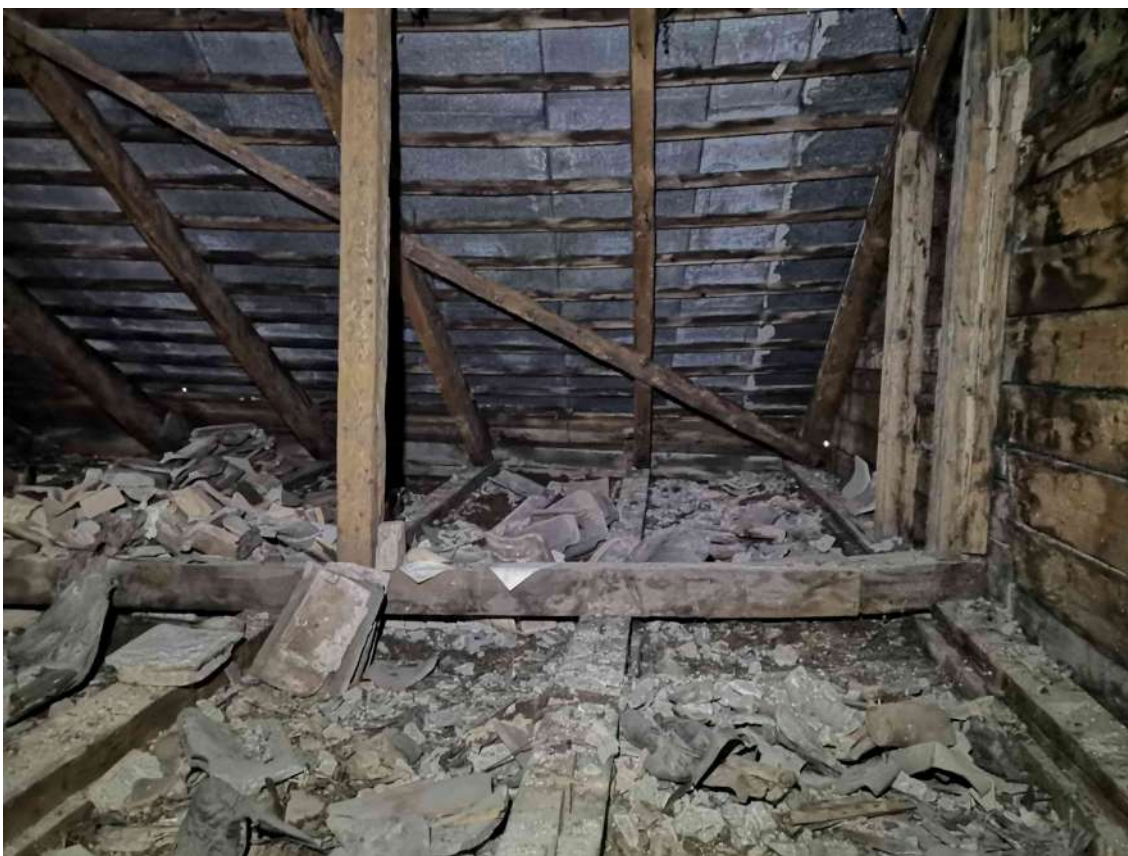
65.fotoattēls Deformēts/izliecies jumta krēsla apakšējā koptura elements.
