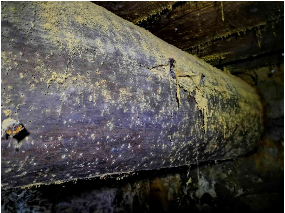
31.fotoattēls Kokgraužu radīti pagraba pārseguma pasijas bojājumi.
