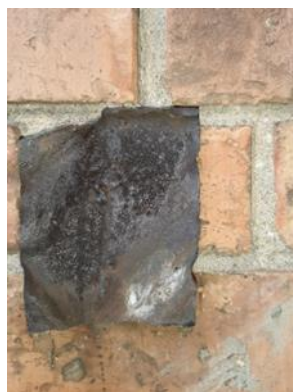
38. attēls. Metāla detaļa DA fasādē
