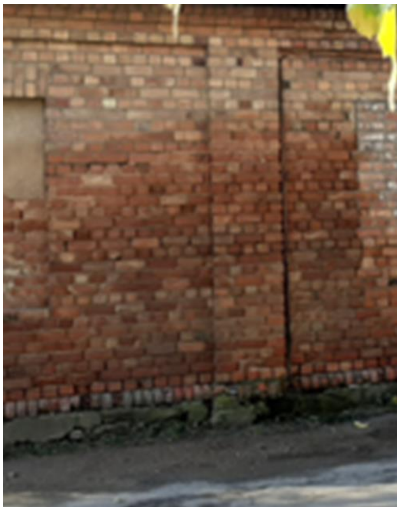
28. attēls. Oriģinālās logailas apmetuma fragments ar melnā ķieģeļu šuvējuma paliekām
