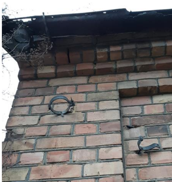
75. attēls. Notekcauruļu stiprinājumi ēkas ielas fasādē
