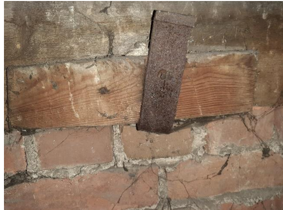
21. attēls. Mūra enkura stiprinājums ēkas bēniņos. Nav redzamu pēdu, ka būtu bijusi savilce uz ZR sienu
