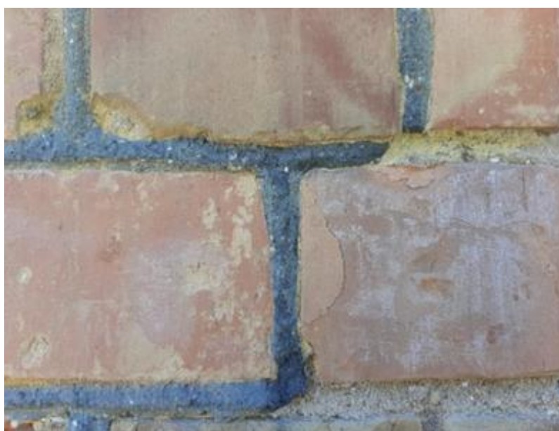
27. attēls. Fragments ar dzeltenās krāsas paliekām un melno šuvojumu ZA fasādē
