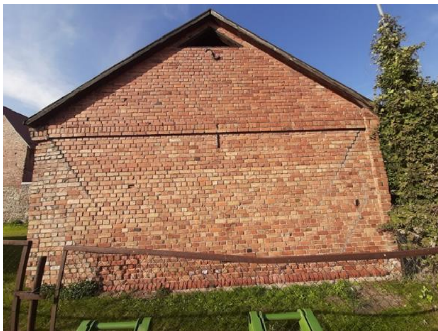
31. attēls. Ēkas DA siena, vērsta pret Plūdoņa ielu
