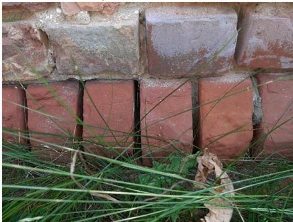
24. attēls. Ēkas pamati DR fasādē
