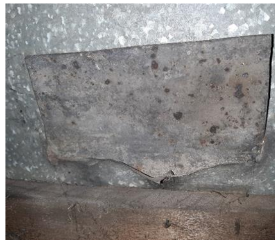
72. attēls. Šāviņu radīto jumta bojājumu labojums
