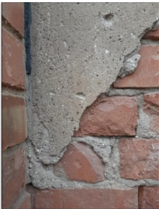
28. attēls. Oriģinālās logailas apmetuma fragments ar melnā ķieģeļu šuvējuma paliekām
