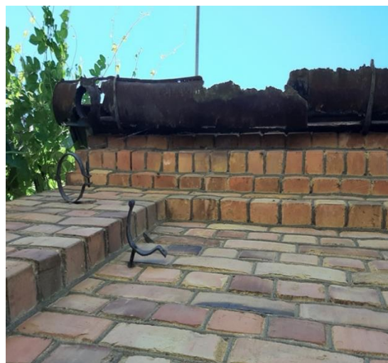
74. attēls. Notekcaurule un stiprinājumi ielas fasādē
