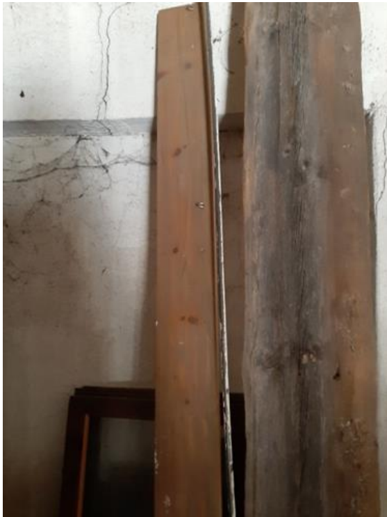
100. attēls. Apmestā un balsinātā durvju aila telpā nr. 2
