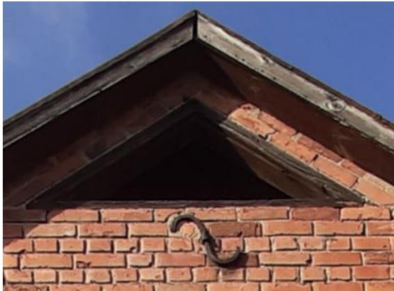
20. attēls. Ventilācijas logs ar S veida mūra enkuru DA fasādē
