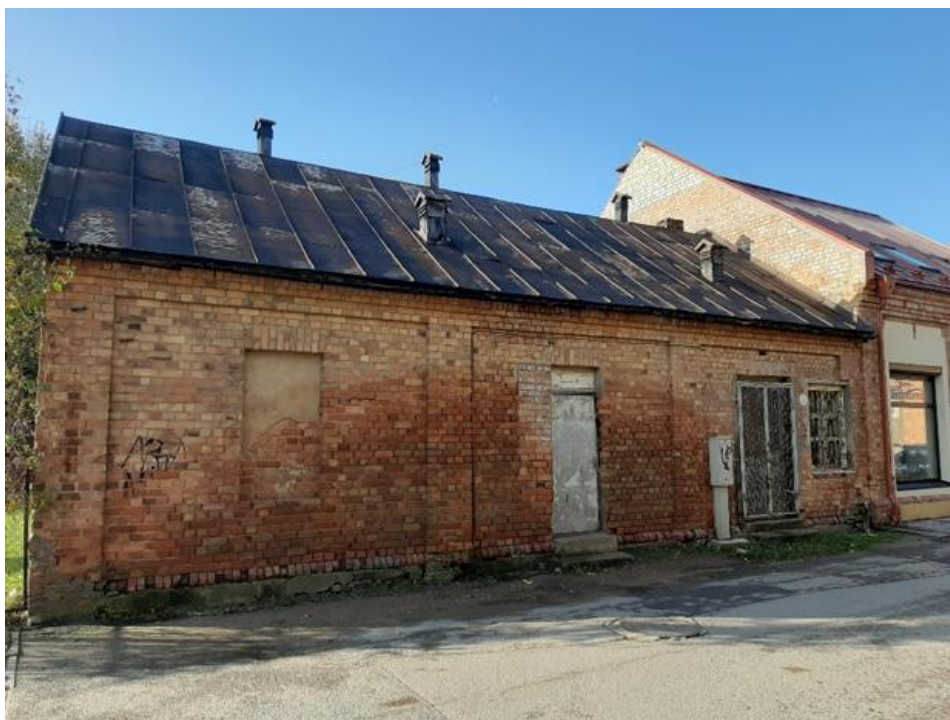
26. attēls. Ēkas ielas ZA fasāde
