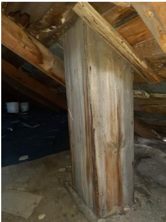
84. attēls. Koka ventilācijas skurstenis
