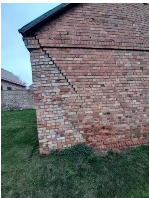
39. attēls. Nobrukušā stūra labojums ar ķieģeļiem DA fasādē
