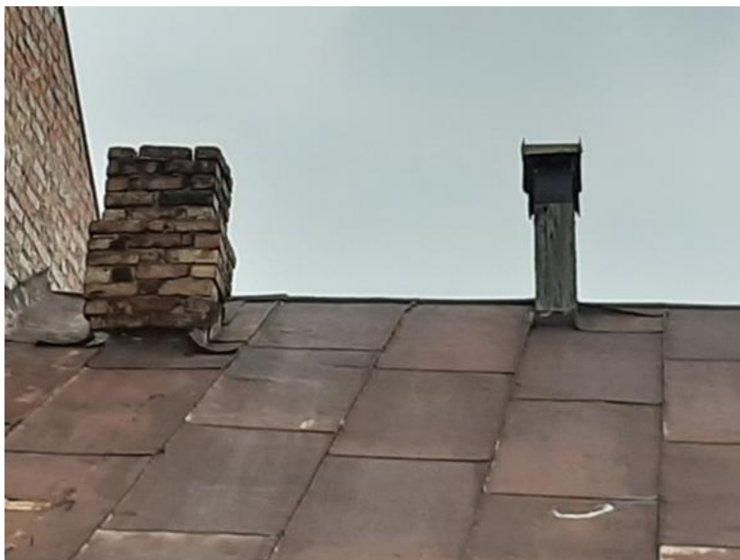
80. attēls. Jumta segums no pagalma puses. Redzams apkures skurstenis un viens no pieciem ventilācijas skursteņiem
