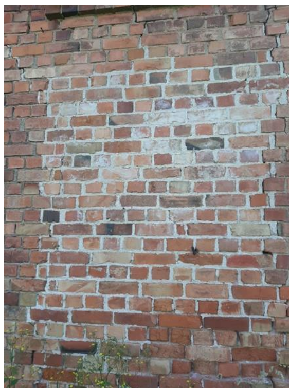
53. attēls. Aizmūrētā pagaidu loga vieta
