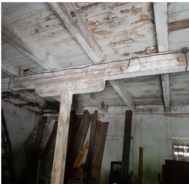
96. attēls. Sija ar balsta stabu telpas centrā telpā nr. 2
