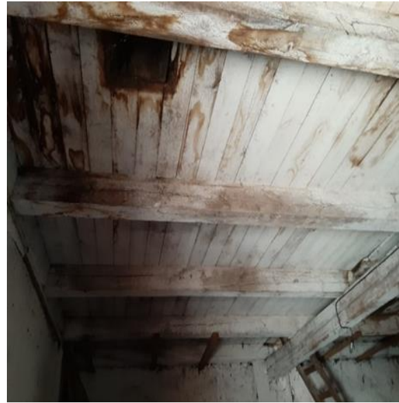
87. attēls. Ventilācijas skursteņa atvere griestos telpā nr. 2
