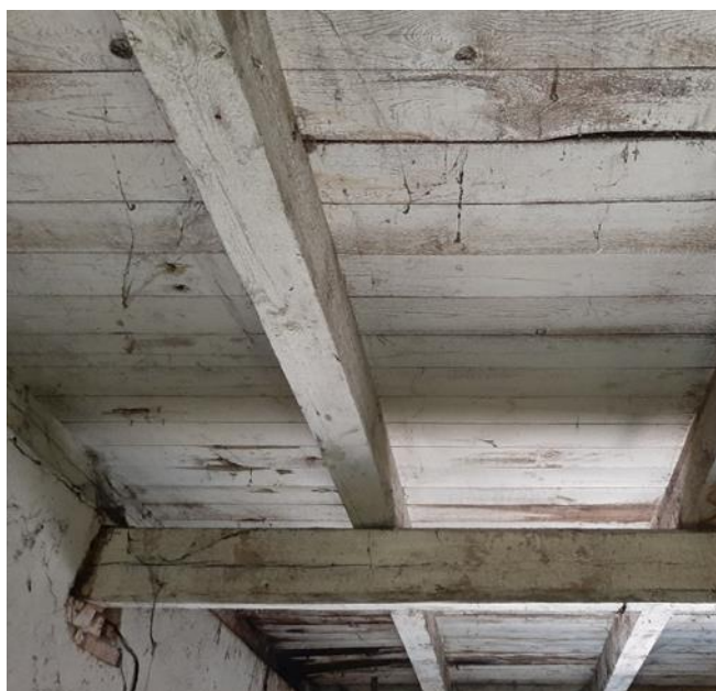
95. attēls. Griesti, sijas un balsināto dēļu pārsegums telpā nr. 2
