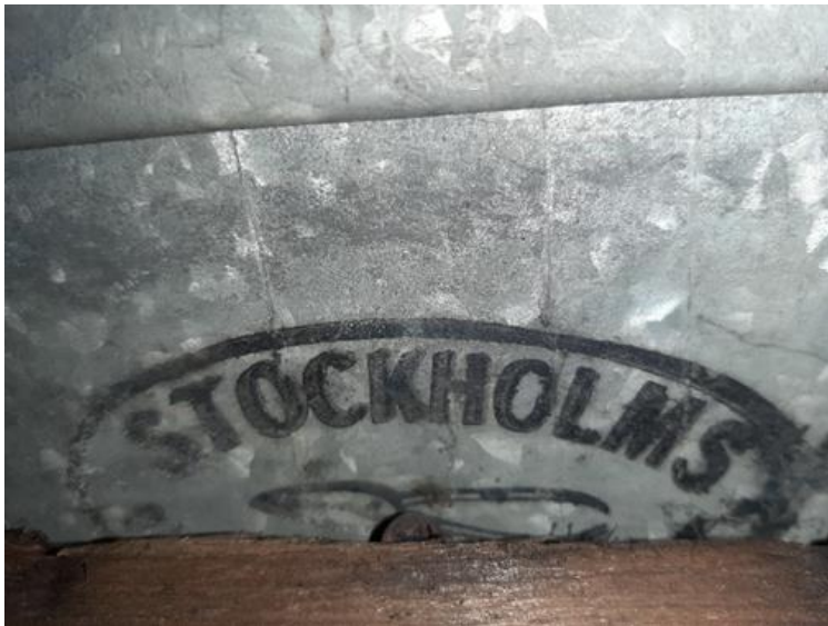
67. attēls. Jumta skārda firmas zīmoga fragments
