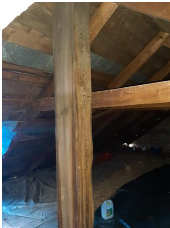
85. attēls. Koka ventilācijas skurstenis
