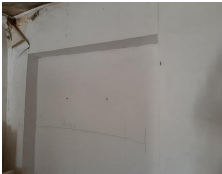
93. attēls. Aizmūrētā durvju aila uz pagalma pusi
