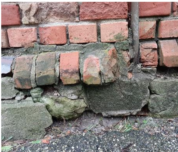
22. attēls. Ēkas pamati ielas fasādē
