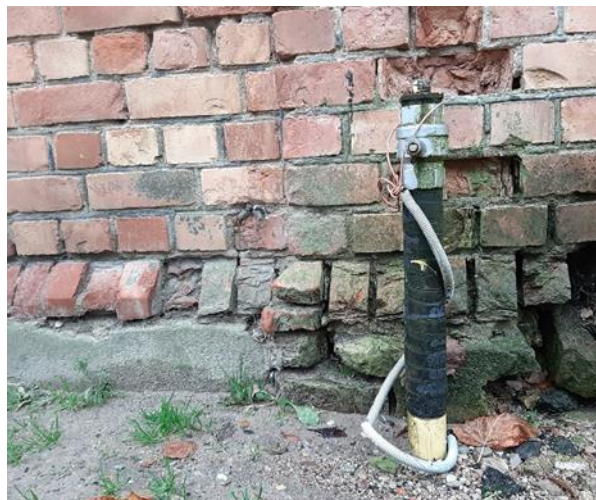
23. attēls. Ēkas pamati ielas fasādē
