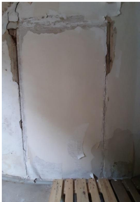
89. attēls. Aizmūrētā durvju aila, kas savieno telpu nr. 1 un nr. 2. Skats no telpas nr. 1 puses
