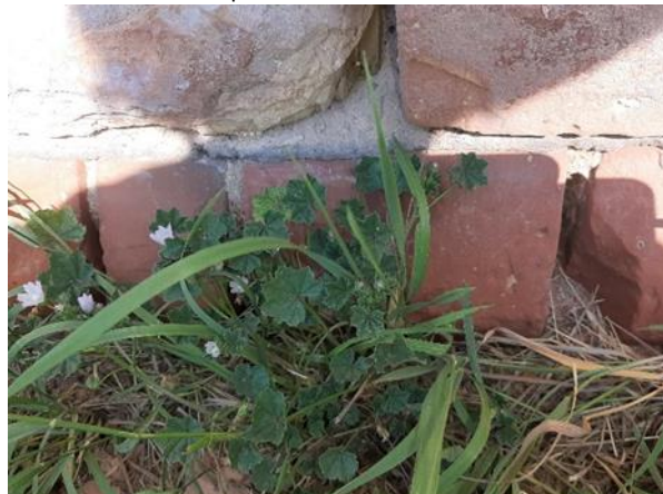
25. attēls. Ēkas pamati DA fasādē
