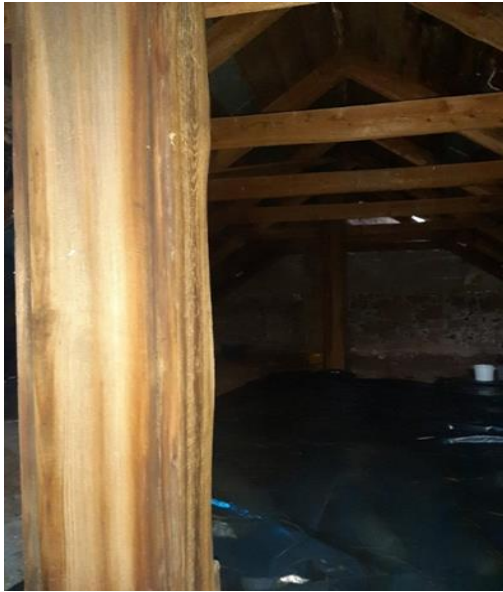
86. attēls. Koka ventilācijas skurstenis
