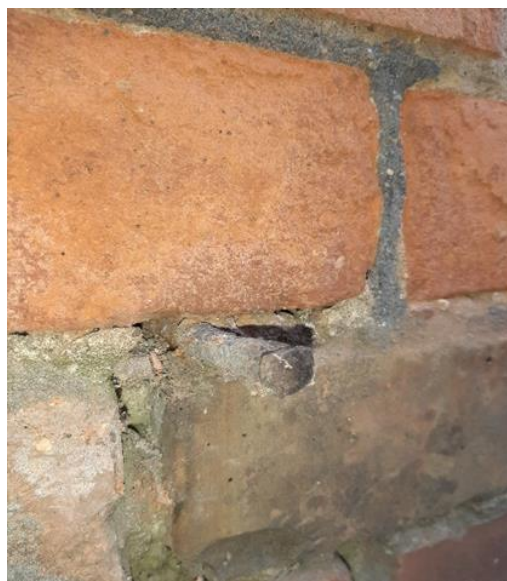
76. attēls. Notekcauruļu stiprinājumi ēkas ielas fasādē
