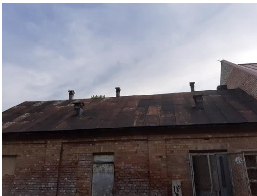
64. attēls. Jumta segums no ielas puses
