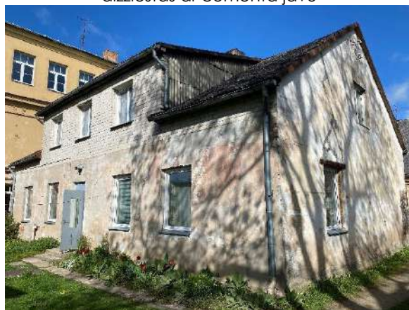
F - 130 Pagalma puses un A puses gala fasāde. Pirmā stāva līmenī ārsienas apmestas, otrajā stāvā – neapmests silikātķieģeļu mūris
