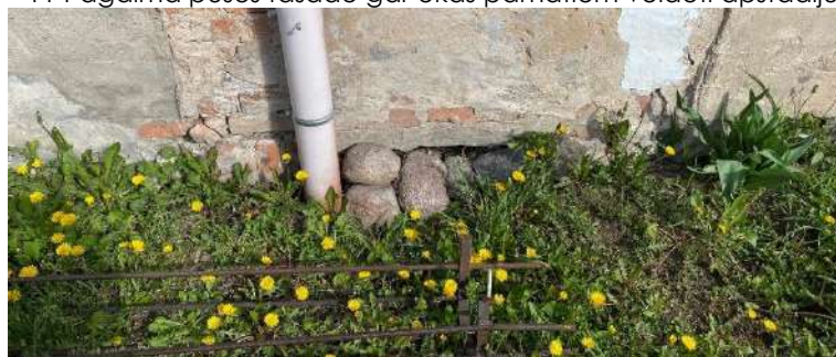
F - 12 Zonā, kur likvidēta pagraba ieeja, nav izbūvēta nokrišņu novadapmale un nodrošināti pareizi zemes virsmas kritumi, nokrišņu ūdens brīvi var ieplūst aizbērtajā pagrabā
