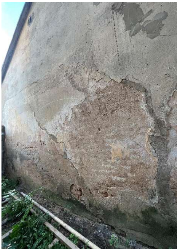
F - 31 Diagonālas plaisas, apdares bojājumi un mitruma piesātinājums ēkas R puses gala sienā
