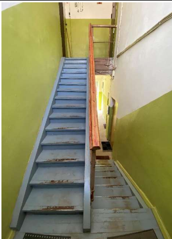
F - 79 Kāpņu telpas koka kāpnes
