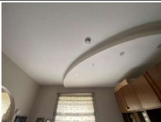
F - 119 Dzīvokļu iekšējā apdarē lietoti arī mūsdienīgie materiāli – piem., ģipškartona loksnes
