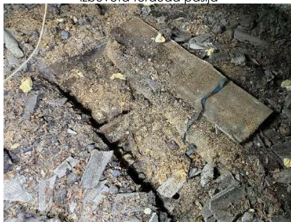
F - 44 Lokāls otrā stāva pārseguma atsegums
