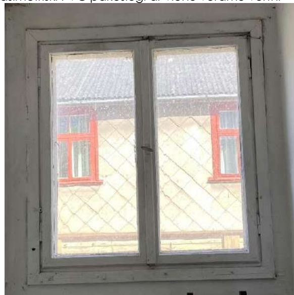
F - 91 Ēkas Rīgas ielas fasādē otrā stāva līmenī kāpņu telpā saglabājies koka konstrukcijas logs
