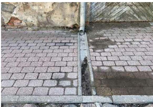
F - 69 Rīgas ielas ietves segumā pie notekcauruļu galiem izbūvētas betona teknes
