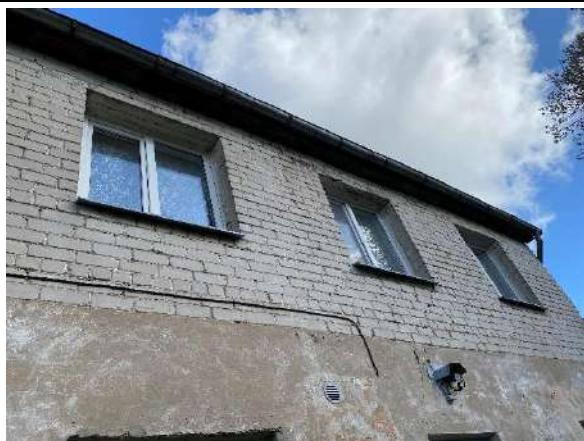
F - 131 Otrā stāva līmenī silikātķieģeļu mūra ārsienas neapmestas
