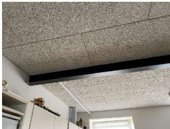
F - 42 Pirmā stāva dzīvoklī pārseguma balstīšanai izbūvēta tērauda pasija
