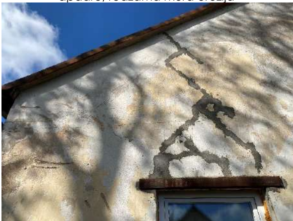
F - 27 Ēkas A puses gala fasādē zonā virs logailes redzamas plaisas mūrī. Plaisas savulaik aizziestas ar cementa javu. Pārsedzes zonā izbūvēts tērauda pastiprinājums
