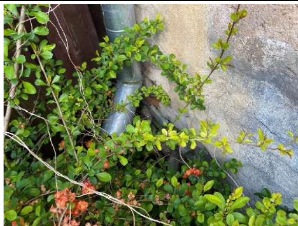
F - 16 Ēkas DR stūrī izbūvēta lietuss ūdens notekcaurule, kura nokrišņu ūdeni novada pie ēkas pamatiem, gar pamatiem veidoti apstādījumi
