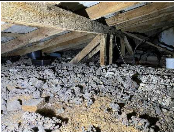
F - 38 Otrā stāva pārsegumam izbūvēts izdedžu, skaidu, būvgružu siltumizolācijas uzbērums, daudzviet ēkas bēniņos mētājas azbestcimenta lokšņu lauskas
