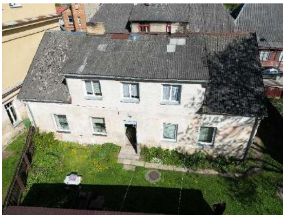
F - 129 Pagalma puses fasāde. Pirmā stāva līmenī ārsienas apmestas, otrajā stāvā – neapmests silikātķieģeļu mūris
