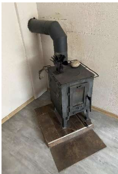
F - 96 Metāla krāsns pirmā stāva dzīvoklī. Krāsns dūmkanāls ievadīts skurstenī
