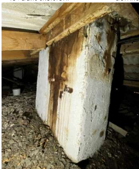
F - 99 Bēniņos uz skursteņiem redzami izteikti notecējumi, izsvīdumi
