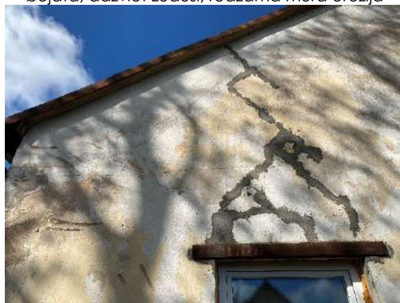
F - 128 Ēkas A puses gala fasāde. Zonā virs pirmā stāva logailes redzamas plaisas, tās savulaik aizziestas ar cementa javu
