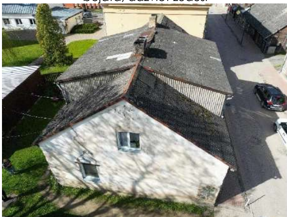
F - 127 Ēkas A puses gala fasāde. Zonā virs pirmā stāva logailes redzamas plaisas
