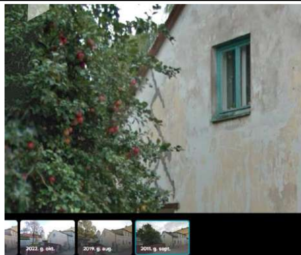
F - 30 Ēkas A puses gala fasādē zonā virs logailes esošās plaisas redzamas jau 2011. gada Google Street View uzņēmumos
