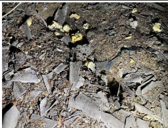
F - 39 Otrā stāva pārsegumam izbūvēts izdedžu, skaidu, būvgružu siltumizolācijas uzbērums, daudzviet ēkas bēniņos mētājas azbestcimenta lokšņu lauskas
