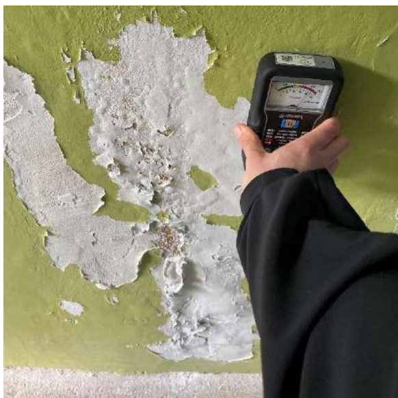
F - 21 Mitruma migrācija sienu lejas daļā, izsāļojumi un apdares atslāņošanās redzama arī kāpņu telpas sienām
