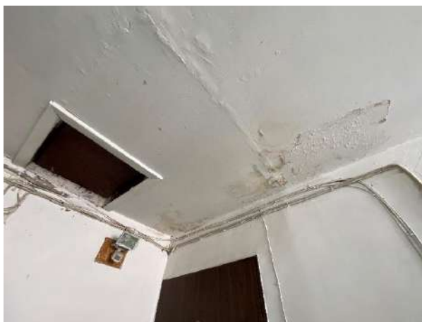
F - 117 Kāpņu telpā uz augšstāva griestu apdares redzami savulaik radušies notecējumi
