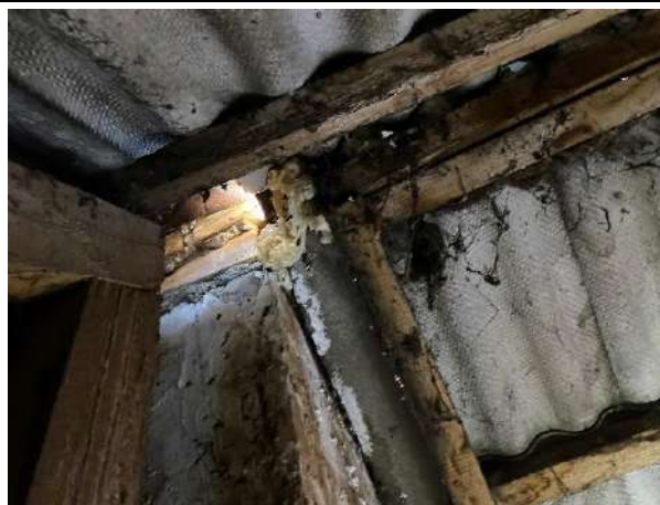
F - 66 Zonas pie skursteņu iestrādēm nav hermētiskas, nokrišņu mitruma var iekļūt ēkas bēniņos
