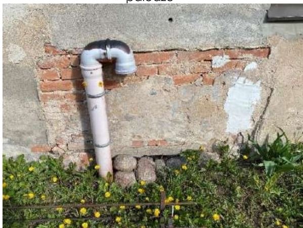
F - 94 Pagraba ieejas aile aizmūrēta ar māla ķieģeļiem
