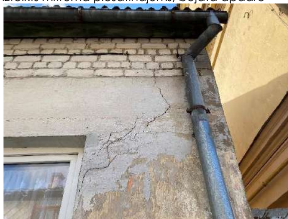
F - 26 Ēkas ZR stūrī ārsienās redzamas diagonālas plaisas, kas liecina par savulaik notikušu ēkas daļu nevienmērīgu sēšanos šajā zonā
