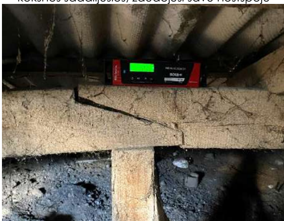
F - 55 Ēkas centrālās daļas kopturiem novērojamas defromācijas, izklāvušies mezgli
