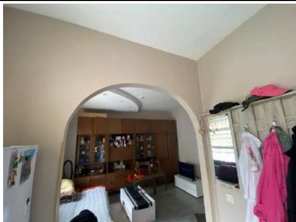
F - 83 Laika gaitā dzīvokļos veiktas starpsienu un ailu pārbūves, t.sk. izbūvētas ģipškartona starpsienas
