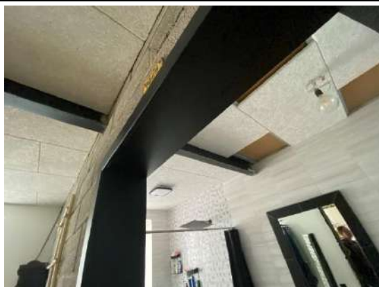
F - 120 Dzīvokļu iekšējā apdarē lietoti arī mūsdienīgie materiāli – piem., fibrolīts, flīzes, u.c.
