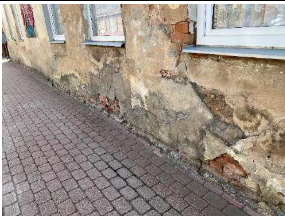
F - 125 Sienu lejas daļās apdare ievērojami bojāta, dažviet zudusi
