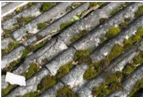
F - 109 Vairākas jumta seguma loksnes salūzušas, ar plaisām, uz seguma izteikts sūnu apaugums
