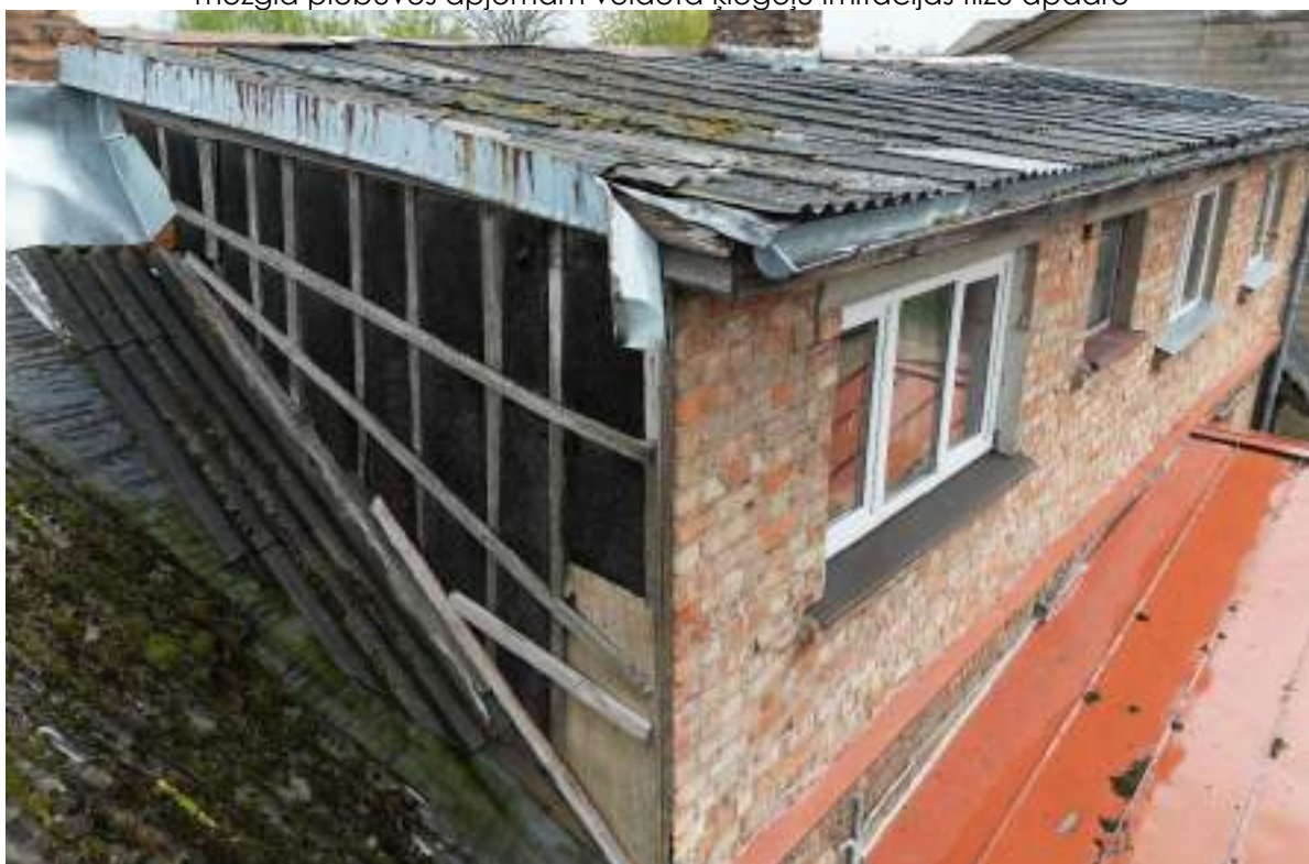
F - 52 Ēkas 2. stāva logailēm līmeniskas dzelzsbetona pārsedzes. Otrā stāva apjoma Z puses gala sienai veidots ruberoīda apšuvums
