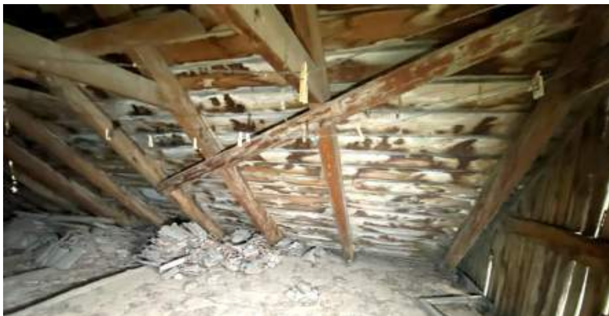
F - 83 Jumta konstrukciju diagonālās vēja saites
