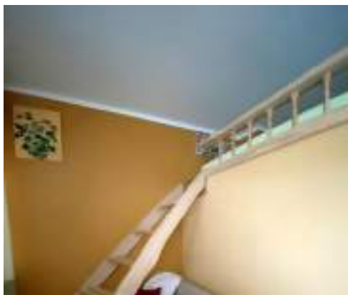
F - 197 Lielākajā ēkā daļā veikti remontdarbi, lietojot mūsdienu materiālus, sienām un griestiem daudzviet veidots ģipškartona lokšņu apšuvums
