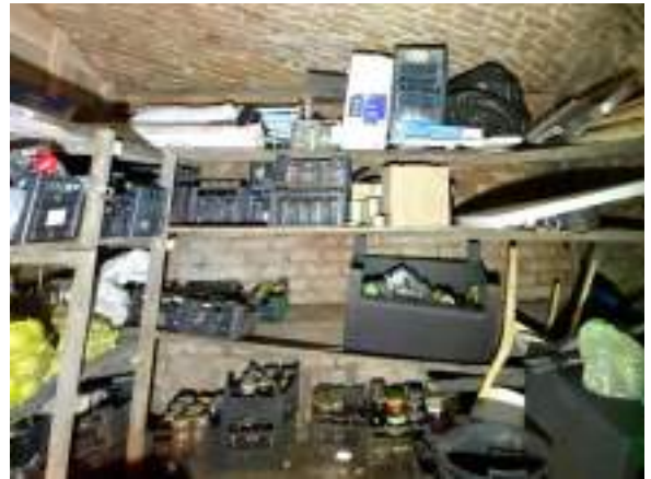
F - 11 Pagalma puses pagraba sienai veidots māla ķieģeļu piemūrējums cementa javā
