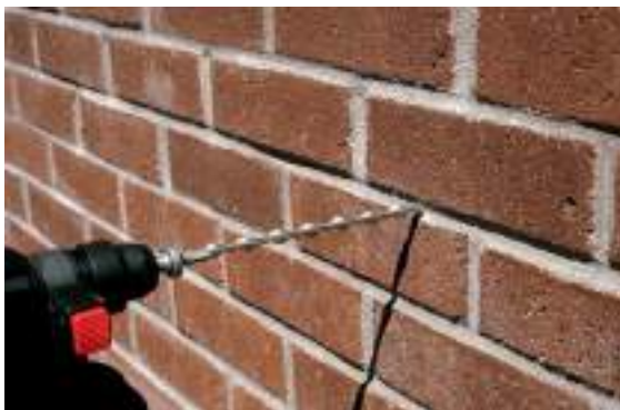
Ilustrācija 3 – spirālveida saišu/enkuru iebūves princips (Avots: https://www.vistaeng.co.uk/product/heli-helical-ties/ )
