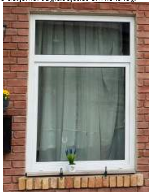
F - 157 Pirmā stāva pagalma piebūvei izbūvēts PVC konstrukcijas stikla pakešu logs
