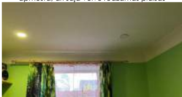
F - 76 Pirmā stāva pārsegumu no telpas puses sedz apšuvums, konstrukcijas nav eksponētas
