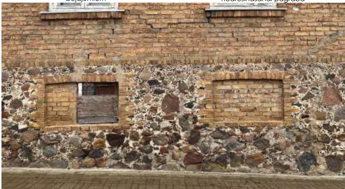
F - 7 Baznīcas ielas fasādēs cokolā veidotas dekoratīvas nišas, vienā no tām izbūvēta vēdināšanas atvere, lai veicinātu gaisa apmaiņu pagrabā
