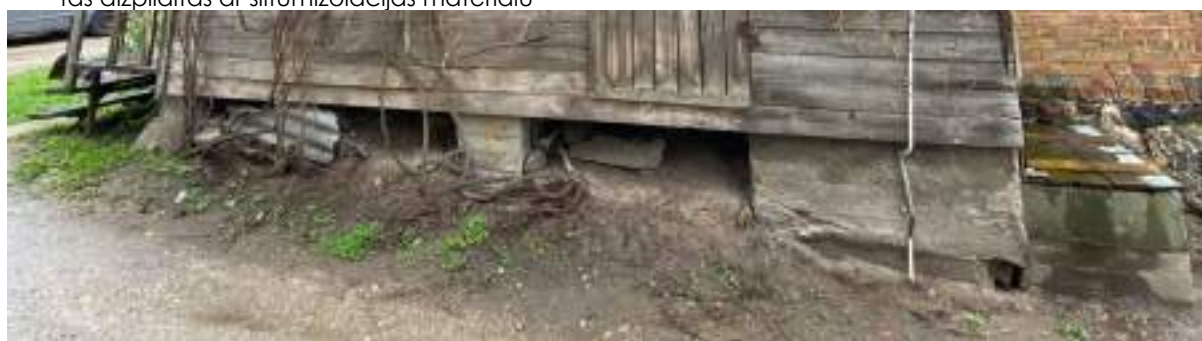
F - 26 Kāpņu telpas apjomam pamati būvēti no monolītā dzelzsbetona blokiem
