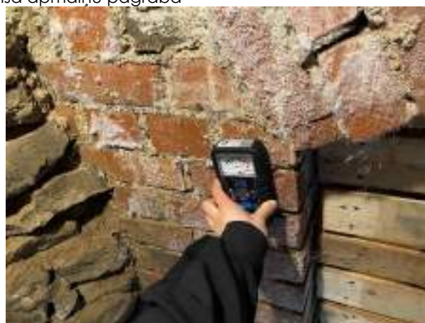
F - 9 Pagraba iekšsienām lietots arī māla ķieģeļu mūris. Mūrī izteikts mitruma piesātinājums, redzami izsāļojumi
