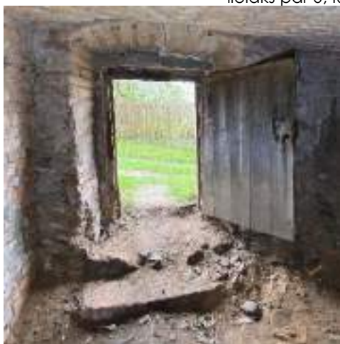
F - 145 Pie pagraba ieejas telpas pusē izbūvēts ķieģeļu mūra pakāpiens
