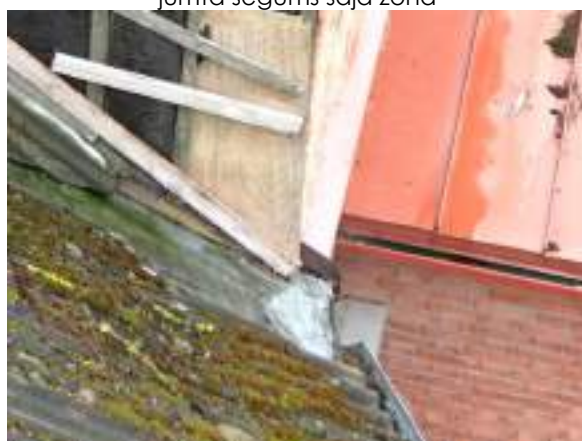
F - 121 Jumta sateknes zonā, kur pieslēdzas 2. stāva apjoms, nokrišņu ūdens nenonāk tekņē, tekne piegružota
