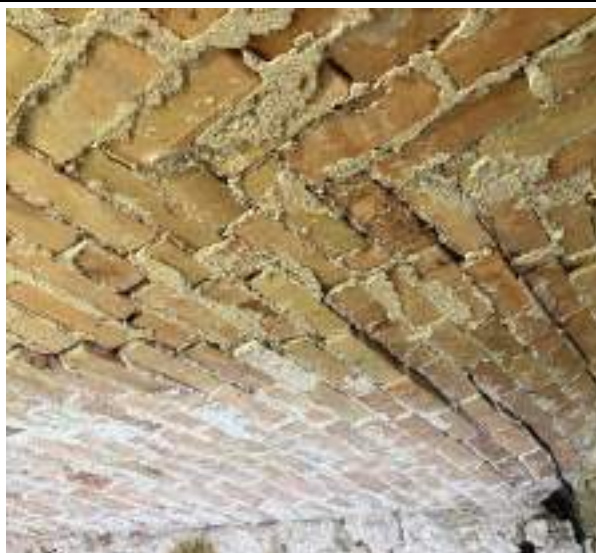
F - 64 Pagraba pārseguma velve telpā Nr. 903-3. Velvē redzamas izteiktas deformācijas – plaisas, iesēdumi, atsevišķi ķieģeļi ir kustīgi
