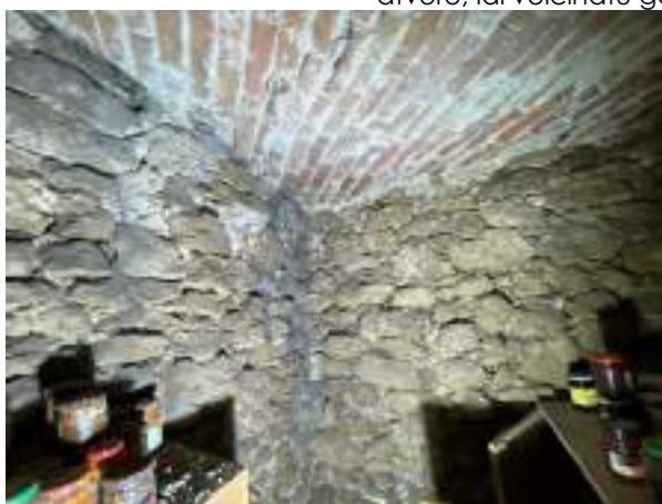
F - 8 Ēkas pamati/pagraba sienas būvēti kā dabīgo akmeņu mūris kalņa javā
