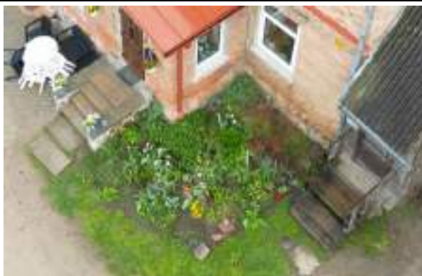
F - 14 Ēkas DA daļā pamatu tiešā tuvumā veidoti apstādījumi, kas kalpo kā papildus mitruma avots
