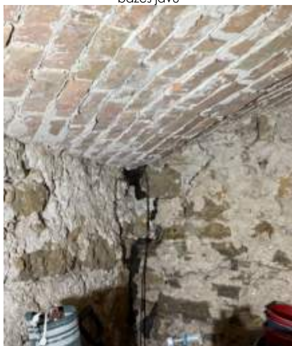
F - 24 Pagraba sienās redzamas plaisas, dažviet tās aizpildītas ar siltumizolācijas materiālu
