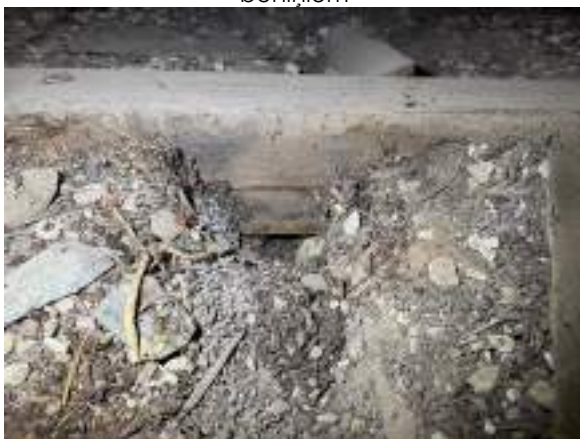
F - 79 Starp sijām veidots melno griestu dēļu klājs, būvgružu/izdedžu uzbērums
