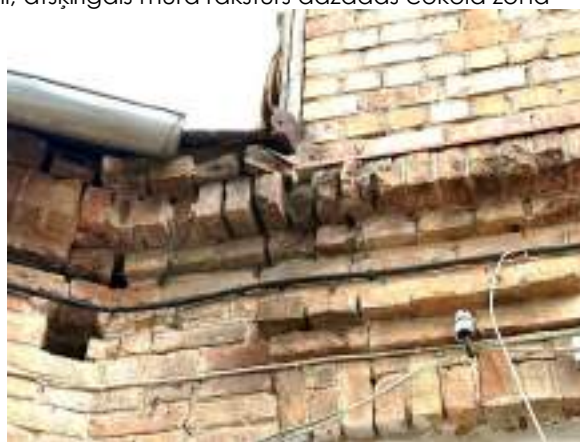
F - 48 Izdrupumi mūra dzegā zonā zem sateknes, kur piebūvēts 2. stāva apjoms
