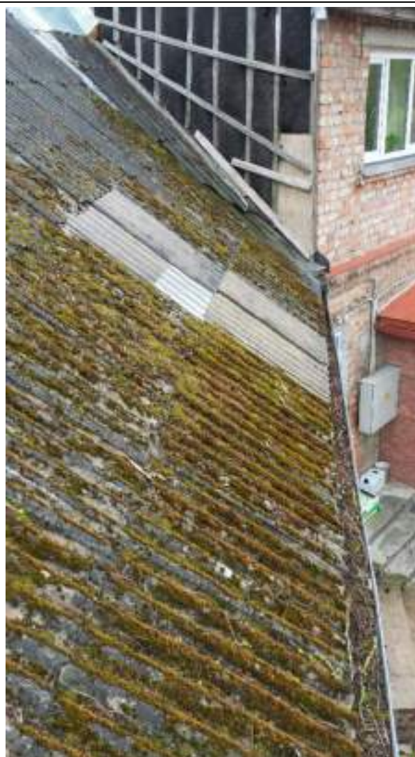
F - 129 Izteikts sūnu apaugums uz pagalma puses vienstāvīgā apjoma jumta. Teknes piegružotas, nosprostotas, pilnvērtīgi nefunkcionē
