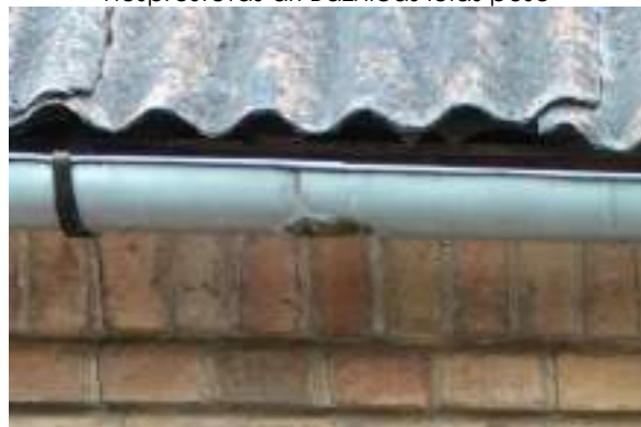
F - 134 Vairākās vietās tekņu un notekcauruļu savienojumi bojāti, nav hermētiski
