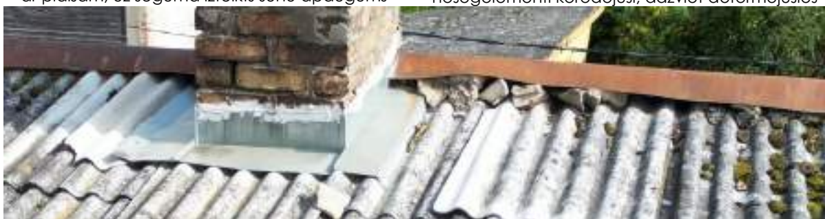
F - 111 Divstāvīgā apjoma jumtam kores zonā redzamas spraugas, tajās atrodami liela izmēra atdalījušies javas fragmenti. D puses skurstenim izbūvēta skārda iestrāde
