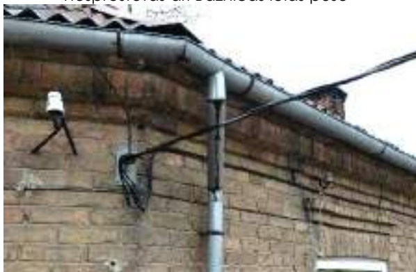
F - 133 Vairākās vietās tekņu un notekcauruļu savienojumi bojāti, nav hermētiski
