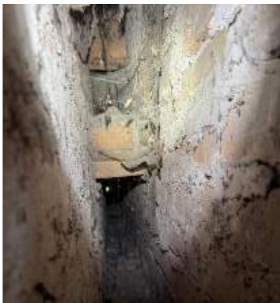
F - 42 Mūra saites, kas sasaista abas laidņu kārtas, izbūvētas ar soli ~1m
