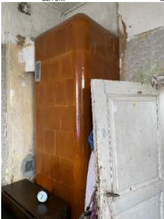
F - 174 Dzīvoklī Nr. 9 saglabājusies glazētu māla podiņu malkas krāsns
