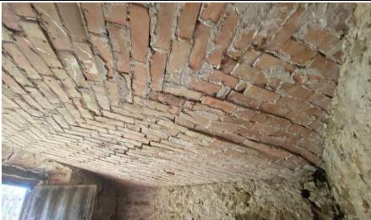
F - 61 Pagraba pārseguma velve telpā Nr. 903-3. Velvē redzamas izteiktas deformācijas – plaisas, iesēdumi, atsevišķi ķieģeļi ir kustīgi
