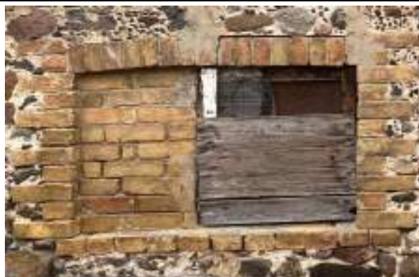
F - 164 Vienā no cokola nišām izbūvēts pagraba logs gaisa apmaiņas nodrošināšanai
