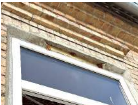
F - 160 Logam Baznīcas ielas fasādē bojātā/nav pilnvērtīgi atjaunota ārējā ailes apdare
