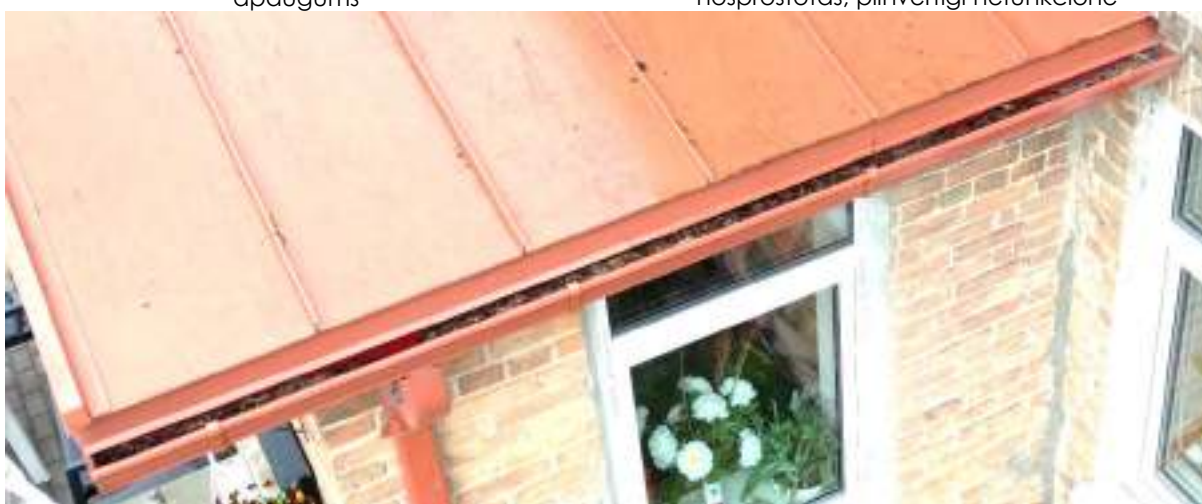
F - 130 Pirmā stāva piebūves teknes piegružotas, nosprostotas, pilnvērtīgi nefunkcionē
