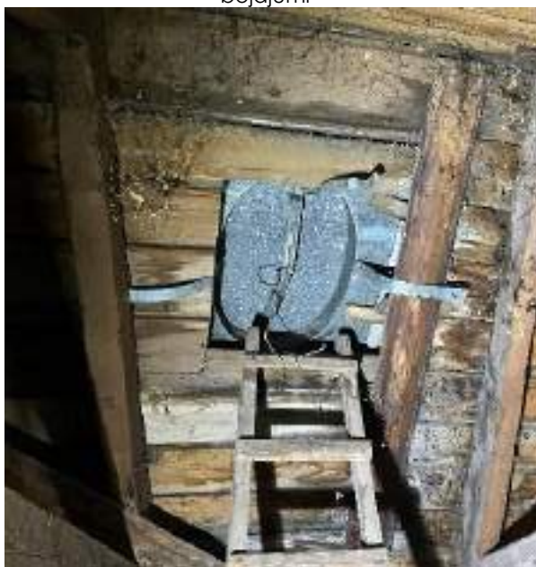
F - 169 Jumtā izbūvēta ovālas formas skārda lūka
