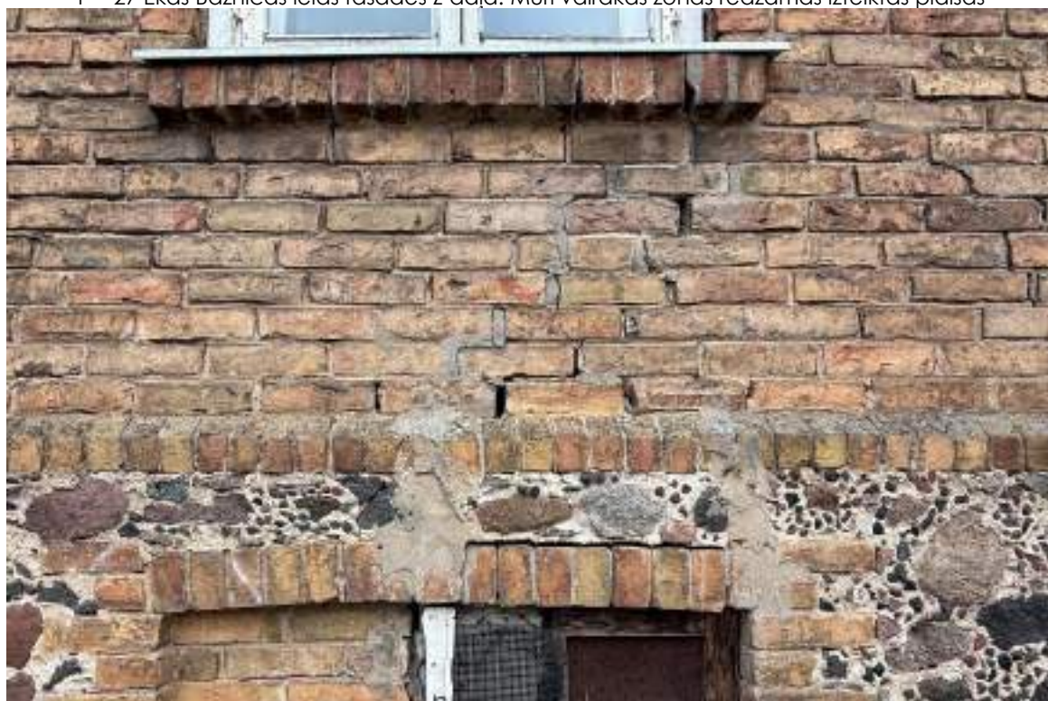
F - 28 Izteiktas plaisas, saistvielas erozija mūrī. Deformācijas redzamas arī pagraba logailes pārsedzes zonā. Plaisas savulaik aizpildītas/aizziestas
