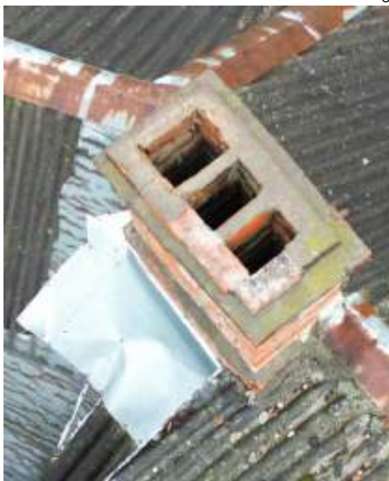
F - 182 Jumta vidusdaļā esošajam skurstenim augšdaļā redzami javas izdrupumi
