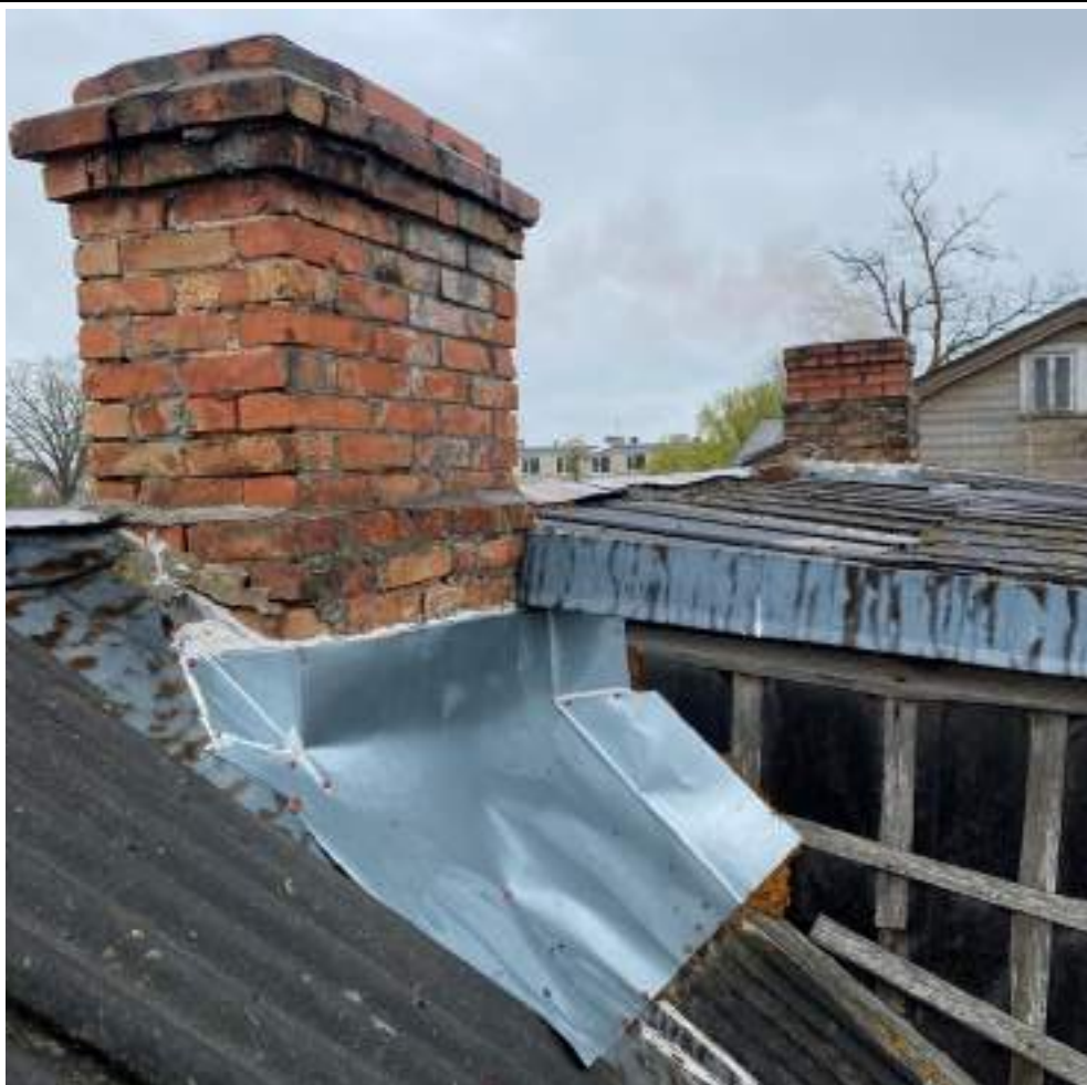
F - 181 Jumta vidusdaļas skurstenim izbūvēta skārda iestrāde, tā dažviet blīvēta ar celtniecības putām un javu
