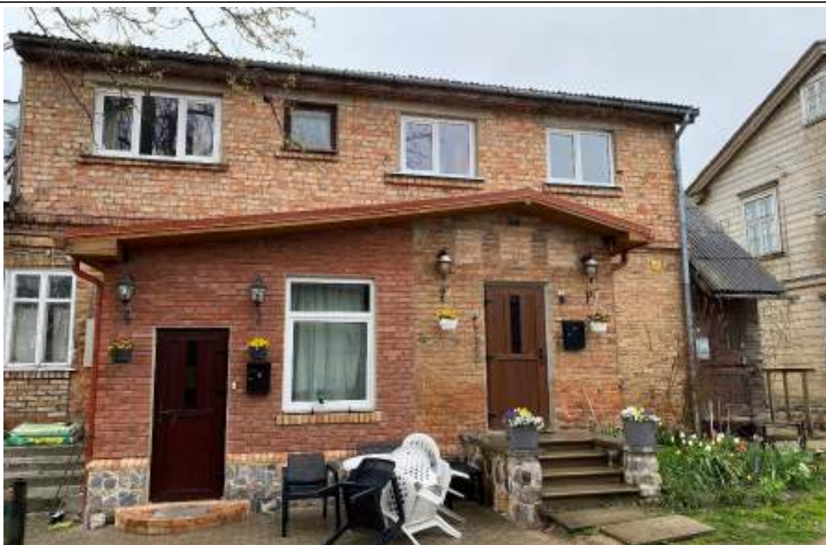
F - 51 pagalma pusē piebūvēts 2. stāva apjoms, kā arī ieejas mezgla piebūve. Ieejas mezgla piebūves apjomam veidota ķieģeļu imitācijas flīžu apdare
