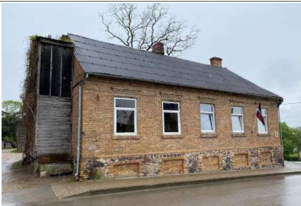
F - 203 Ēkas Baznīcas ielas fasādes D daļa. Kāpņu telpas apjomam fasāde augšdaļā nosepta ar ruberoīdu, kas naglots caur koka latām
