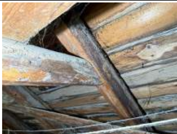
F - 89 Jumta konstrukcijās lietoti tradicionālie būvkoku savienojumi, daļa no kokmateriāliem nav pilnībā nomizoti, mizā redzami koksnes kaitēkļu radīti bojājumi
