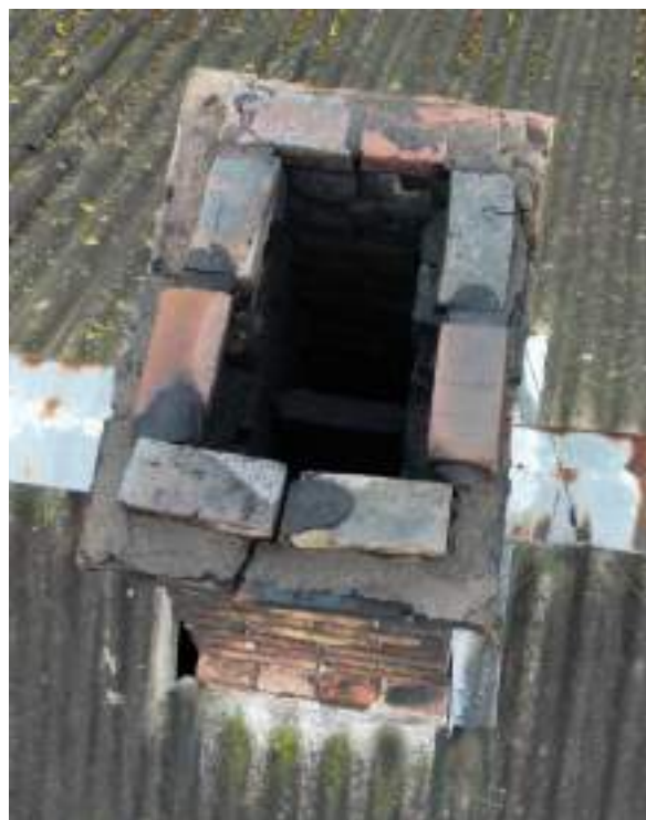
F - 180 Jumta Z puses skurstenim augšdaļā nekvalitatīvs mūrējums, redzami saistvielas izdrupumi
