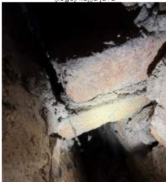
F - 43 Redzams, ka mūra saites nav caurejošas, to mūrīm zudusi sasaiste, notikušas deformācijas
