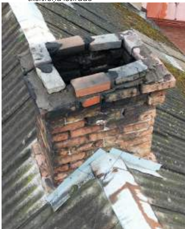
F - 179 Jumta Z puses skurstenim augšdaļā nekvalitatīvs mūrējums, redzami saistvielas izdrupumi
