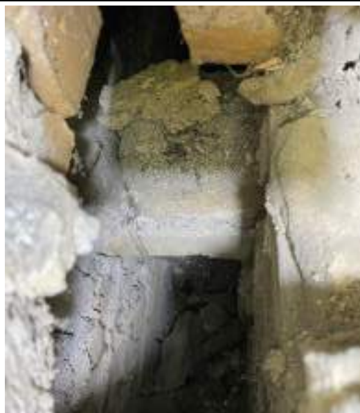
F - 41 Mūra sienas kārtas savstarpēji sasaistītas ar mūra saitēm, kuras veido divi savstarpēji samūrēti ķieģeļi kalķa javā
