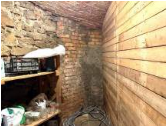
F - 10 Pagalma puses pagraba sienai veidots māla ķieģeļu piemūrējums cementa javā
