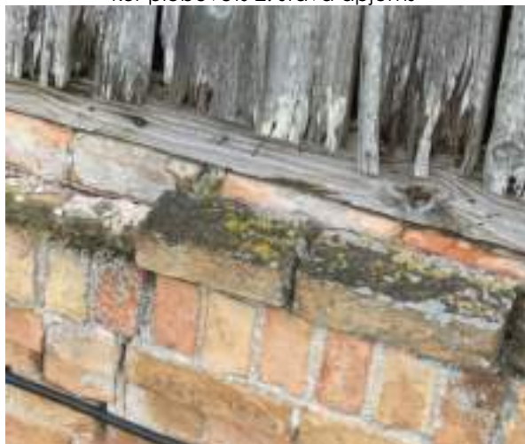
F - 50 Starpdzegai zem Z puses gala fasādes zelmiņa vairāki ķieģeļi nestabili, var radīt uzkrīšanas draudus
