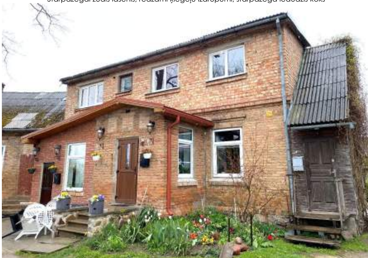
F - 206 Ēkas pagalma puses fasāde. Pirmā stāva līmenī veidota piebūve, daļu no tās fasādēm sedz ķieģeļu imitācijas flīzes. Otrā stāva apjoma fasāžu apdari veido eksponēts caurumoto ķieģeļu mūris
