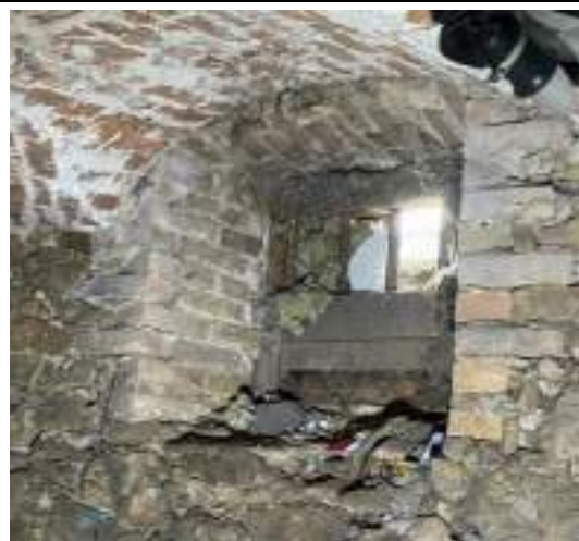
F - 6 Cokolā izbūvēta pagraba logaile, kas kalpo kā vēdināšanas atvere gaisa apmaiņas nodrošināšanai pagrabā
