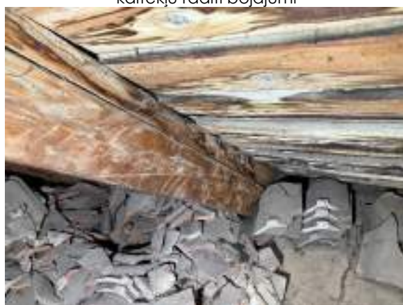
F - 91 Daļa no jumta konstrukcijām būvētas no tēstiem kokmateriāliem
