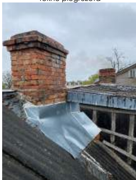
F - 123 Ēkas jumta vidusdaļā esošajam skurstenim izbūvēta skārda iestrāde
