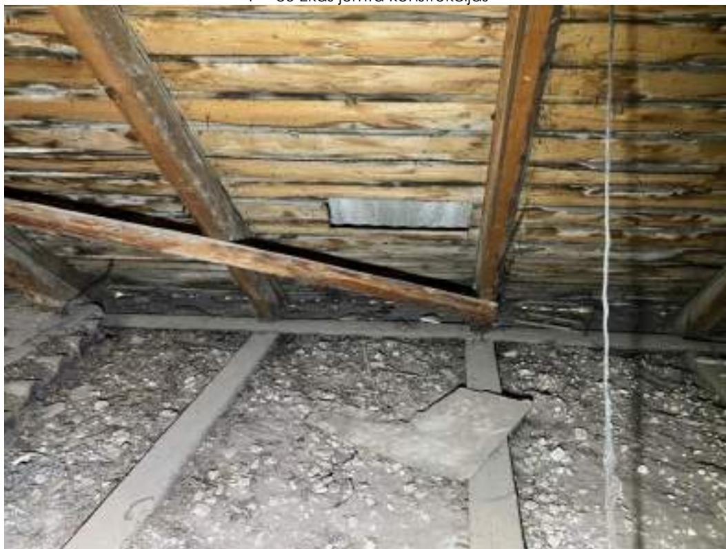
F - 87 Spāru gali balstīti siju galos. Jumtam izbūvētas slīpās vēja saites, virs spārēm – dēļu klājs
