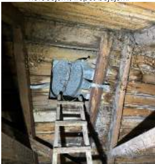
F - 98 Jumtā iebūvētas ovālas formas lūka ar skārda nosegvāku
