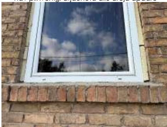
F - 161 Logam Baznīcas ielas fasādē bojātā/nav pilnvērtīgi atjaunota ārējā ailes apdare
