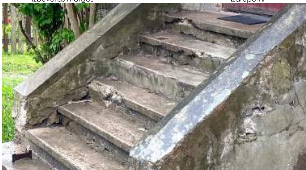
F - 143 Ēkas Z daļas ieejas kāpnes pagalma fasādē. Kāpņu vaigos un pakāpienos redzami izdrupumi
