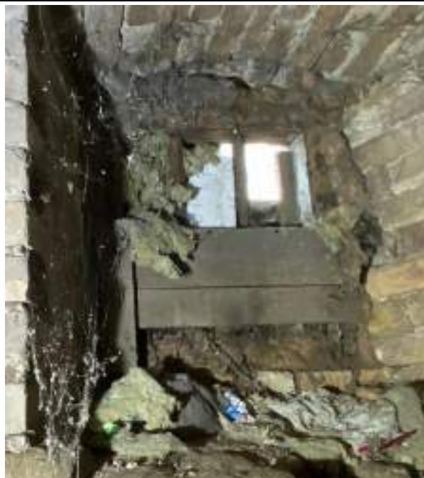
F - 196 Pagraba logaile daļēji nosepta, daļā ierīkotas restes gaisa apmaiņas nodrošināšanai pagrabā
