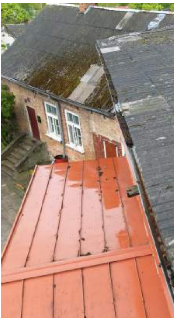
F - 128 Otrā stāva apjoma teknes piegružotas, nosprostotas. Uz jumta veidojas izteikts sūnu apaugums
