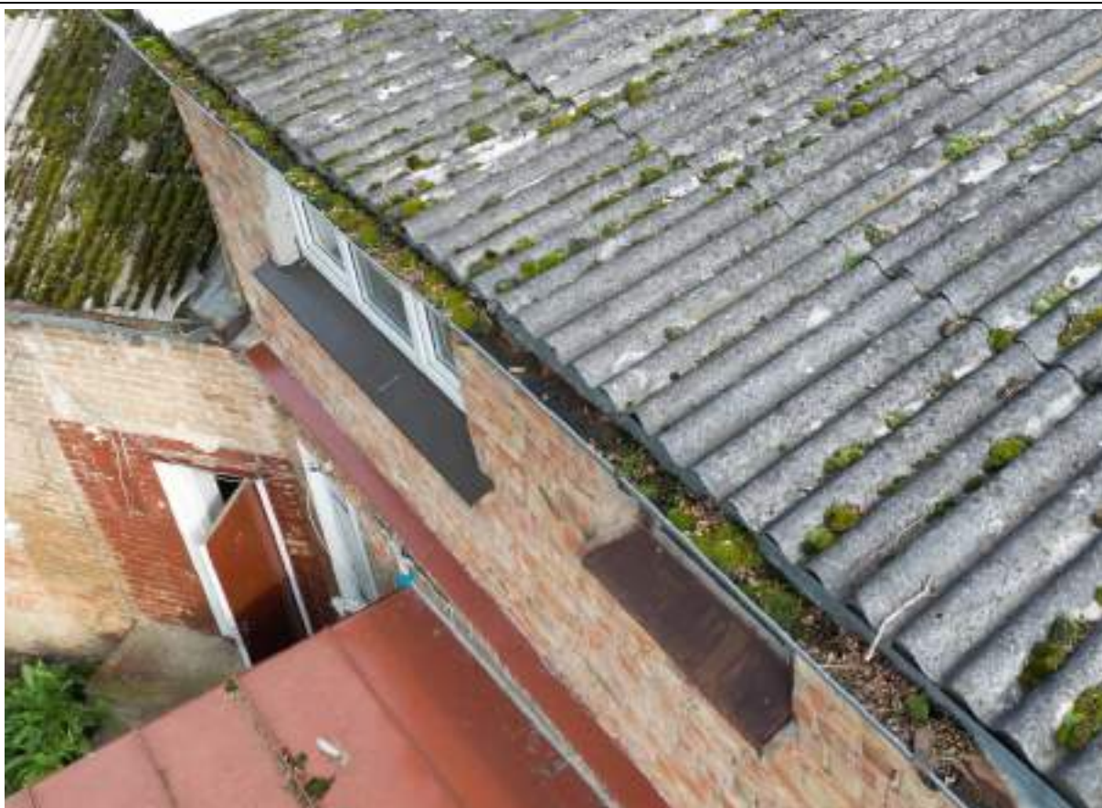
F - 126 Otrā stāva apjoma teknes piegružotas, nosprostotas, pilnvērtīgi nepilda savu funkciju
