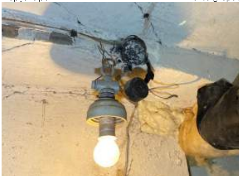
F - 186 Neatbilstoši kabeļu stiprinājumi, savienojumi ēkas pagraba telpā
