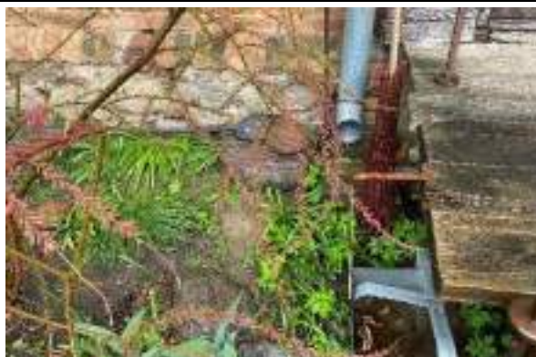
F - 15 Lietus ūdens notekcauruļu gali nokrišņus vairākās vietās novada pie pamatiem, veicinot ūdens infiltrāciju pamatos un sienu lejas daļās
