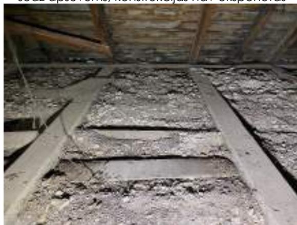
F - 78 Starp sijām veidots melno griestu dēļu klājs, būvgružu/izdedžu uzbērums
