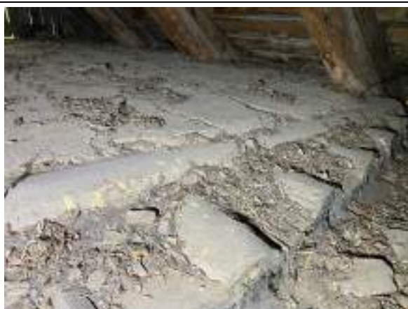
F - 81 Ēkas Z daļā pārsegumam izbūvēts māla klona siltinājums
