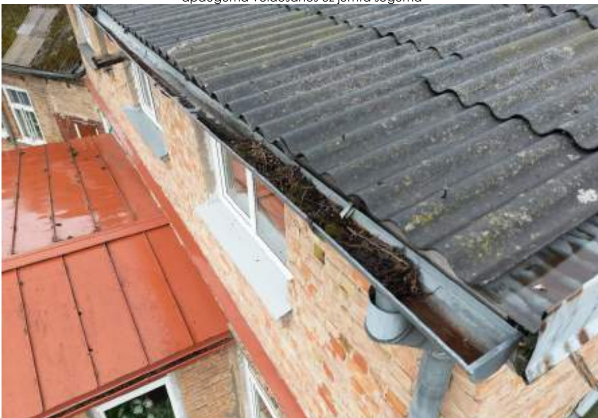
F - 125 Otrā stāva apjoma teknes piegružotas, nosprostotas, pilnvērtīgi nepilda savu funkciju
