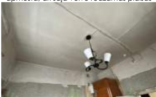
F - 75 Pirmā stāva pārsegumu no telpas puses sedz apšuvums, konstrukcijas nav eksponētas
