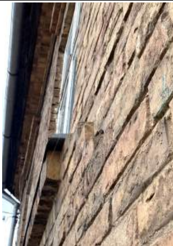
F - 32 Vairākās zonās redzamas ķieģeļu sienas ārējās mūra kārtas novirze no vertikālītātes, deformācijas, kas pārsniedz ~3cm
