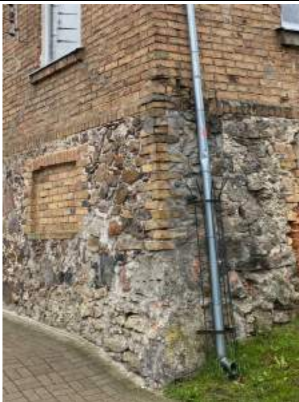
F - 31 Ēkas Z stūrī daudzviet redzami savulaik veikti mūra labojumi. Labojumi zonā aiz notekcaurules veikti ar cementa javu
