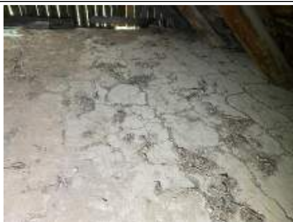
F - 82 Ēkas Z daļā pārsegumam izbūvēts māla klona siltinājums
