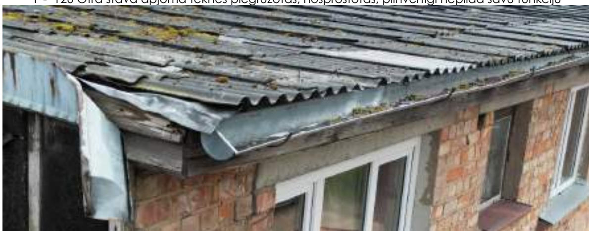
F - 127 Otrā stāva apjoma teknes piegružotas, deformējušās, atrauta skārda vējmala
