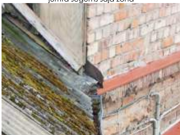
F - 120 Jumta sateknes zonā, kur pieslēdzas 2. stāva apjoms, nokrišņu ūdens nenonāk tekņē, tekne piegružota
