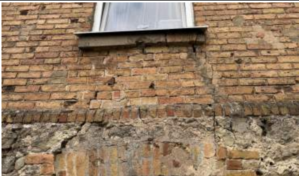
F - 36 Ēkas Z puses gala fasādē redzamas plaisas zonā starp durvju aili un 1. stāva logaaili, mehāniski bojājumi mūrī (iespējams – ložu pēdas)
