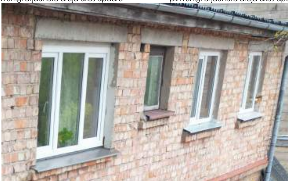
F - 162 Otrajā stāvā izbūvēti PVC logi, koka konstrukcijas logs saglabājies tikai vannas istabā
