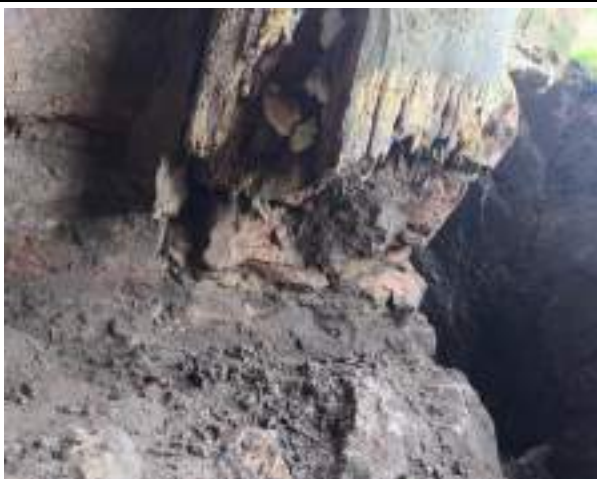
F - 167 Pagraba ieejas durvju rāmja statņu apakšdaļās redzami truses, koksnes kaitēkļu radīti bojājumi
