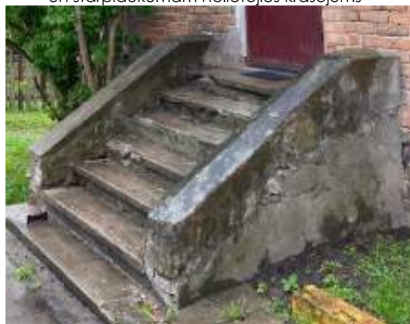
F - 142 Ēkas Z daļas ieejas kāpnes pagalma fasādē. Kāpņu vaigos un pakāpienos redzami izdrupumi
