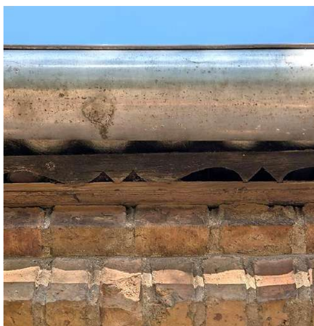
Robdēļa fragments ēkas D daļas R fasādē. 2025. gada foto
