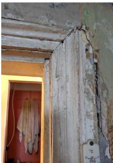
Iekšdurvis dzīvoklī Nr. 9a, apmale. 2025. gada foto
