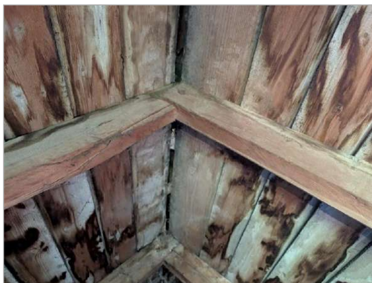
Skats uz ēkas jumta konstrukciju mājas Z daļā.
