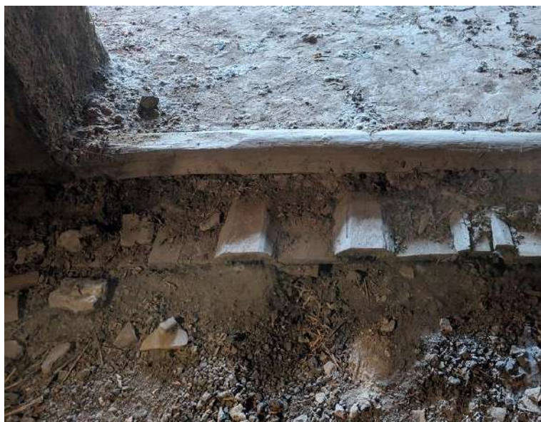
Skats uz vietu, kur labi redzams ēkas Z galā saglabājies un zem māla klona iestrādātais trinīti likts dēļu klājs. Skats uz Z. 2025. gada foto
