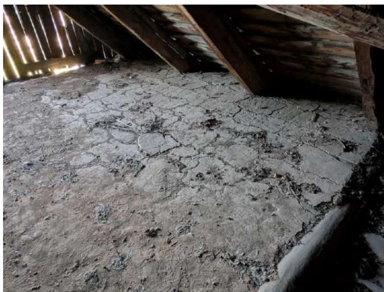
Skats uz ēkas jumta konstrukcijas A slīpni un no dēļiem nagloto Z gala zelmini. Labi redzams uz grīdas klātais māla klons, kā arī lielās spraugas starp zelmiņa dēļiem. 2025. gada foto
