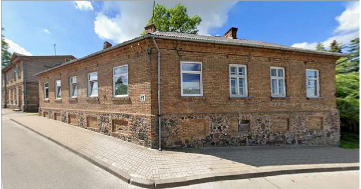
Ēkas Baznīcas iela 12 kopskats no Baznīcas ielas puses. 2025. gada foto
