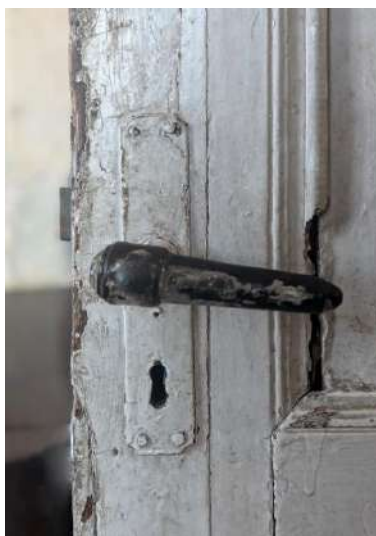
Iekšdurvis dzīvoklī Nr. 9a: sākotnējais rokturis, slēdzene, nosegplāksne. 2025. gada foto
