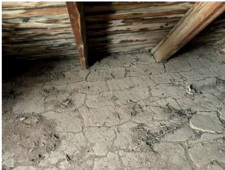
Skats uz ēkas jumta konstrukcijas A slīpni mājas Z daļā. Skats uz A/DA. Attēlā labi redzams arī šajā bēniņu daļā iestrādātais māla klons, kas te klāts virs trinīti liktiem dēļiem. 2025. gada foto
