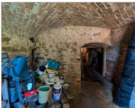
Sākotnējais pagraba pārsegums – ar kaļķa javu mūrēta mucas velve. 2025. gada foto
