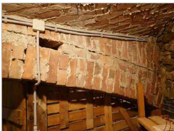
Pagraba pārseguma velvi pastiprinoša arka – visticamāk, iebūvēta 20. gs. 30. gados. 2025. gada foto
