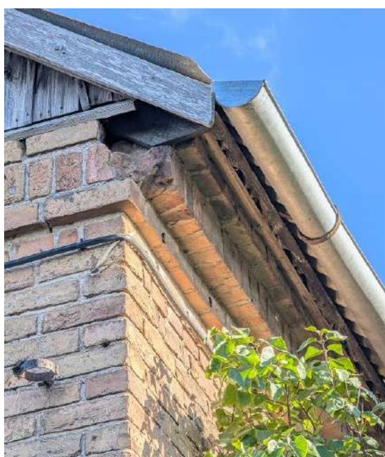
Robdēlis ēkas R fasādē (pie ēkas D daļas ZR stūra). 2025. gada foto
