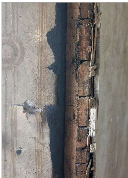
Dzīvoklī Nr. 9, logailā L5. Redzama virs 1930. gadu tapetēm uzstrādātā pape, uznaļotie dēļi, skali un apmetums. 2025. gada foto
