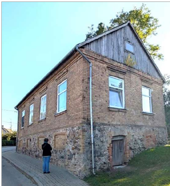
Ēkas Z fasāde mājas izpētes laikā. Attēlā redzami kara laika bojājumi, daļēji izbrukusi pagraba durvjaile, aizmūrētā pagraba logaile un dēļu klājs sākotnējās mūra jumtgales vietā. 2025. gada foto
