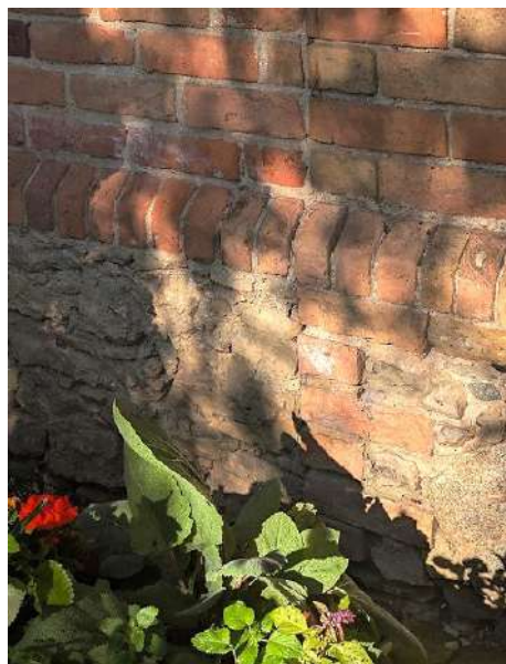
Virspamatu noslēgums ar ēkas stūriem raksturīgo ķieģeļu mūrējumu R fasādes D daļā. 2025. gada foto
