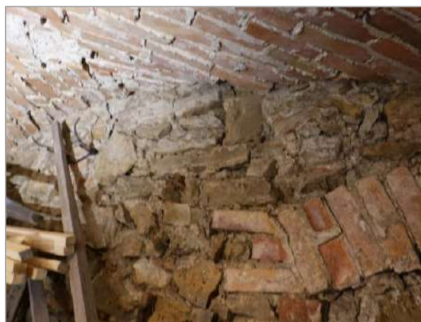
Kādas vēlāk aizmūrētas ailas fragments vienā no pagrabu sadalošajām starpsienām. 2025. gada foto
