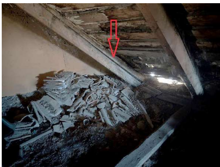
Skats uz ēkas jumta konstrukcijas R slīpni mājas Z daļā – līdzās 20. gs. 70. gadu sākumā celtās jumta izbūves Z sienai. Attēlā labi redzama (uz to norāda sarkanā bulta) uz konkrētās spāres uzstrādātā uzspāre. 2025. gada foto
