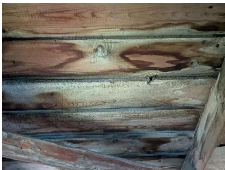
Tieši uz spārēm naglotā dēļu klāja fragments ēkas Z daļas A slīpnē. Redzams, ka klājs veidots no platiem, plāniem, zēmerētiem, gaterī zāģētiem dēļiem, kas viens virs otra uznagloti pārlaidu vai tā sauktajā klinkerplankojumā, aizsargājot bēniņus no zem dakstiņiem iekļuvušā mitruma un nodrošinot ūdens novadišanu notekrenē. 2025. gada foto
