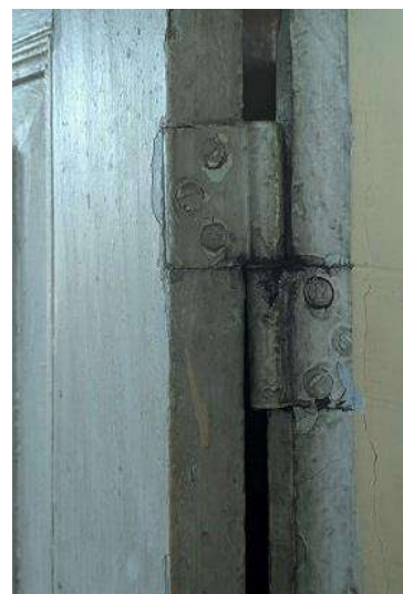
Iekšdurvis dzīvoklī Nr. 9a, sākotnējās stobrviras. 2025. gada foto
