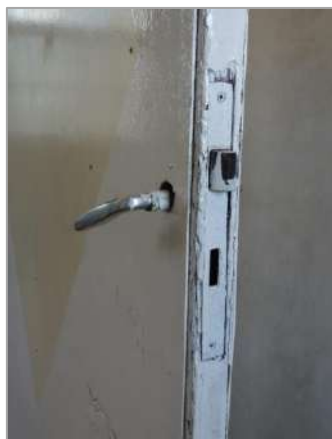
20. gs. 30. gadu slēdzene un 20. gs. 50. gadu rokturis dzīvokļa Nr. 9 vērtņē. 2025. gada foto
