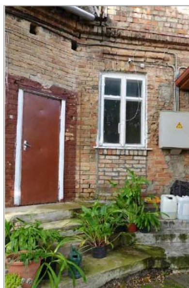
Pārvietotā durvjaila AD2 un logs L15 sākotnējo durvju vietā. 2025. gada foto
