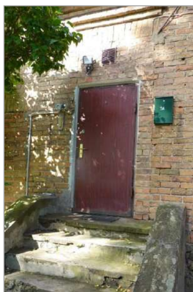
Durvjaila AD1, kura sākotnēji bijusi platāka un ar virsgaismu. 2025. gada foto
