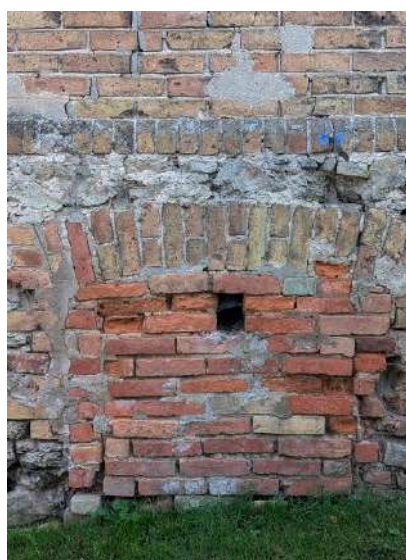
Aizmūrētā pagraba loga Z gala sienas virspamatos. 2025. gada foto
