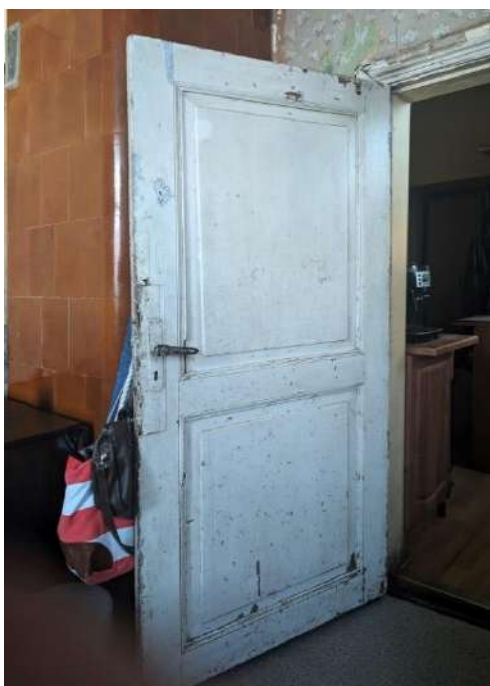
Ēkas autentiskās rāmja pildiņa konstrukcijas iekšdurvis dzīvoklī Nr. 9a. 2025. gada foto
