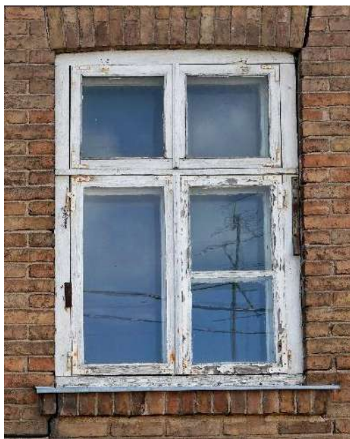
Skats uz logu L4 ēkas R fasādē. 2025. gada foto
