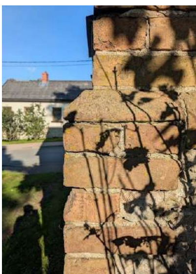
Virspamatus noslēdzošā ķieģeļu rinda un stūra mūrējums. 2025. gada foto
