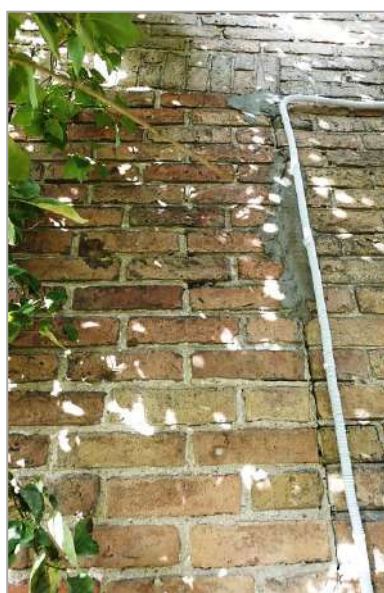
Aizmūrēta durvjaila ēkas R fasādes Z galā. 2025. gada foto
