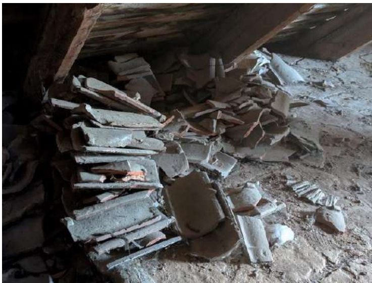
Ēkas sākotnējā jumta seguma māla dakstiņi ēkas D daļas bēniņos. 2025. gada foto
