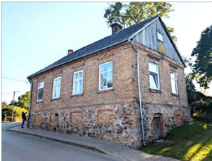
Skats uz ēku Baznīcas ielā 12 no Baznīcas ielas puses virzienā uz DR.
