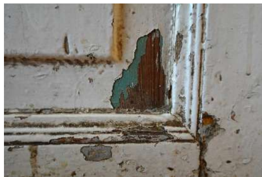
Iekšdurvju dzīvoklī Nr. 9a fragments. Redzami vairākkārtēju krāsojumu slāņi, senākais – gaiši silti pelēks. 2025. gada foto
