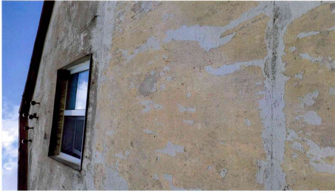
36.attēls. Skats uz A fasādes augšdaļu. Loga aile iebūvēta 20.gs. 60.gadu beigu pārbūvē.
