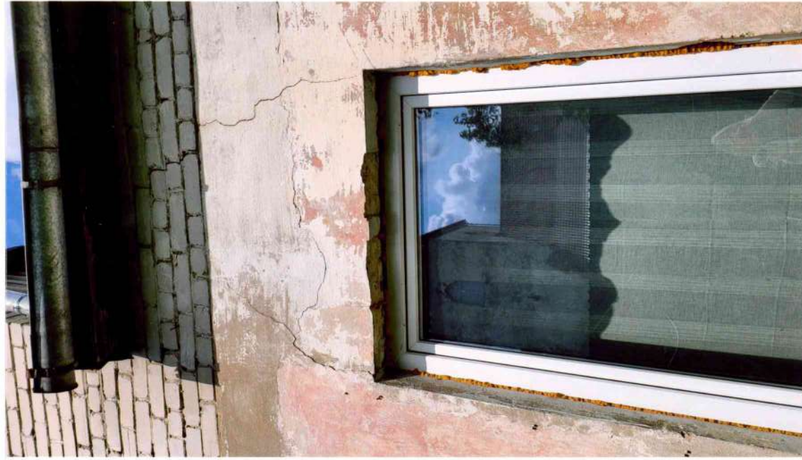
31. attēls. D fasādes fragments. 20.gs. 60.gadu beigu pārbūvei izmantots balts silikātkieģelis .
