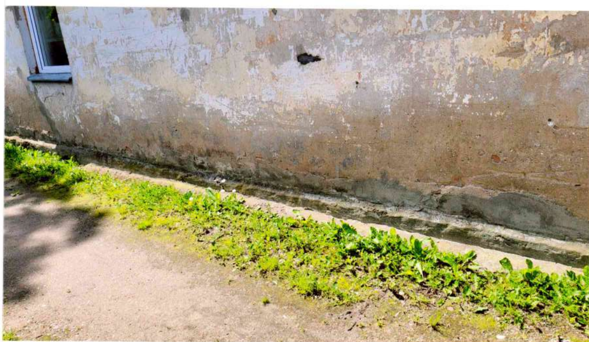
24. attēls. A fasādes cokola fragments vidusdaļā.
