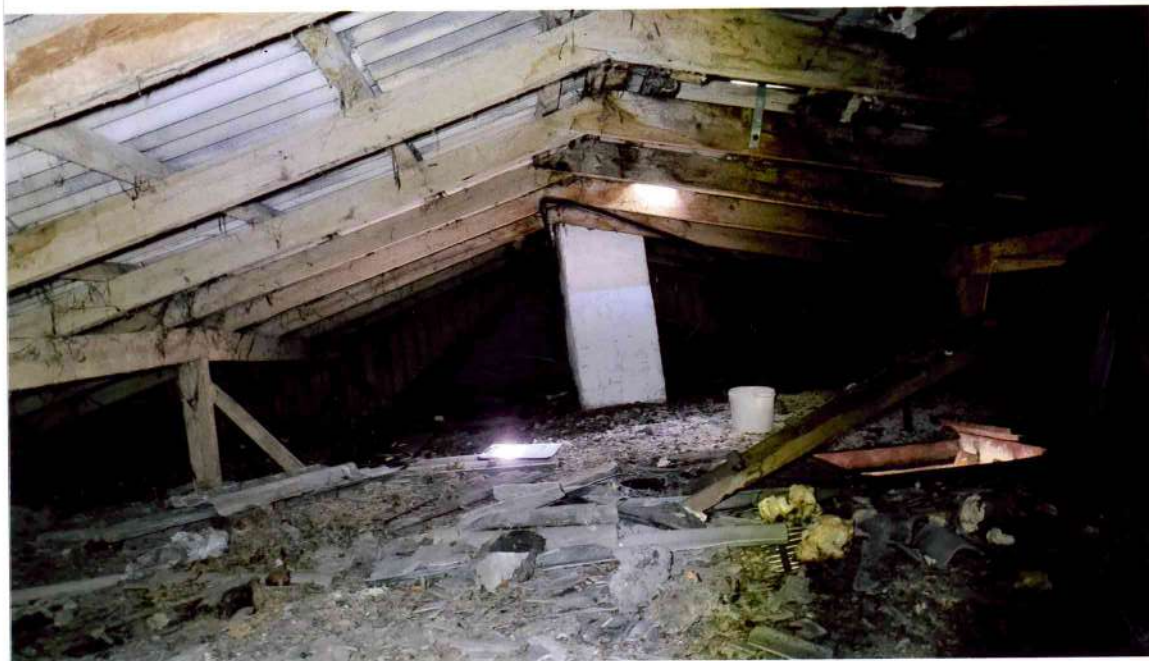
45.attēls. Bēniņtelpas kopskats uz ēkas A gala sienas pusi.
