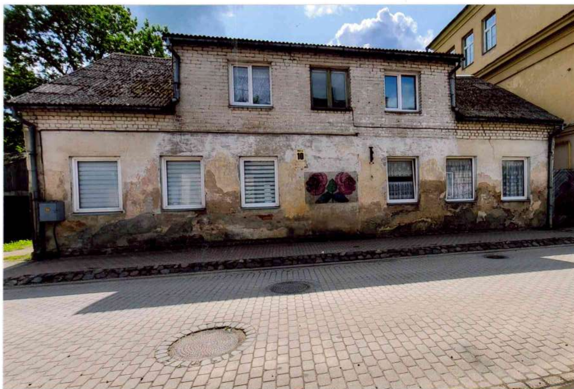
12. attēls. Ēkas Z fasādes kopskats (pret Rīgas ielu).
