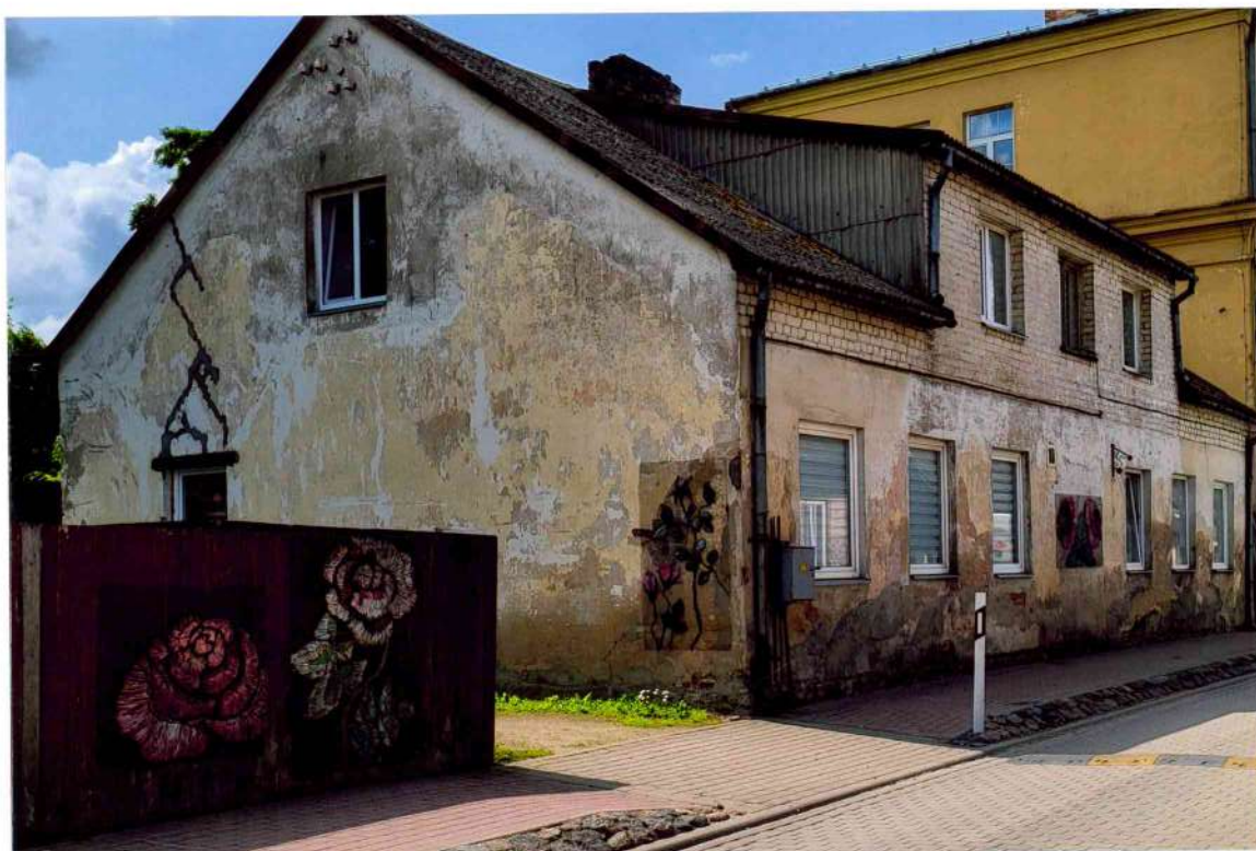
21. attēls. Ēkas kopskats no ZA puses.
