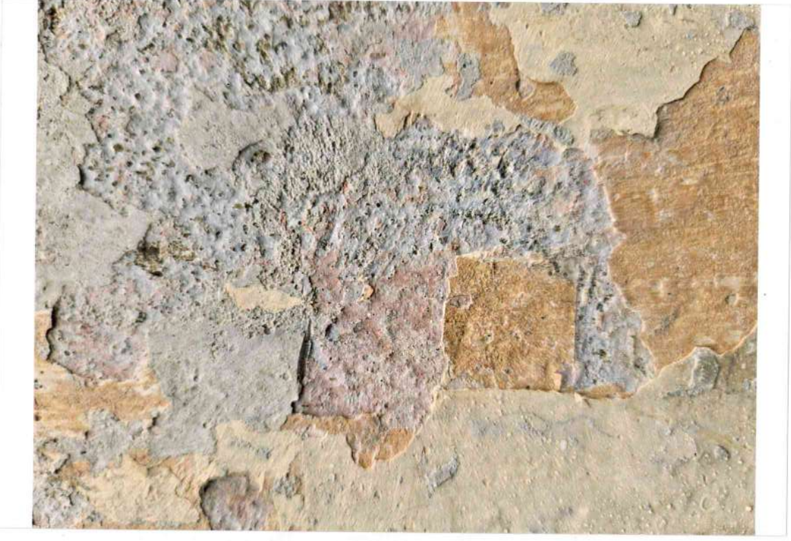
18. attēls. Z fasādes fragments. Krāsojuma slāņi.
