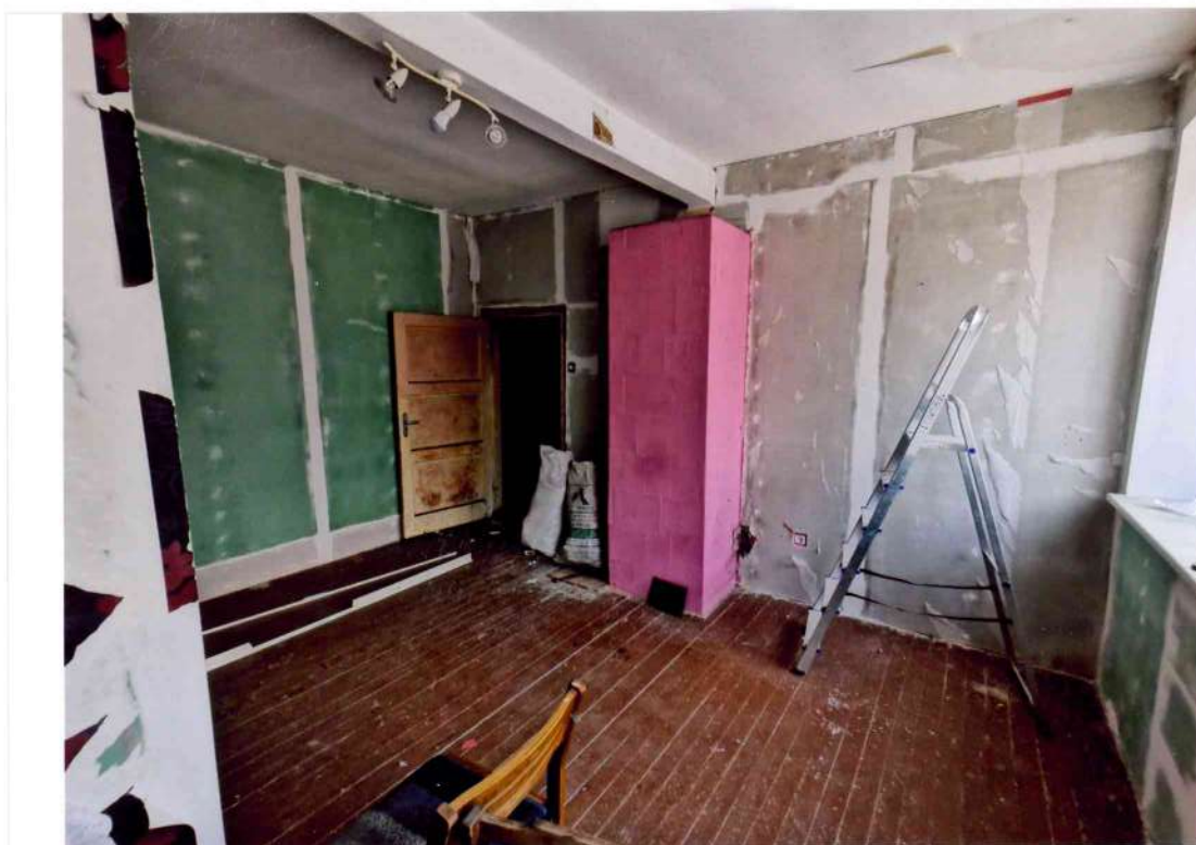
40.attēls. Krāsota podiņu krāsns (apsekošanas laikā jau demontēta) 1.stāva dzīvoklī Nr.1 (fotografēts pirms remonta 2021.gadā).
