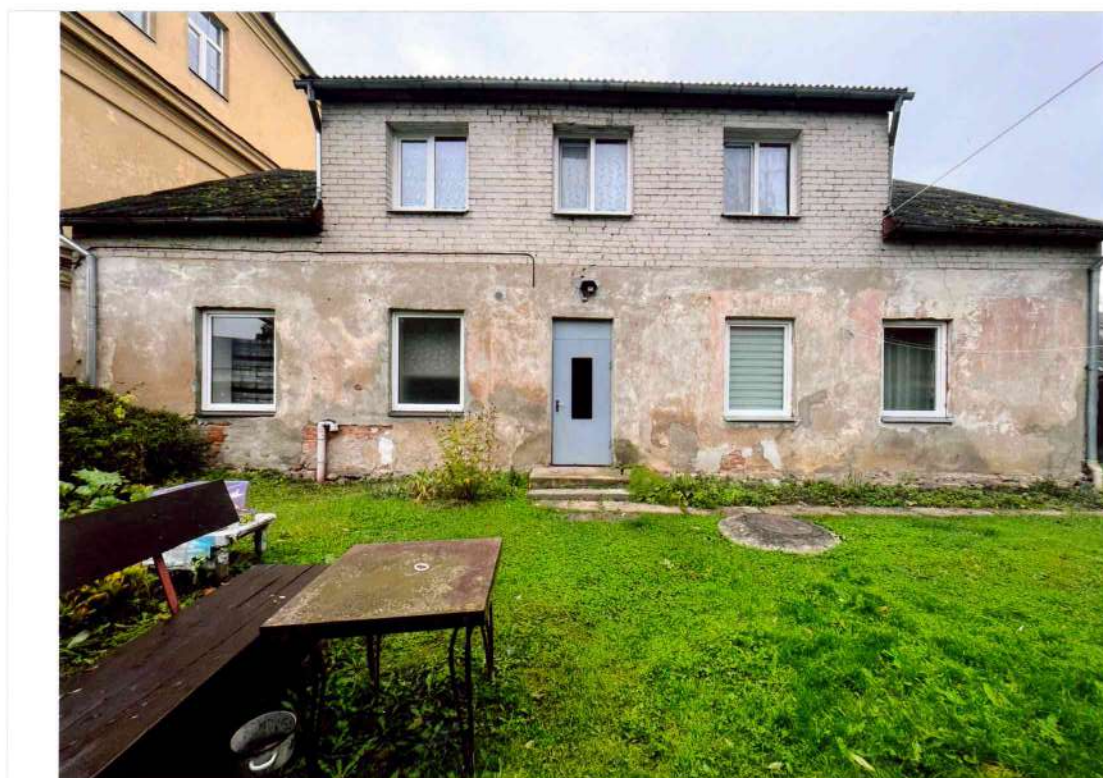
30. attēls. Ēkas D (pagalma ) fasādes kopskats.
