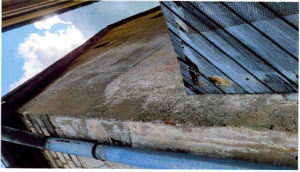
34.attēls. Fasādes ZR stūris. Augšdaļas fragments.
