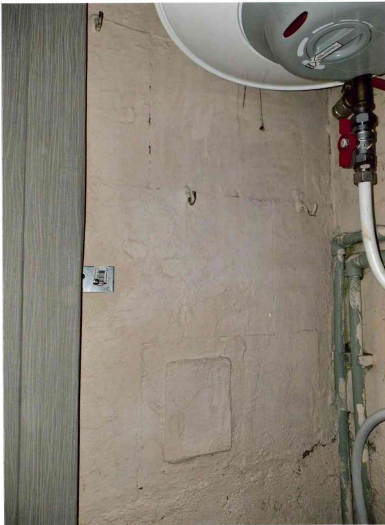
43.attēls. Saglabājies sildmūra fragments 2.stāva dzīvoklī Nr.5.
