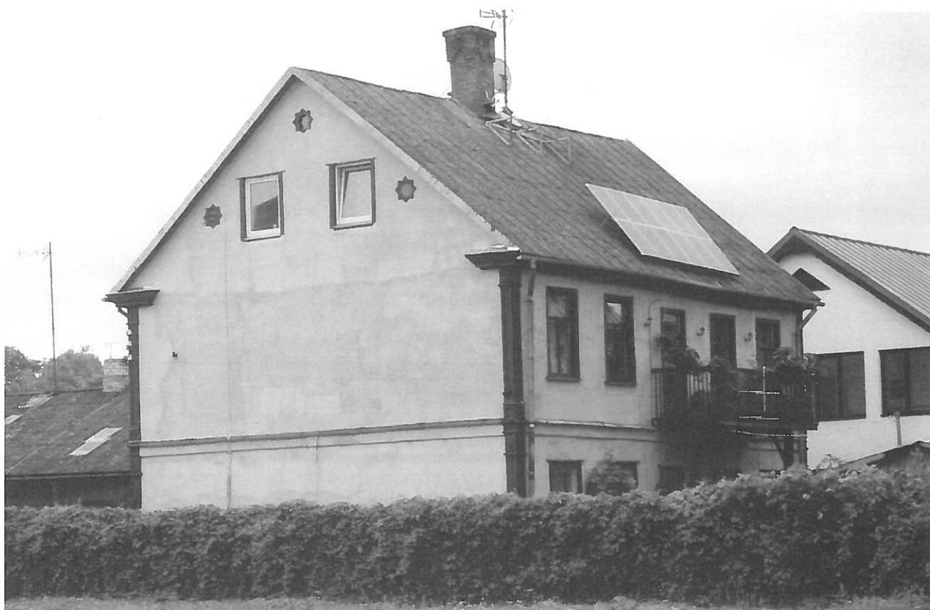
4.fotoattēls. Ēkas kopskats no Rīgas ielas puses pāri blakus gruntsgabalam.
