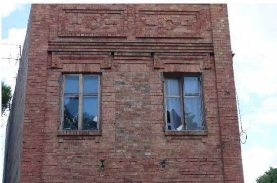
26. attēls. Skats uz ZR fasādes daļu – logailu un atikas dekoratīvo apdari. Redzamas aizmūrētas balkona durvis AD-6
