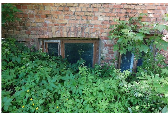
37. attēls. Skats uz atšķirīgos periodos tapušo ēkas daļu sadures vietu ZA fasādē ar labi redzamu atšķirīgu mūrējumu un ķieģeļiem
