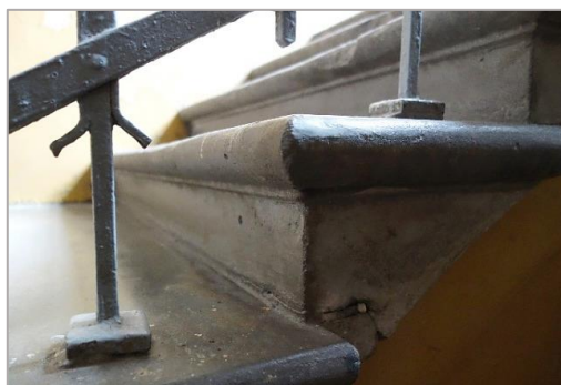
59. attēls. Profilēti betona pakāpieni ēkā Kalna ielā 16
