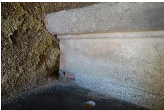
58. attēls. Betona pakāpiena profils ēkā Rīgas ielā 46
