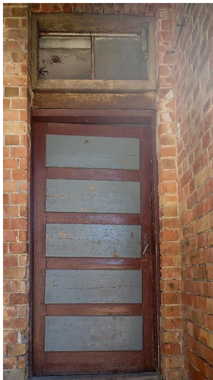
45. attēls. 20. gs. 60. gados uzstādītas ārdurvis AD-4 ar laikmetam raksturīgu piecu horizontālu pildīņu dalījumu. Saglabājies sākotnējais virsgaisma logs.
