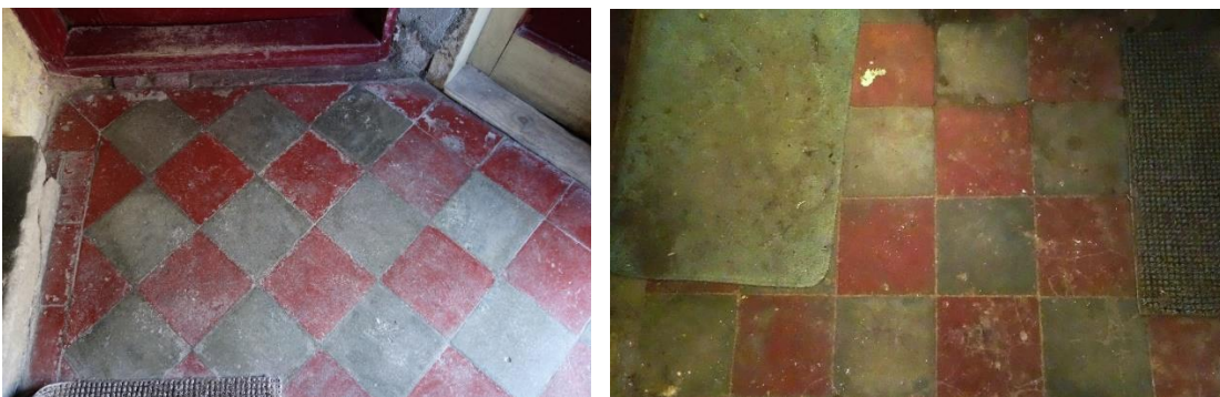
60., 61. attēls. Kāpņu laukumiņu flīzējums ar krāsainām betona flīzēm ēkā Rīgas ielā 46 k-2 Pirmā stāva laukumiņā flīzes liktas diagonāli, otrajā stāvā – paraleli sienām.
