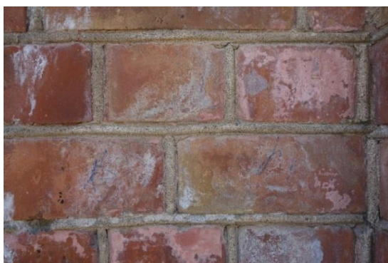
22. attēls. Ķieģeļu mūrējums ar izšuvojumu DR fasādes R daļā
