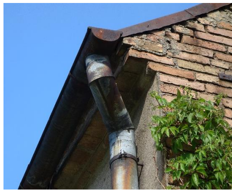
17. attēls. Skats uz DA gala šķērskorpusa vecākās daļas dzegu.
