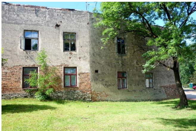
36. attēls. Skats uz ēkas ZA fasādi.
