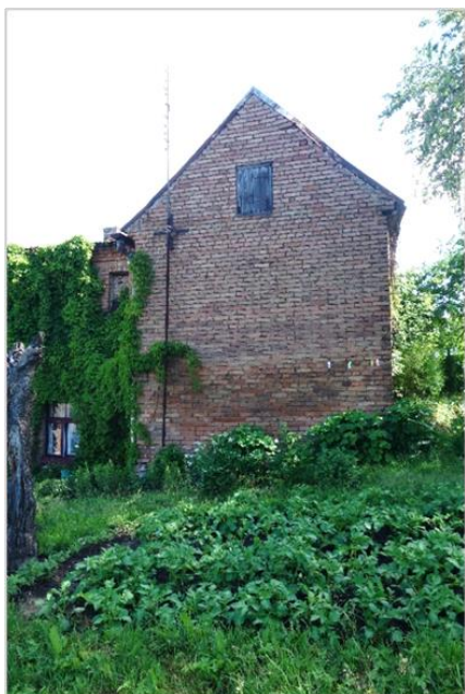
12. attēls. Ēkas DA šķērskorpusa DR fasāde
