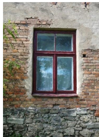
41. attēls. Skats 20. gadsimta 60. gadu logu L1-18 ZA fasādē. Logailai nav izmūrēta pārsedzes ķieģeļu arka un palodze
