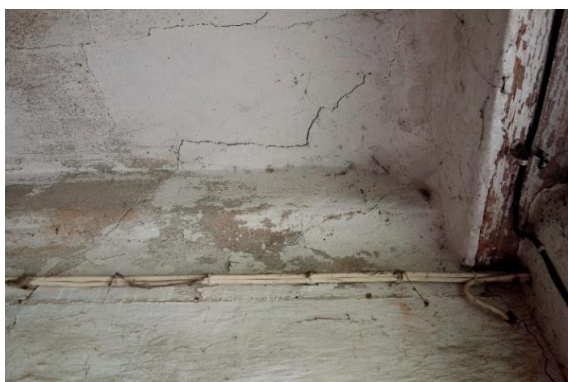
14. attēls. DA gala šķērskorpusa fasādi sadalošā profiljosla, kura pēc pārējās ēkas uzbūvēšanas nonākusi mājas iekšpusē. Skats uz DA
