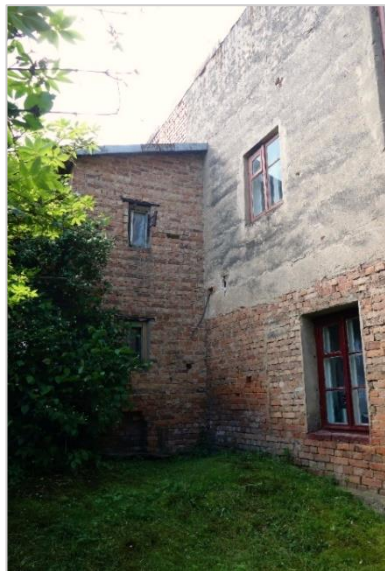
24. attēls. Tuaelesu izbūve celtnes ZA fasādē.
