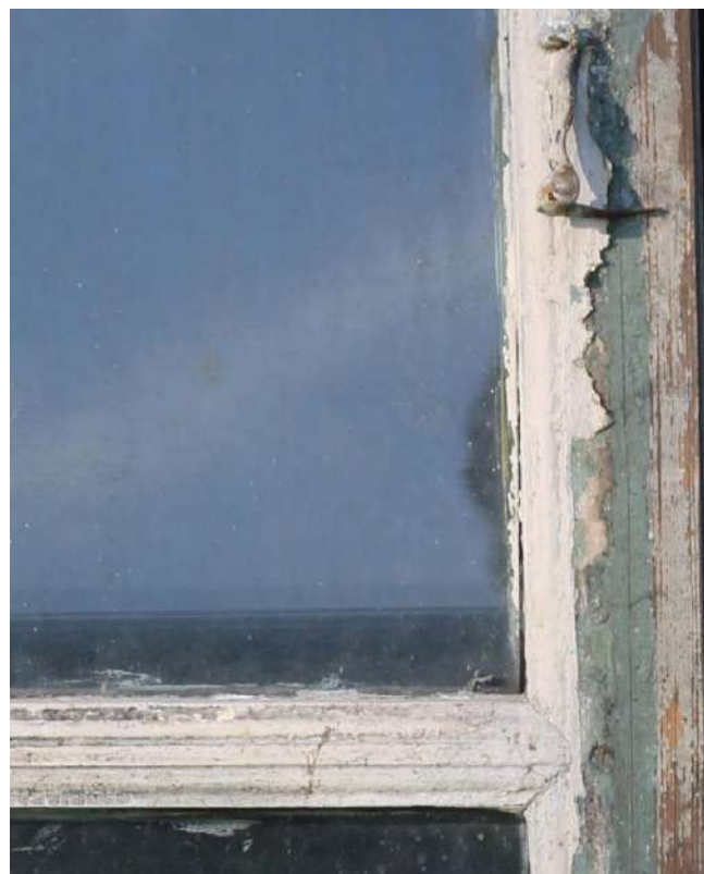
49.fotoattēls. 19.gs. 2.cet. loga vērtnes iekšskats un fragments. Vērtnei mazie fiksatori un kāsis, kas izrauts no aplodas.
