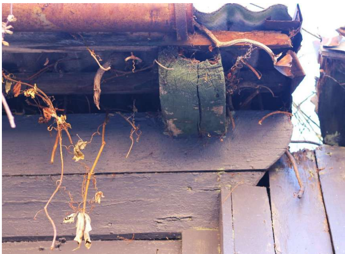
19.fotoattēls. 19.gs.2.cet. piebūves pagalma fasādes stūris ar uzspāres galu un dēļu dzegas S veida noslēgumu.
