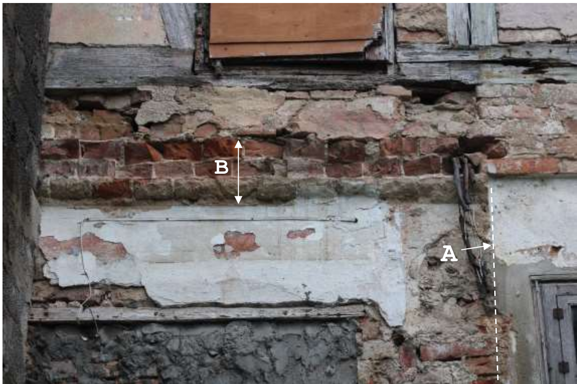
22. fotoattēls. Pagalma fasādes centrālās daļas fragments ar sākotnējā 18. gadsimta otrās puses apjoma stūri (A) un izmūrēto jumta dzegu (B), kas apskaldīta.
