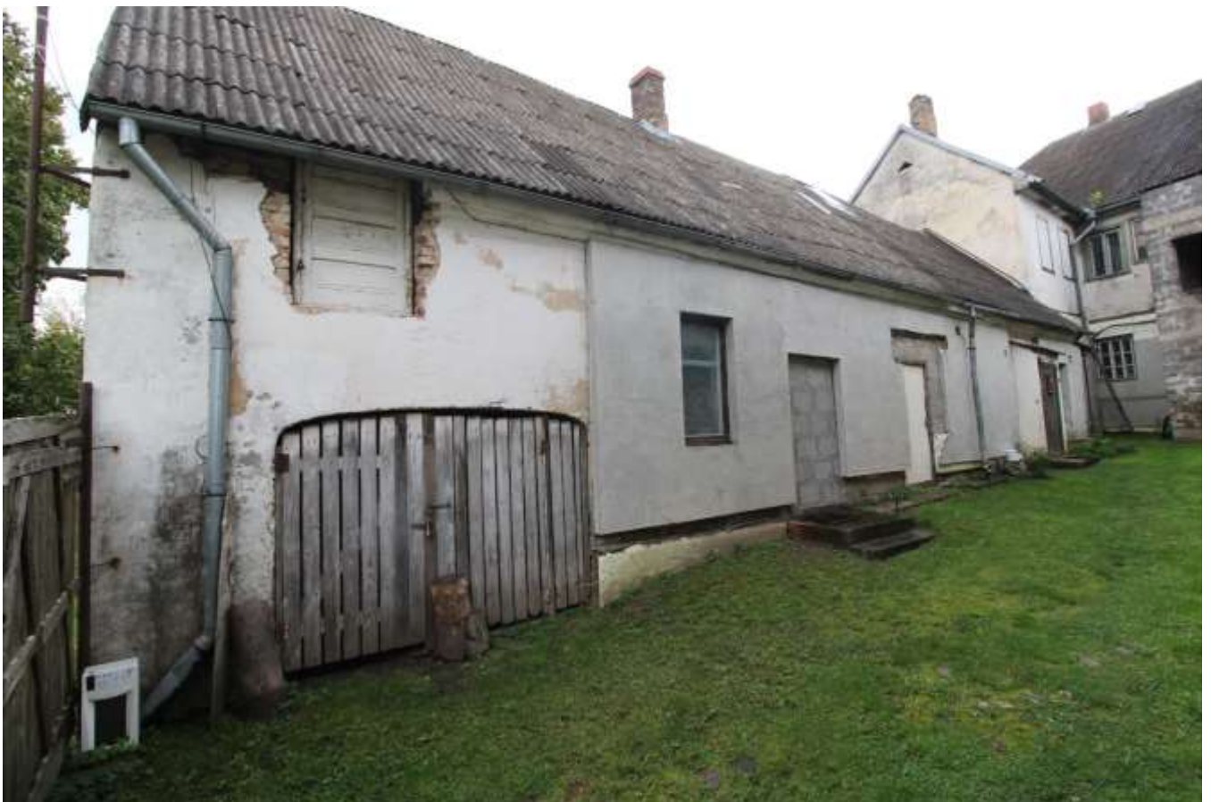
14. fotoattēls. Ēkas 002 skatā no pašreizējās iebrauktuves pagalmā.
