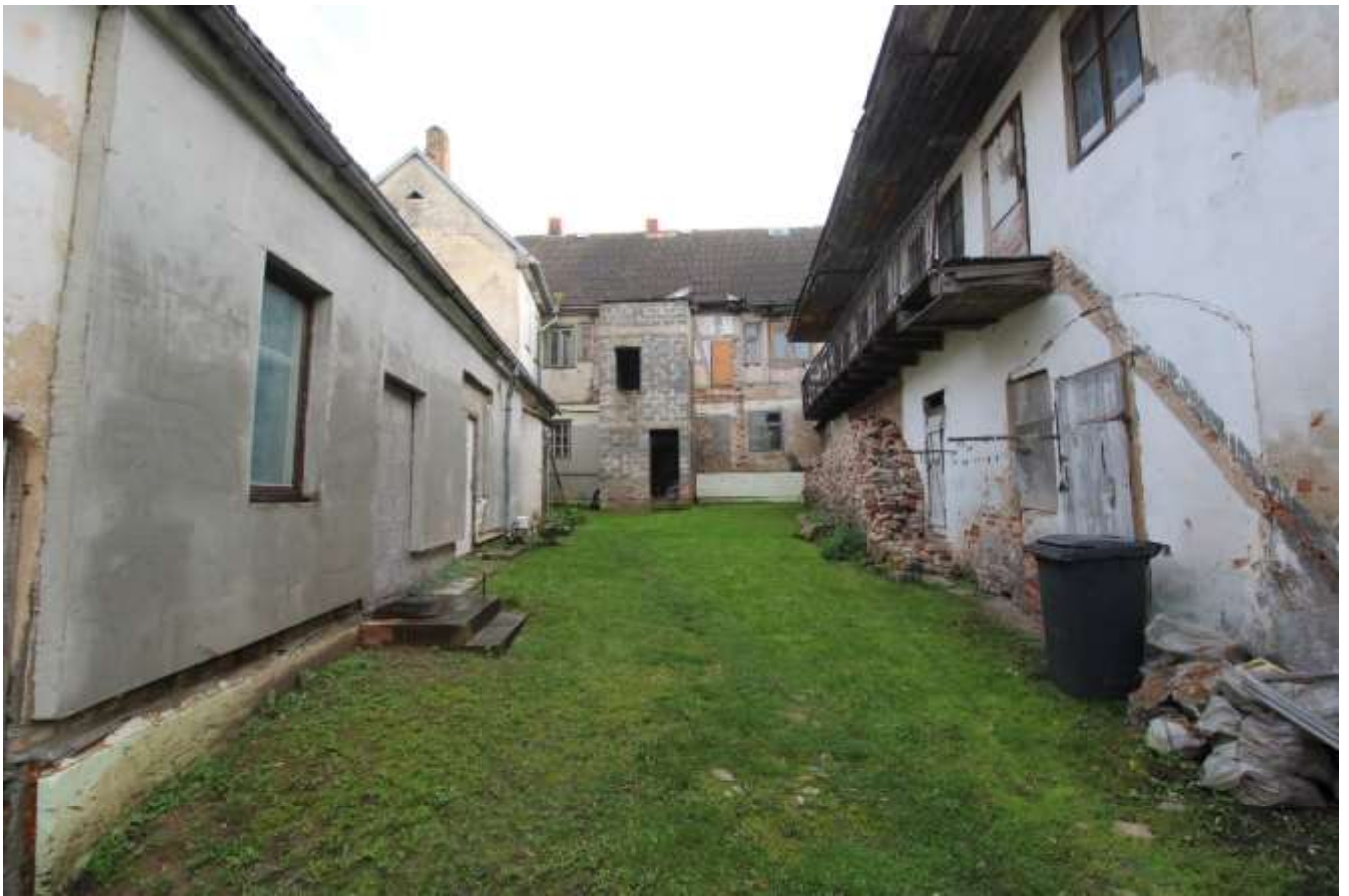
13. fotoattēls. Gruntsgabala esošā apbūve skatā no upes.
