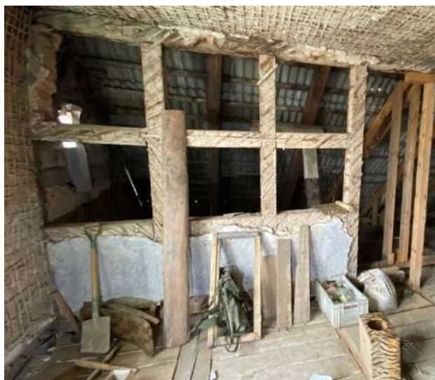
F - 16 Pildrežģa konstrukcijas ēkas jumta stāvā, kā arī 1. stāva apdzīvotajās telpās. Jumta stāvā pildrežģa mūra pildījums daļēji likvidēts – visticamāk, lai atslogotu pārsegumu
