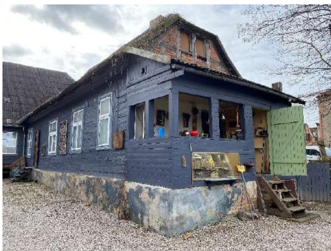
F - 91 Pagalma apjoma fasādes – krāsoti guļšķautņi. Z puses verandai koka dēļu apšuvums. R fasādei krāsojums nolietojies, bojāts. Cokola apdarē izteikti mitruma radīti bojājumi, vairākās zonās novērojama apmetuma atslāņošanās
