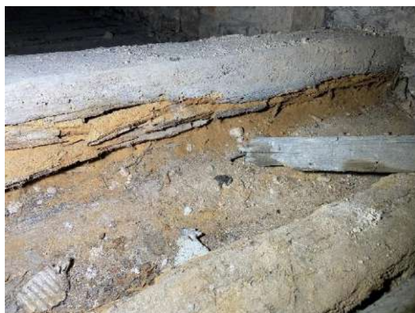
F - 31 Ēkas pamatapjoma R daļā esošajā kopturī, kurā iekārtas pārseguma sijas, redzami apjomīgi koksnes kaitēkļu radīti bojājumi, kopturis zaudējis ievērojamu daļu no efektīvā šķērs griezuma, tā nestspēja ir mazināta
