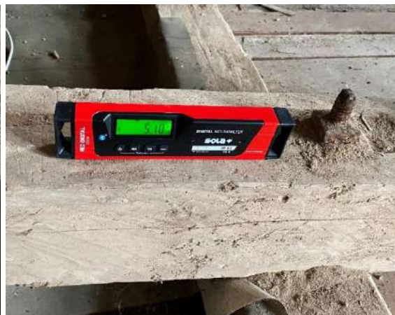
F - 38 Pārsegumam vairākās zonās novērojamas virsnormatīvas izlieces, slīpumi, kas sasniedz ~5 grādus
