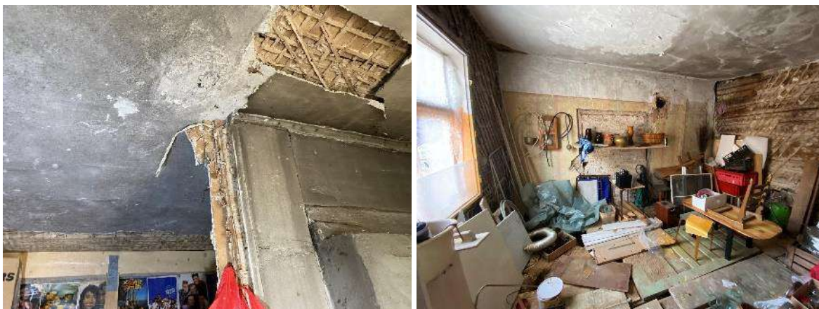
F - 66 Ēkai izbūvētas koka konstrukciju starpsienas, krāšņu, skursteņu zonās – ķieģeļu mūris. Ēkā veiktas pārbūves, t.sk. starpsienās un ailēs
