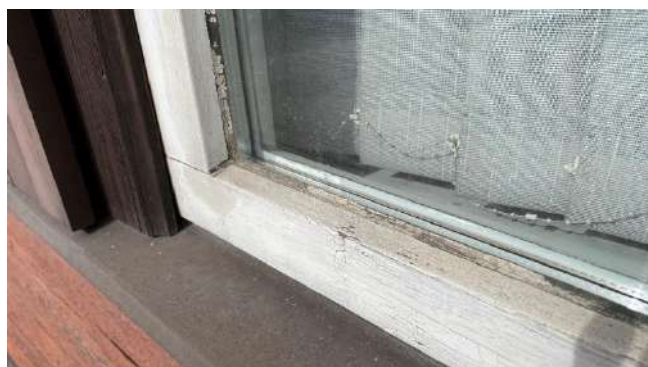
F - 70 Koka pakešlogiem Rīgas ielas fasādē nolietojies krāsojums
