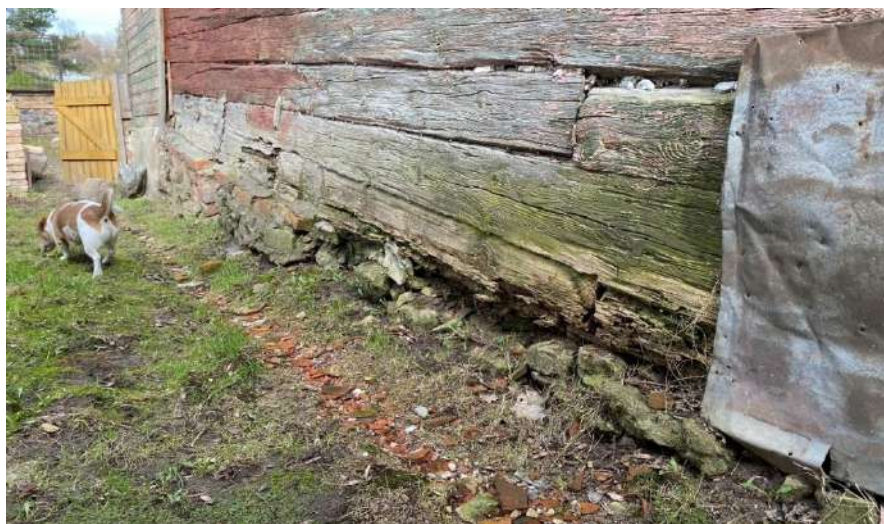
F - 4 Pagalma apjoma cokola mūrī apjomīgi izbrukumi, izteikta mūra erozija, trupējuši sienu vainagšķautņi. Redzams ka nokrišņu ūdens no ēkas jumta (kā arī no blakus ēkas jumta) notek un skalojas gar pamatiem
