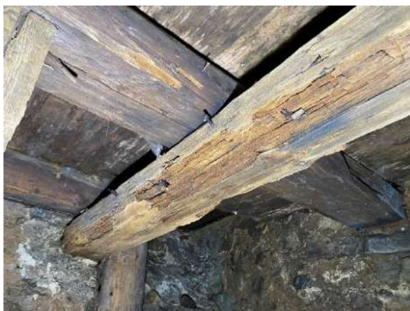
F - 24 Pagraba pārseguma koka pasijā redzami apjomīgi trupes un koksnes kaitēkļu radīti bojājumi
