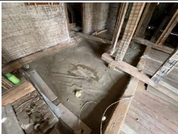
F - 36 Dēļu klājs bēniņu A daļā izveidots daļēji – ne visās zonās. Dažviet uz pārseguma redzami notecējumi
