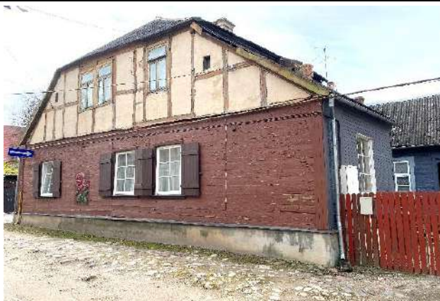
F - 90 Ēkas A puses gala fasādei 1. stāva līmenī krāsots koka dēļu apšuvums, lietota nesaderīga krāsa, tā atslāņojas. Jumta stāva līmenī zelma fasādi veido pildrežģa konstrukcija – koka karkasa daļas krāsotas, ķieģeļu mūra pildījums no ārpuses apmests, krāsots. Pildrežģa apdare nolietojusies, bojāta
