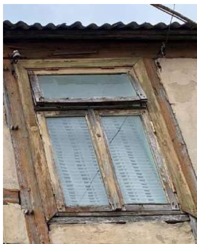
F - 71 Ēkas pamatapjoma A fasādes zelminī esošie koka logi ievērojami bojāti, logiem nav iekšējās vērtnes
