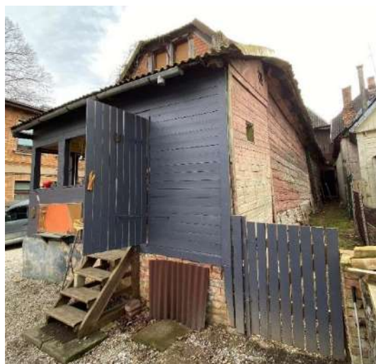
F - 91 Pagalma apjoma fasādes – krāsoti guļšķautņi. Z puses verandai koka dēļu apšuvums. R fasādei krāsojums nolietojies, bojāts. Cokola apdarē izteikti mitruma radīti bojājumi, vairākās zonās novērojama apmetuma atslāņošanās
