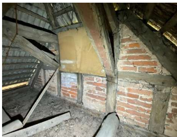
F - 18 Pagalma apjoma Z fasādes zelmiņa pildrežģa koka konstrukcijās apjomīgi trapes bojājumi. Pildrežģī lietoti tapu savienojumi. Skats uz zelmini no bēniņu puses Logailes no bēniņu puses nosegtas ar preskartona loksnēm
