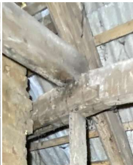
F - 55 Pagalma apjoma jumta konstrukcijas. Zudis atgāznis, augšējā koptura stīķējuma mežglā redzamas deformācijas, tas pabalstīts ar koka dēli
