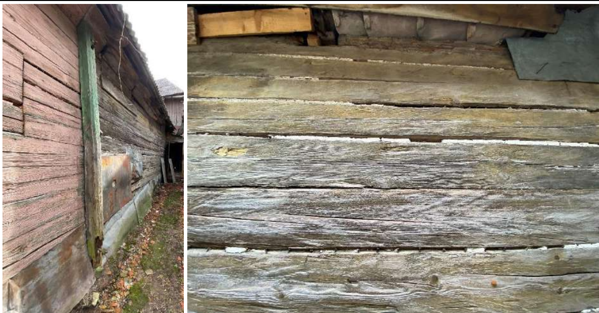
F - 12 Pagalma apjoma R puses sienai satrupējuši apakšējie vainagšķautņi, kā arī vertikālā pastiprinājuma lejas daļa. Sienā deformējusies, tās lejas daļa nosepta ar skārda loksniem. Spraugas starp guļšķautņiem drīvētas ar javu, kas daudzviet izdrupusi, zudusi. Trupes, koksnes kaitēkļu bojājumi dažviet novērojami arī augšējā vainagšķautnī pie jumta dzegas
