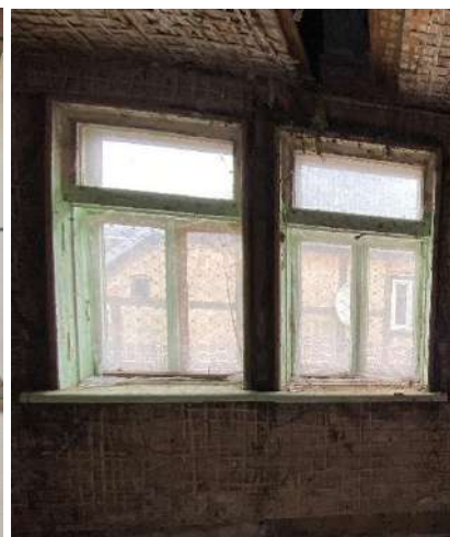
F - 71 Ēkas pamatapjoma A fasādes zelminī esošie koka logi ievērojami bojāti, logiem nav iekšējās vērtnes
