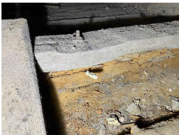
F - 31 Ēkas pamatapjoma R daļā esošajā kopturī, kurā iekārtas pārseguma sijas, redzami apjomīgi koksnes kaitēkļu radīti bojājumi, kopturis zaudējis ievērojamu daļu no efektīvā šķērs griezuma, tā nestspēja ir mazināta
