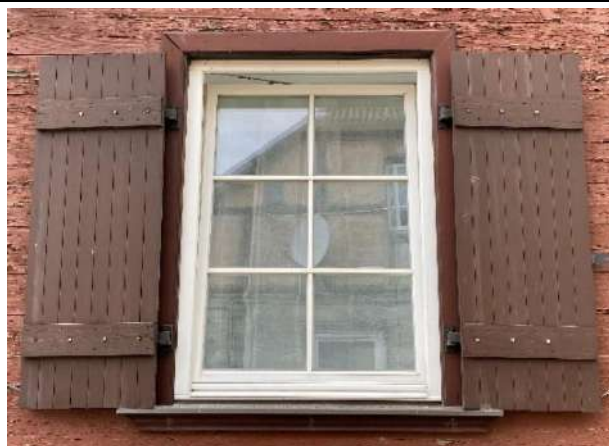
F - 69 Ēkas pamatapjoma pirmā stāva logailās redzami atšķirīgi pakešlogi ar uzlīmētām līstēm, kas veido loga dalījumu. Logiem izbūvēti koka slēgi
