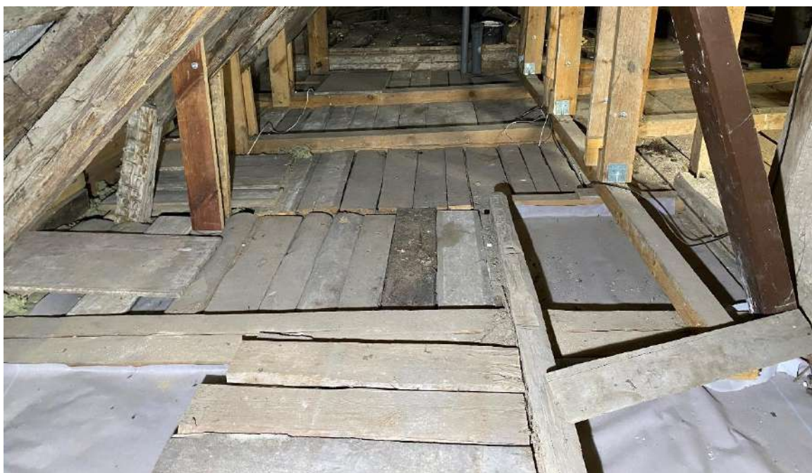
F - 32 Daļā ēkas pamatapjoma pārseguma sijas mainītas, izbūvēts pārseguma siltinājums, virs tā – dēļu klājs
