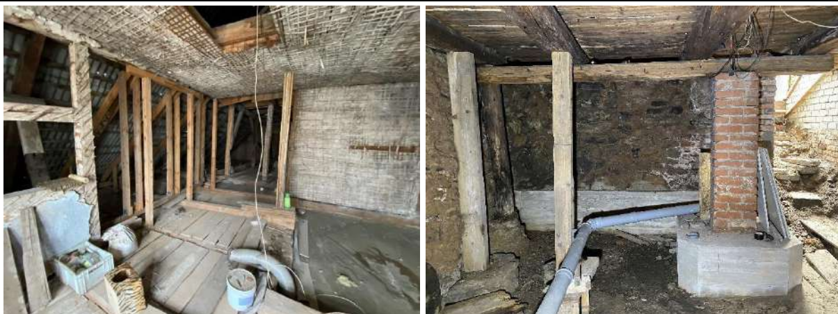
F - 44 Ēkas jumta stāvā un pagrabā izbūvētas papildus pagaidu balstkonstrukcijas, lai novērstu bīstamību
