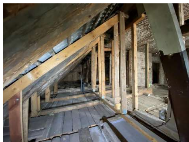
F - 49 Ēkas pamatapjoma jumta stāvā savulaik demontēta daļa no jumta nesošajām konstrukcijām. Lai novērstu bīstamību, izbūvētas papildus balstošās jumta konstrukcijas – kopturi, statņi, spāru pastiprinājumi. Daļā ēkas mainītas arī pārseguma konstrukcijas. Pastiprinošās konstrukcijas izbūvētas no zāģmateriāliem, lietojot bultskrūvju un metāla lēņsavienojumus
