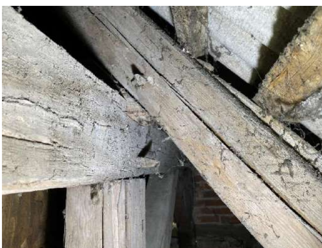
F - 48 Ēkas pamatapjoma jumta slīpums ~45 grādi. Jumta konstrukcijas būvētas no tēstiem kokmateriāliem, lietojot tradicionālos būvkoku savienojumus ar tapām
