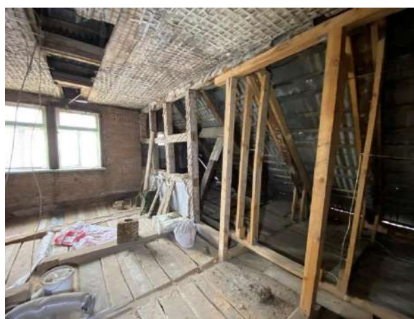
F - 49 Ēkas pamatapjoma jumta stāvā savulaik demontēta daļa no jumta nesošajām konstrukcijām. Lai novērstu bīstamību, izbūvētas papildus balstošās jumta konstrukcijas – kopturi, statņi, spāru pastiprinājumi. Daļā ēkas mainītas arī pārseguma konstrukcijas. Pastiprinošās konstrukcijas izbūvētas no zāģmateriāliem, lietojot bultskrūvju un metāla lēņsavienojumus
