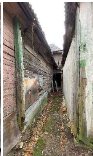
F - 4 Pagalma apjoma cokola mūrī apjomīgi izbrukumi, izteikta mūra erozija, trupējuši sienu vainagšķautņi. Redzams ka nokrišņu ūdens no ēkas jumta (kā arī no blakus ēkas jumta) notek un skalojas gar pamatiem
