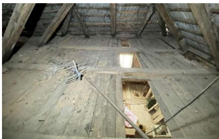
F - 41 Virs spāru saišķiem daļā bēniņu izbūvēts dēļu klājs
