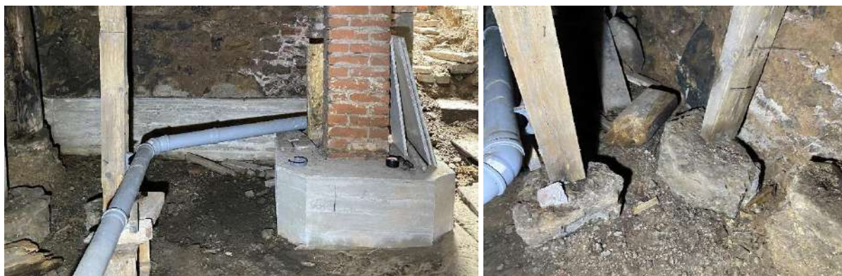
F - 7 Zonā pie pagraba ieejas veikta pamatu pastiprināšana, veidojot piebetonējumu. Betonēts arī stabveida pamats mūra kolonnai, kas balsta pārseguma pasiju. Pagrabā izbūvētas papildus koka stutes, kuras balstītas uz atsevišķiem akmeņiem
