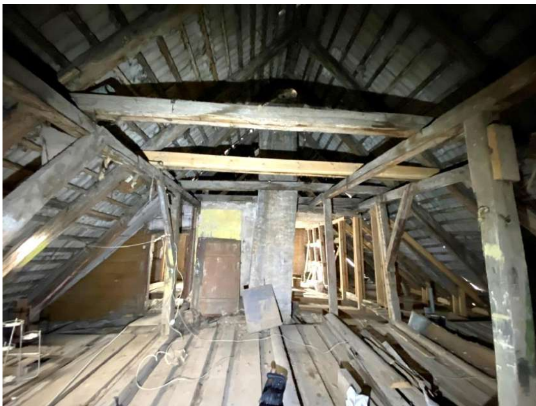
F - 46 Ēkas pamatapjoma jumta koka konstrukcijas ar taisnajiem jumta krēsliem
