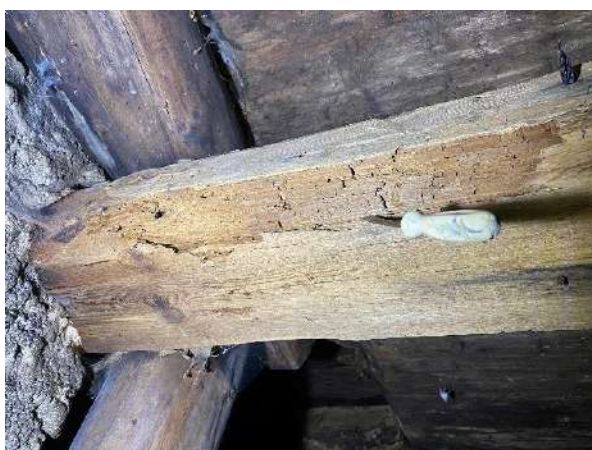
F - 25 Pagraba pārseguma koka pasijā redzami apjomīgi trupes un koksnes kaitēkļu radīti bojājumi
