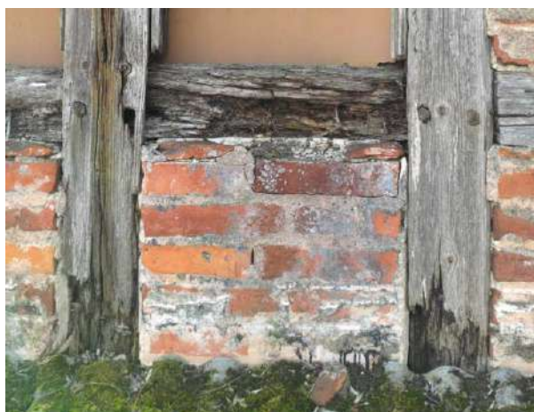
F - 18 Pagalma apjoma Z fasādes zelmiņa pildrežģa koka konstrukcijās apjomīgi trapes bojājumi. Pildrežģī lietoti tapu savienojumi. Skats uz zelmini no bēniņu puses Logailes no bēniņu puses nosegtas ar preskartona loksnēm
