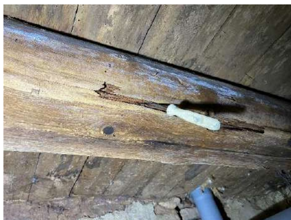
F - 25 Pagraba pārseguma koka pasijā redzami apjomīgi trupes un koksnes kaitēkļu radīti bojājumi
