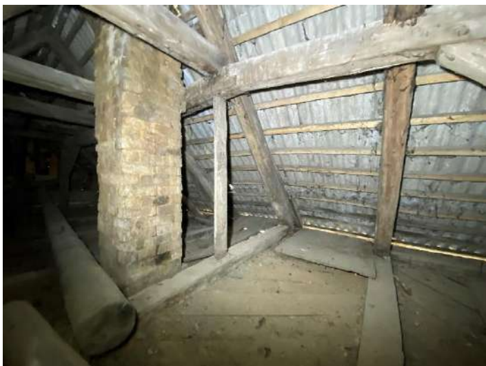
F - 55 Pagalma apjoma jumta konstrukcijas. Zudis atgāznis, augšējā koptura stīķējuma mežglā redzamas deformācijas, tas pabalstīts ar koka dēli
