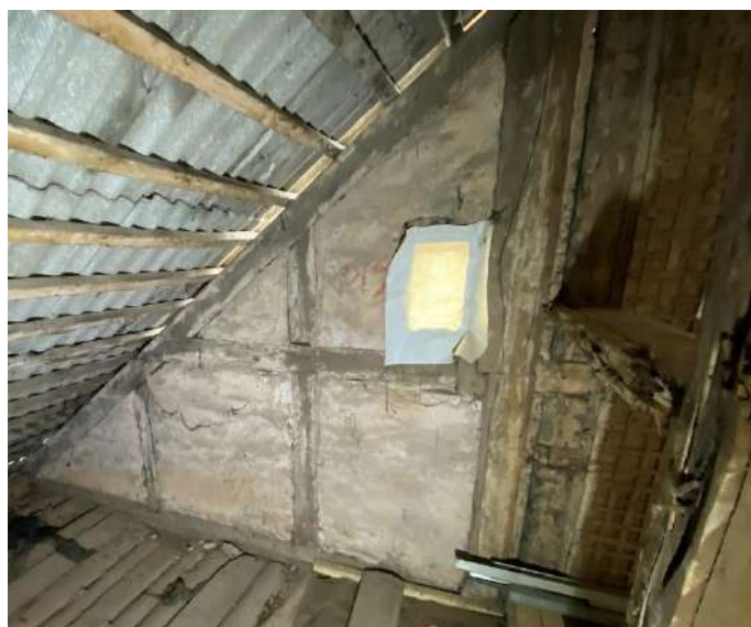
F - 15 Pildrežģa apmetuma apdarē redzami lokāli bojājumi, nestabili apdares fragmenti. Skats uz pildrežģa zelmini no ēkas bēniņiem
