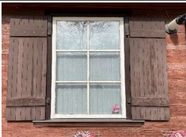
F - 69 Ēkas pamatapjoma pirmā stāva logailās redzami atšķirīgi pakešlogi ar uzlīmētām līstēm, kas veido loga dalījumu. Logiem izbūvēti koka slēgi
