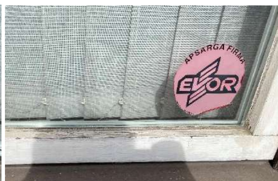
F - 70 Koka pakešlogiem Rīgas ielas fasādē nolietojies krāsojums
