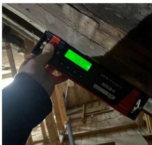
F - 48 Ēkas pamatapjoma jumta slīpums ~45 grādi. Jumta konstrukcijas būvētas no tēstiem kokmateriāliem, lietojot tradicionālos būvkoku savienojumus ar tapām
