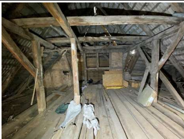
F - 47 Taisnie jumta krēsli, demontēti/zuduši vairāki koka atgāžņi u.c. konstruktīvie elementi
