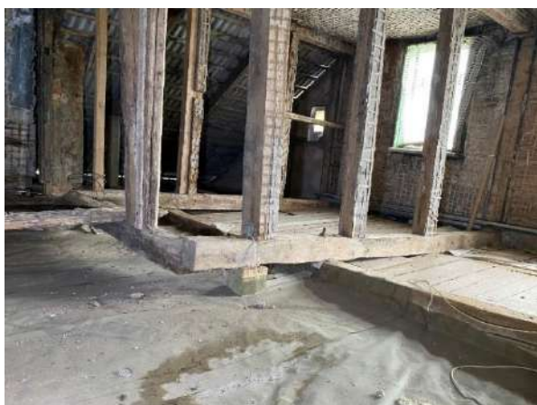
F - 37 Ēkas pamatapjoma A daļā pārsegumam redzamas izteiktas deformācijas, nav izveidoti atbilstoši būvkoku savienojumi, to nestspēja un telpiskā noturība ir apšaubāma
