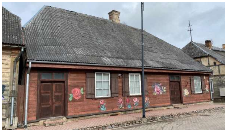
F - 89 Ēkas galvenā – Rīgas ielas fasāde. Fasādes apdari veido krāsots koka dēļu apšuvums
