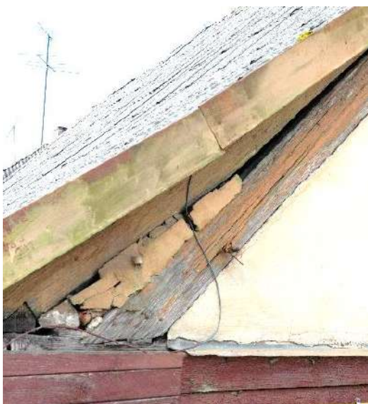
F - 15 Pildrežģa apmetuma apdarē redzami lokāli bojājumi, nestabili apdares fragmenti. Skats uz pildrežģa zelmini no ēkas bēniņiem
