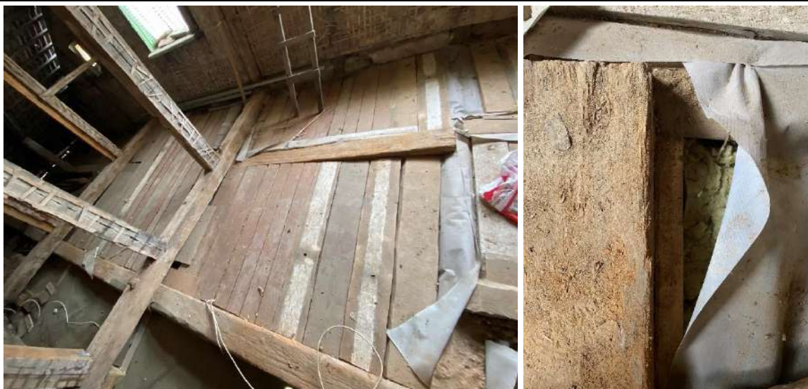
F - 21 Daļā bēniņu (virs 1. stāva apdzīvotās ēkas daļas) pārsegums siltināts ar minerālvati, virs tās klāta difūzijas membrāna un izveidots dēļu klājs
