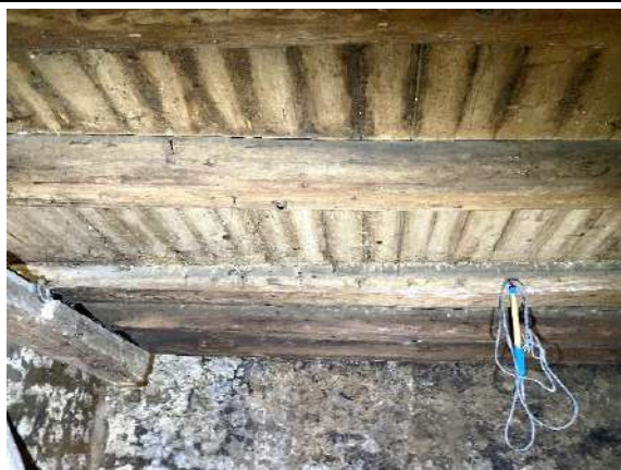
F - 23 Lielākajā daļā pagraba pārsegumu veido koka sijas, kas balsfītas mūra sienās. Pārseguma sijām redzami trupes, koksnes kaitēkļu bojājumi, lai tās pabalstītu, izbūvēti koka statņi un pasijas, kas balstās sienās, kā arī uz mūra stabiem. Trupes un koksnes kaitēkļu bojājumi redzami arī pasijās, dažviet arī balstošajos statņos
