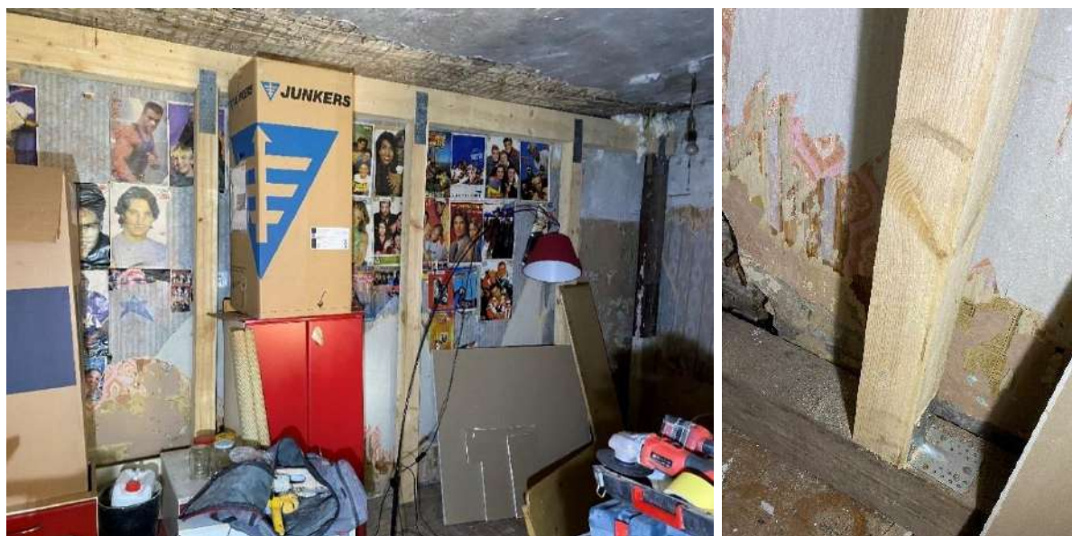
F - 13 Ēkas iekšpusē pie ārsienas izbūvēts papildus balstošais koka karkass
