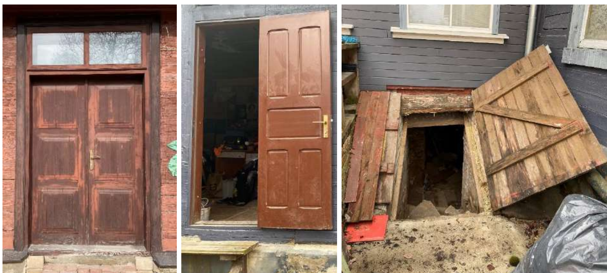
F - 73 Koka pildīņu ārdurvis Rīgas ielas un pagalma fasādēs. Noejai pagrabā izbūvētas dēļu durvis, tām lokāli trupes bojājumi
