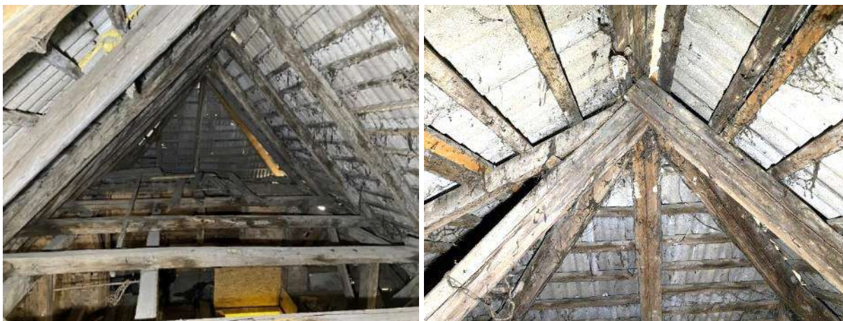
F - 52 Ēkas pamatapjoma jumta konstrukcijas – divslīps jumts ar nošļauptām jumtgalēm. Virs spārēm izbūvētas koka latis un vijņoto azbestcimenta lokšņu segums
