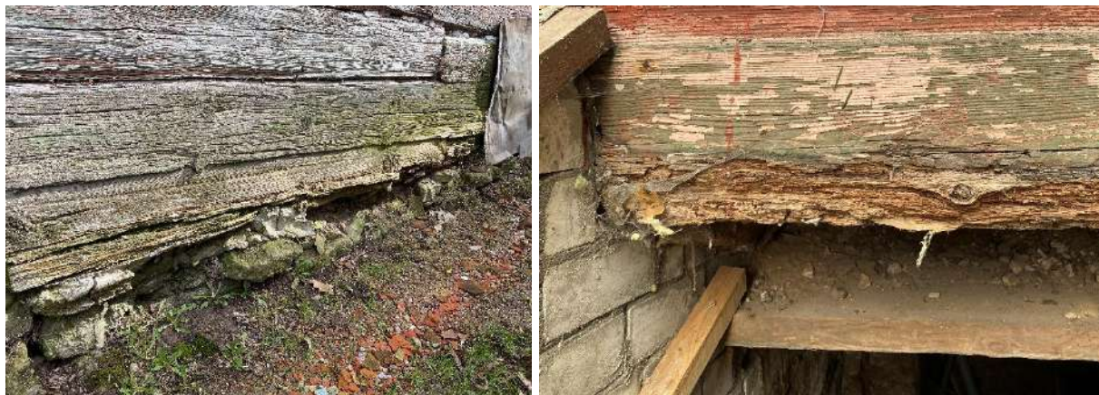
F - 9 Pagalma puses apjoma R sienai lejas daļā apjomīgi trupes bojājumi, starp virspamatiem un apakšējo vainagšķautni nav redzama horizontālā hidroizolācija. Trupes, koksnes kaitēkļu radīti bojājumi guļšķautnī virs pagraba noejas
