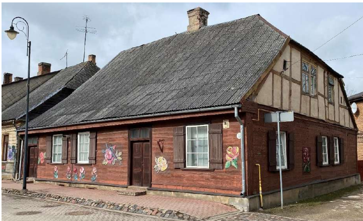
F - 10 Ēkas ārsienas 1. stāva līmenī veido koka guļšķautņi ar gludajiem pakšiem. Pamatapjoma ārsienām koka dēļu apšuvums. Jumta stāva līmenī zeltiņi izbūvēti pildrežģa konstrukcijās
