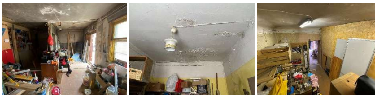
F - 88 Pagalma apjoma iekštelpu apdare nolietojusies, ievērojami bojāta, dažviet sienām veidots OSB plākšņu apšuvums
