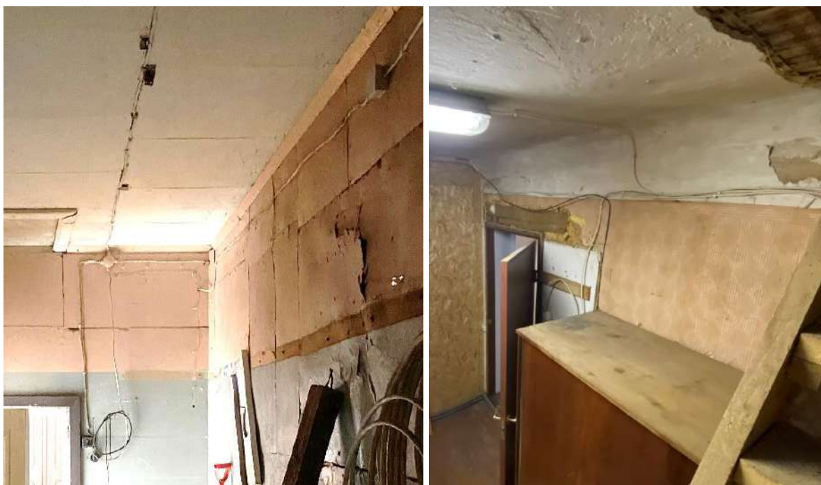
F - 81 Vairākās zonās elektrokabeļi nokarājas, nav attiecīgi nostiprināti
