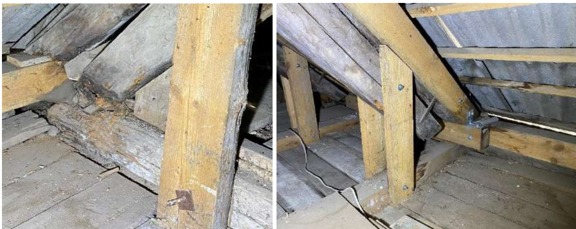
F - 33 Atsevišķu pārseguma siju galos redzami trupes bojājumi. Sākotnēji spāru gali balsfīti siju galos. Zonās, kur pārseguma sijas mainītas, spāres siju galos vairs netiek balsfītas, spāres pret sijām atbalsfītas ar abpusēju koka uzliku palīdzību
