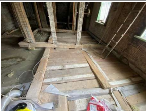
F - 36 Dēļu klājs bēniņu A daļā izveidots daļēji – ne visās zonās. Dažviet uz pārseguma redzami notecējumi
