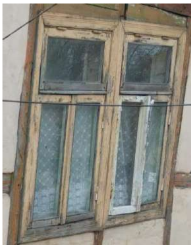
F - 71 Ēkas pamatapjoma A fasādes zelminī esošie koka logi ievērojami bojāti, logiem nav iekšējās vērtnes
