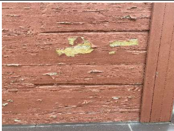
F - 90 Ēkas A puses gala fasādei 1. stāva līmenī krāsots koka dēļu apšuvums, lietota nesaderīga krāsa, tā atslāņojas. Jumta stāva līmenī zelma fasādi veido pildrežģa konstrukcija – koka karkasa daļas krāsotas, ķieģeļu mūra pildījums no ārpuses apmests, krāsots. Pildrežģa apdare nolietojusies, bojāta
