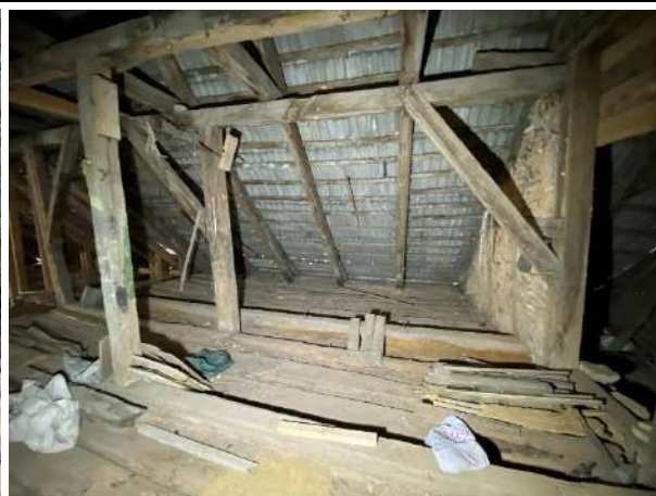
F - 47 Taisnie jumta krēsli, demontēti/zuduši vairāki koka atgāžņi u.c. konstruktīvie elementi
