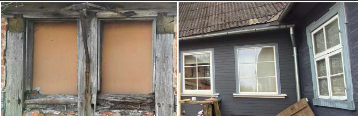
F - 72 Pagalma apjoma Z fasādes zelnīnī ailu aizpildījumi zuduši, ailes nosegtas ar preskartona loksnēm. Pagalma apjomam koka groplogi, pamatapjoma pagalma fasādē – pakešlogi
