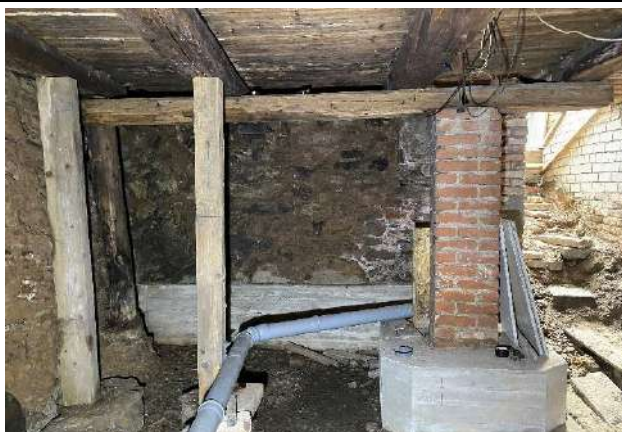
F - 23 Lielākajā daļā pagraba pārsegumu veido koka sijas, kas balsfītas mūra sienās. Pārseguma sijām redzami trupes, koksnes kaitēkļu bojājumi, lai tās pabalstītu, izbūvēti koka statņi un pasijas, kas balstās sienās, kā arī uz mūra stabiem. Trupes un koksnes kaitēkļu bojājumi redzami arī pasijās, dažviet arī balstošajos statņos
