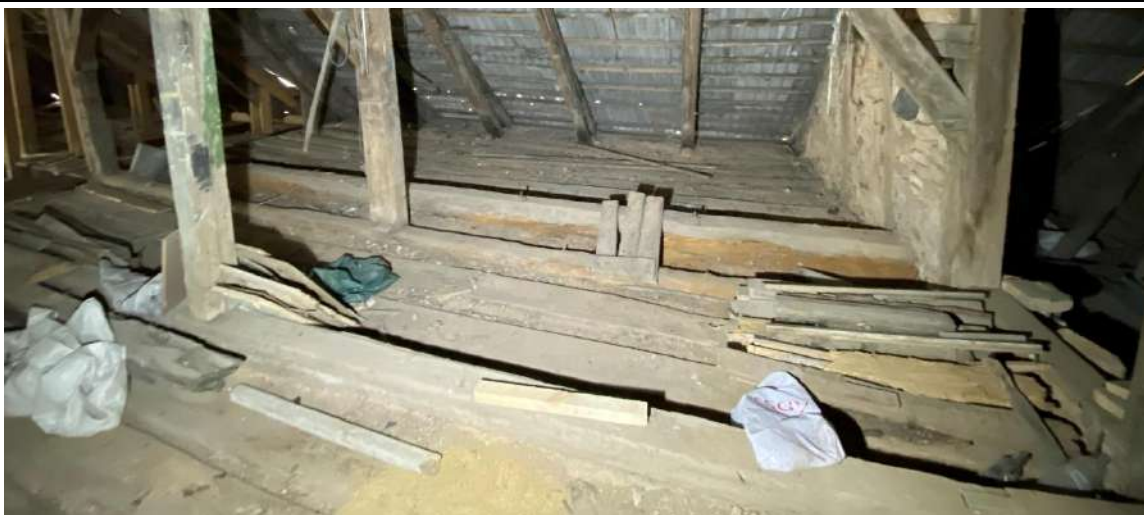
F - 30 Ēkas pamatapjoma R daļā virs sijām izbūvēts koka kopturis, kurā pārseguma sijas iekārtas
