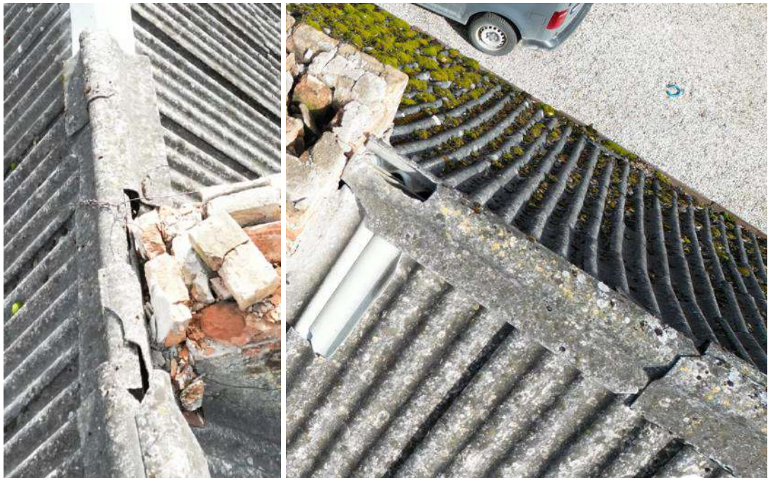
F - 59 Pagalma apjoma jumtam kore segta azbestcimenta šiferi, dažviet arī skārdu. Šifera kores elementos pie skursteņiem redzami apjomīgi bojājumi
