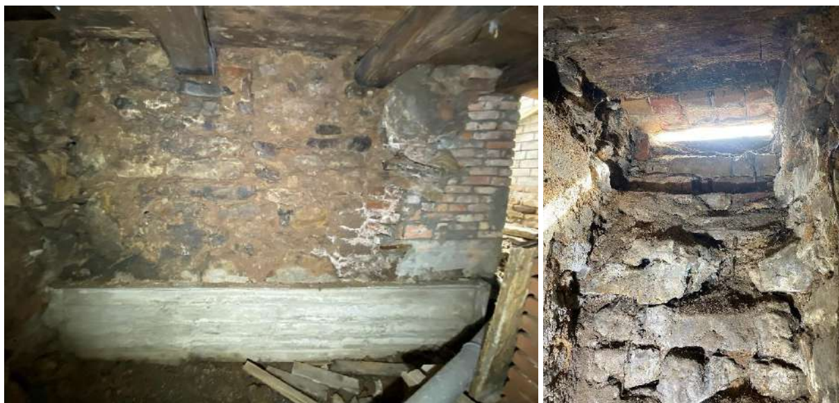
F - 1 Pagraba sienas – jauktā mūra lentveida pamati. Ēkas ZA stūrī pamatiem pagrabā veikts piebetonējums. Vēdināšanas atvere Rīgas ielas fasādes cokoldaļā skatā no pagraba puses
