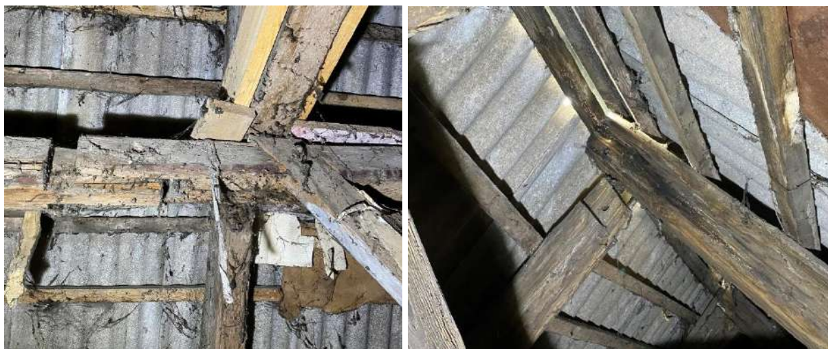
F - 43 Vairāķās zonās izklāvuķķķs jumta konstrukciju mezķķļķ
