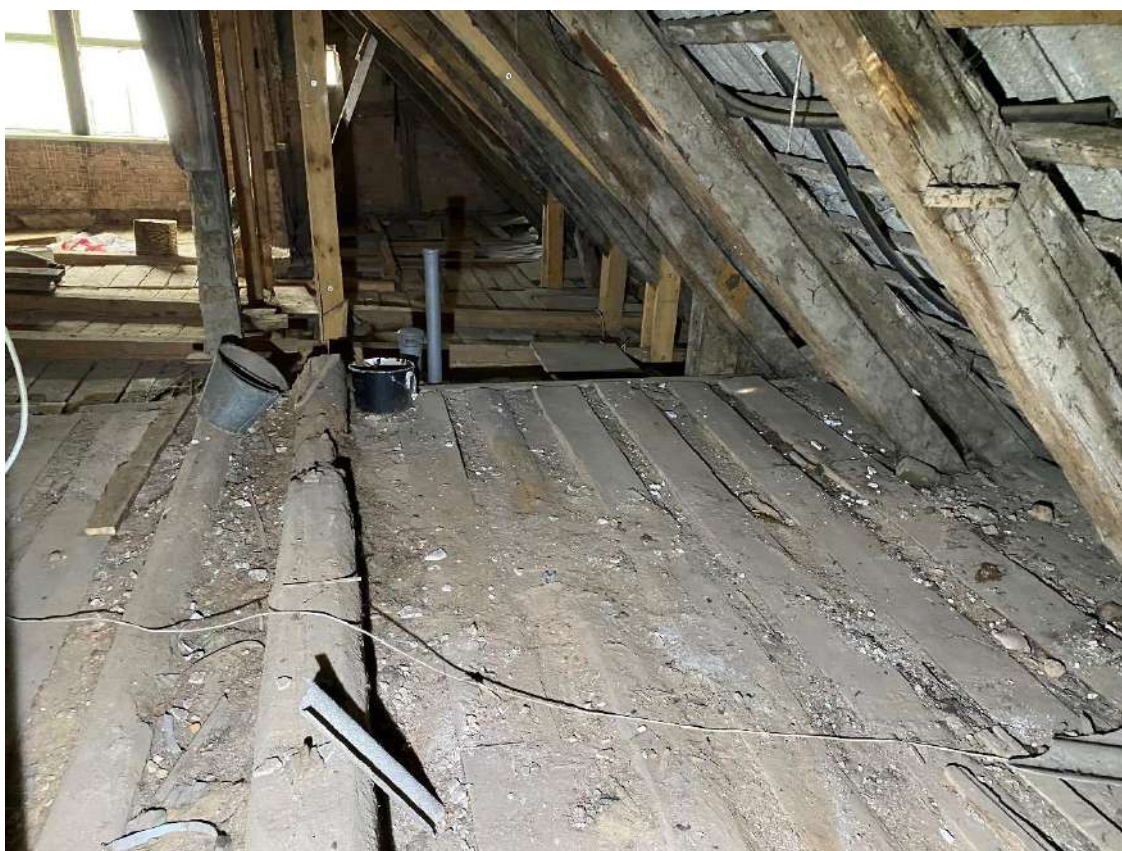
F - 29 Pārsegumu veido koka sijas. Virs sijām veidots dēļu klājs. Ēkas pamatapjoma A daļā pārseguma sijas mainītas
