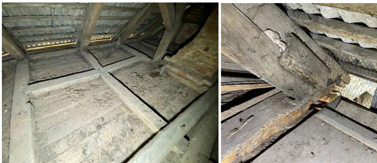
F - 40 Pagalma apjoma pārsegumam dažviet novērojamas virsnormatīvas izlieces, deformācijas. Atsevišķi siju gali trupējusi
