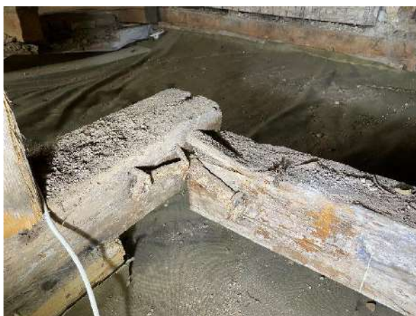
F - 37 Ēkas pamatapjoma A daļā pārsegumam redzamas izteiktas deformācijas, nav izveidoti atbilstoši būvkoku savienojumi, to nestspēja un telpiskā noturība ir apšaubāma
