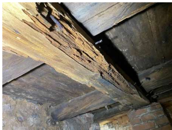
F - 24 Pagraba pārseguma koka pasijā redzami apjomīgi trupes un koksnes kaitēkļu radīti bojājumi
