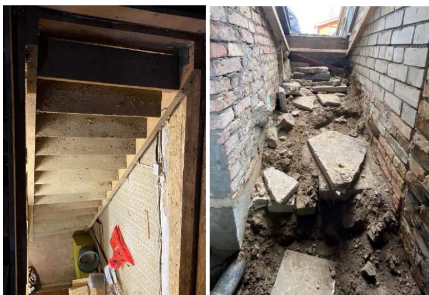
F - 64 Koka kāpnes, kas ved uz bēniņiem. Pagraba noejai kāpņu vietā izveidots būvgružu krāvējs
