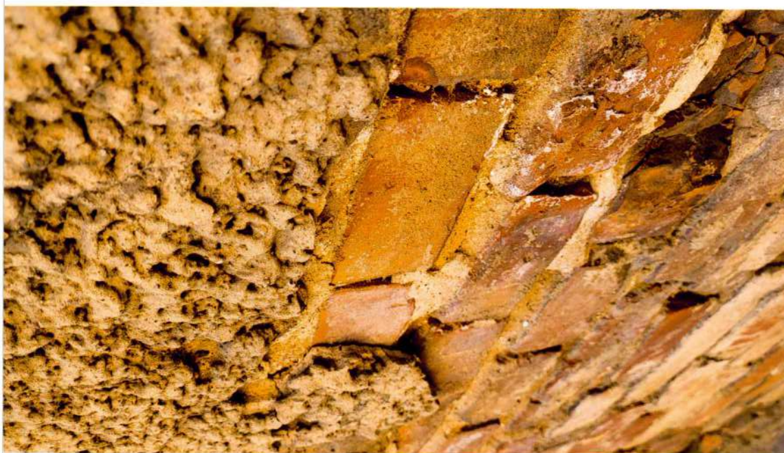
20. attēls. Ielas fasādes fragments sienas lejasdaļā: zudis apmetums, uz ķieģeļu virsmas izdalījušies sāļu kristāli.
