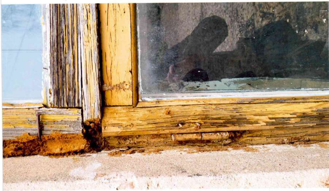
31. attēls. Loga L-1 fragments. Saglabājušos koka logu restaurēšanas vai nomaiņas iespējas izvērtējamās katram logam atsevišķi.
