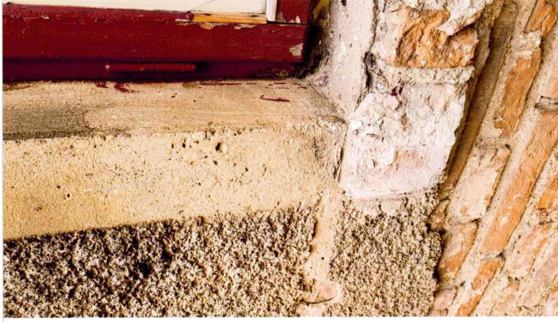
13. attēls. Ķieģeļu sienas apmetuma apdare pie loga ailes. Apmale veidota ar gludu kaļķu apmetuma virsmu, krāsota gaišā smilšu tonī. Tikai palodzei ķieģeļi mūrēti ar izvirzījumu no sienas plaknes. Sienas plakne apmesta ar uzšlakstījuma kārtu pelēkā tonī, atstājot gludas šuves starp grumbulainiem laukumiem.
