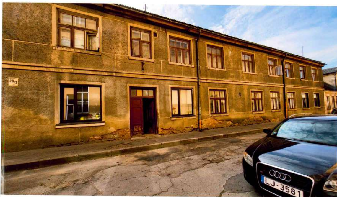
11. attēls. Ielas fasādes kopskats. Saglabājušās sākotnējās koka ārdurvis D-1 ar virslogu un 2.stāvā visas ailēs koka logi.
