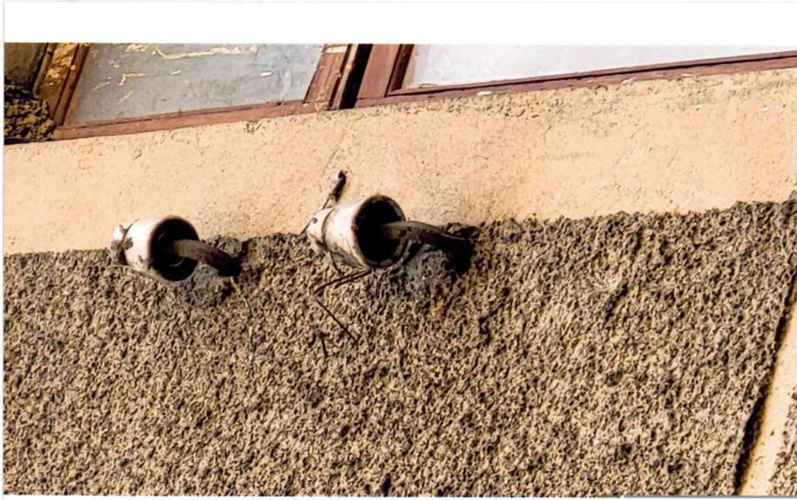
18. attēls. Ielas fasādē saglabājušies elektrības vadu izolatori metāla āķos.
