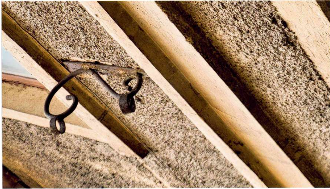
16. attēls. Ielas fasādes fragments ar kalnu metāla karoga turētāju. Fasādes plastiks veidota ar ķieģeļu izmūrētām logu palodzēm un starpstāvu dzegu. Izvirzītās detaļas apmetas ar gludu kaļķu javas apmetumu.
