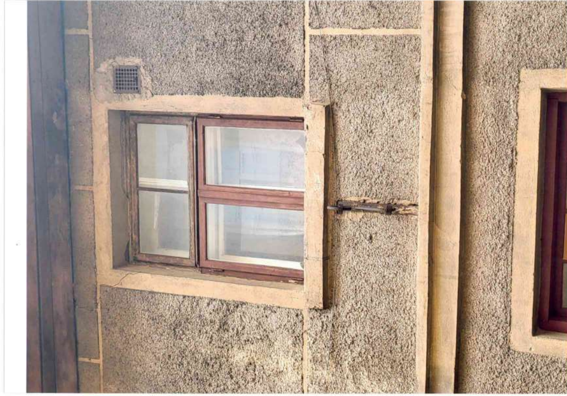
14. attēls. Koka logs L-2 (105x160(h)) ielas fasādes 2.stāvā.
