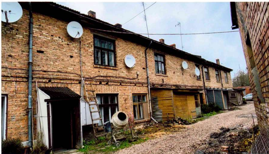
29. attēls. Iekšpagalma fasādes kopskats no DR puses. Fasādes vidusdaļā ķieģeļu mūrim (iespējams, iepriekšējā būvperioda apjoma daļa) izmantoti atšķirīgi māla ķieģeļi, mūrējums izšuvots, virs logu ailēm ķieģeļu pārsedzes.
