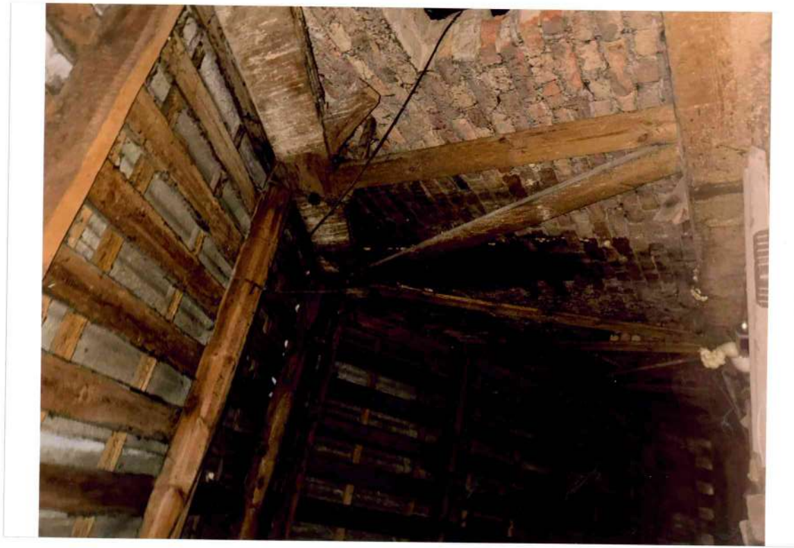
37.attēls. Jumta koka konstrukcijas pie mūra galasienas.
