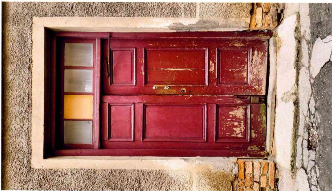
22. attēls. Saglabājušās koka pildīņu ārdurvis ar virslogu D-1. Kopskats no ārpuses.
