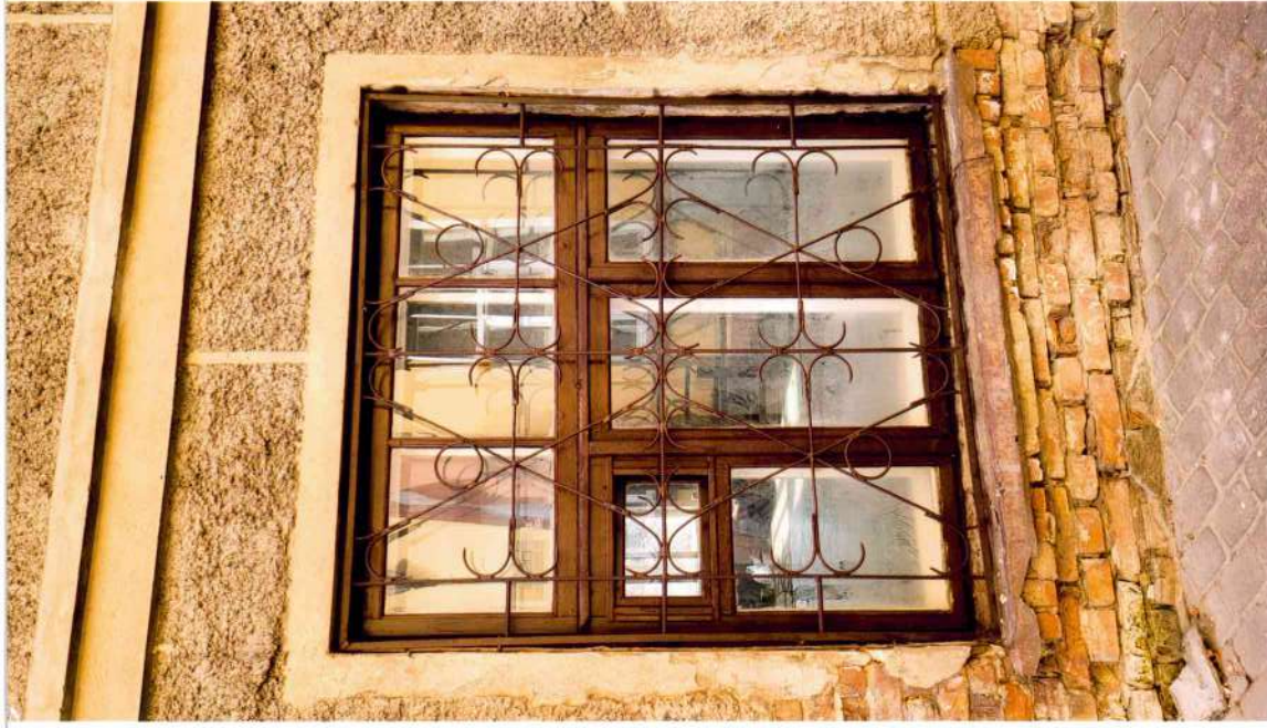
12. attēls. Koka logs L-1 (172x160(h)) ar vēdlodziņu ielas fasādes 1.stāvā.
