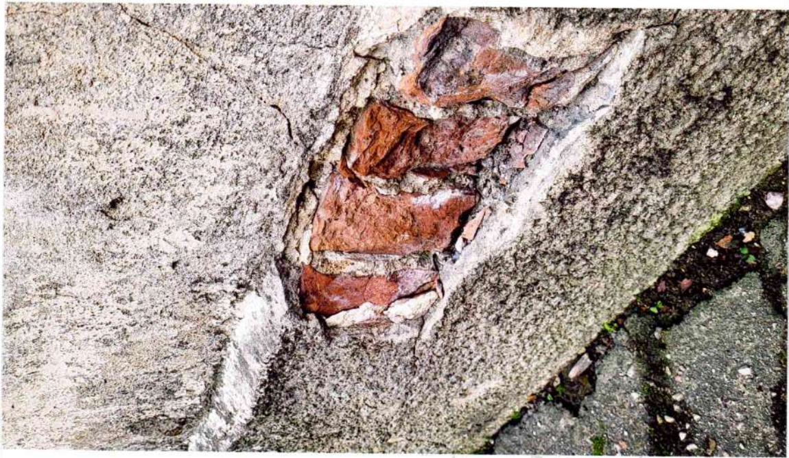
16. attēls. Ēkas cokols mūrēts no ķieģeļiem, apmests ar kaļķu javu, virsējais apmetuma slānis- cements. Fragmentis ielas fasāde.
