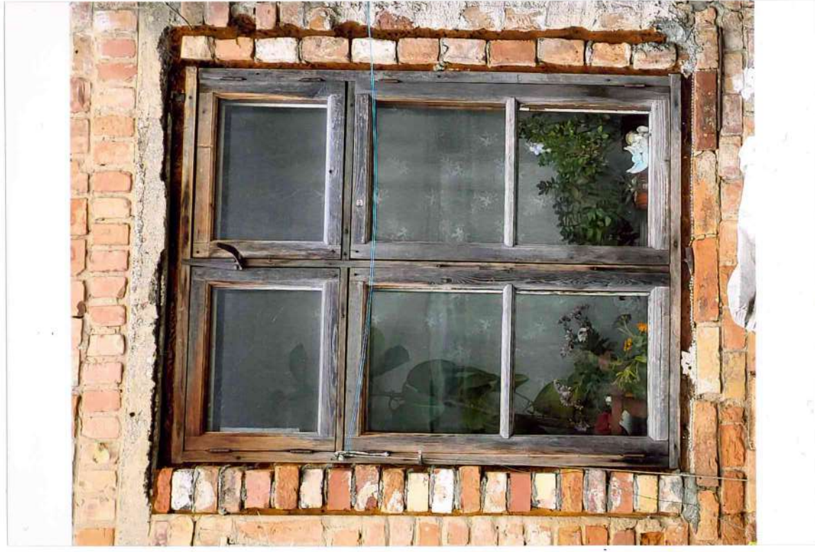
22. attēls. Iekšpagalma fasādes 1.stāva logs L-3 ( 2.no kreisās puses) ir četru vērtnu koka groplogs, izgatavots 20.gs. beigās.
