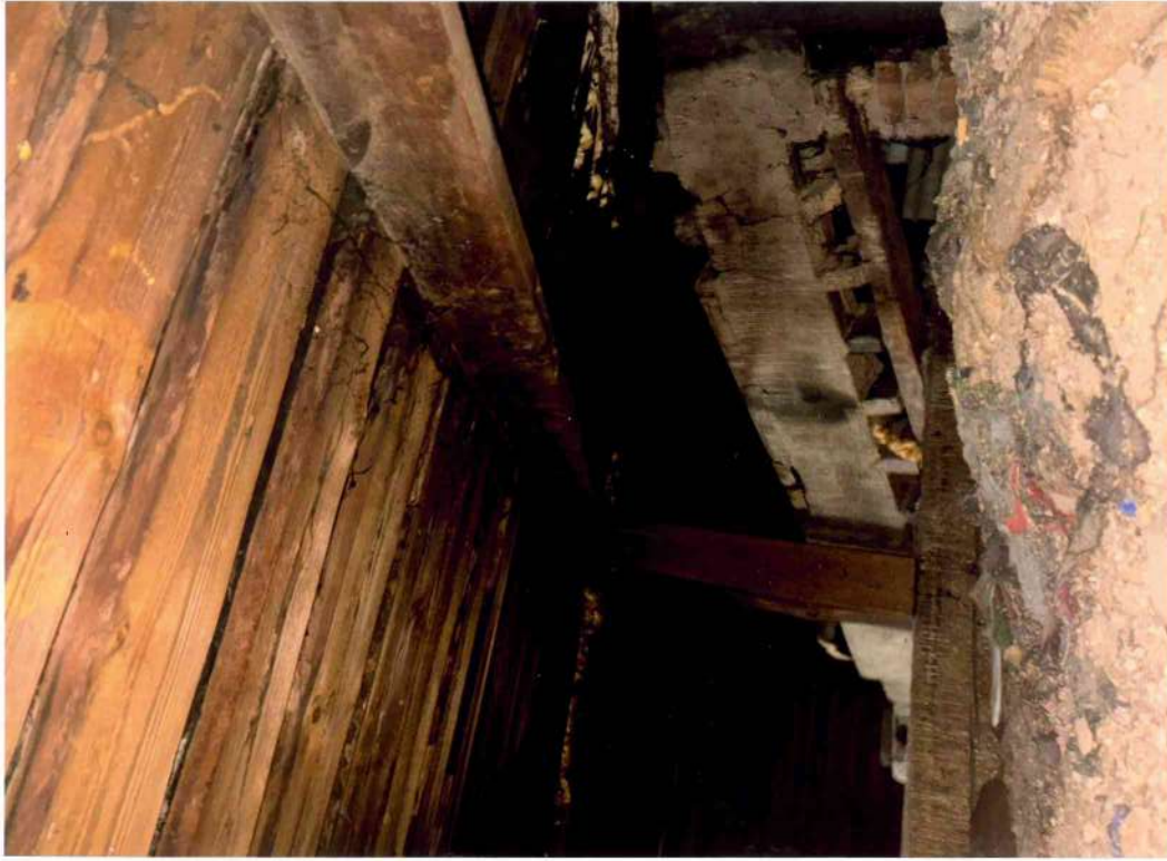
30.attēls. Mezonīna bēniņtelpa. Saglabājusies sākotnējā jumta konstrukcija: centrālais kopturis zem mezonīna kores ar spāru vertilāko balstu, jumta seguma pamatne - dēļu klājs. Apmesta mūra dūmvada horizontālais posms.
