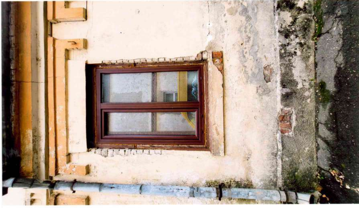
15. attēls. 1.stāva logs pa labi no ārdurvīm. Ielas fasādē visas logailēs, izņemot vienu 1.stā un vienu mezonīnā, iebūvēti atšķirīgi PVC izstrādājumi.
