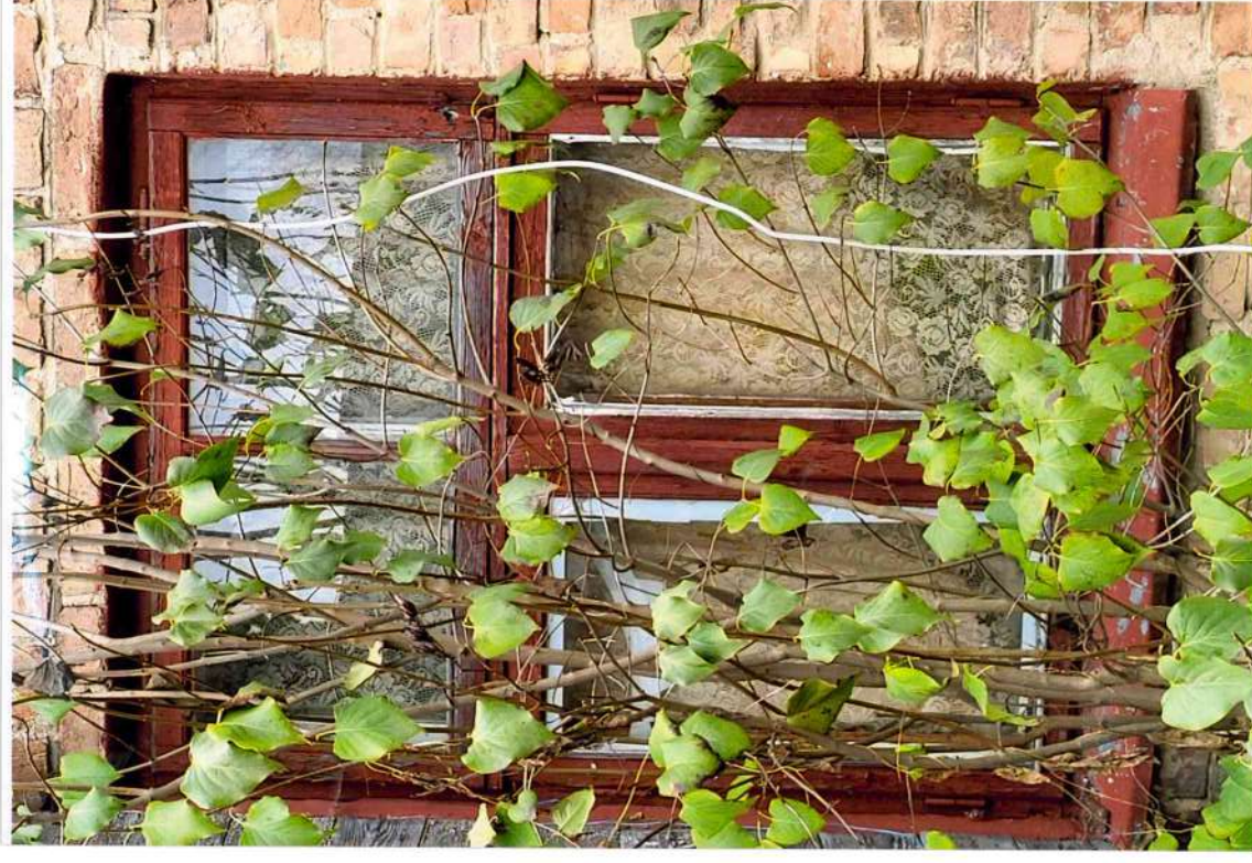
23. attēls. Iekšpagalma fasādes 1.stāva logs L-4 (3. no kreisās puses) ir koka dubultlogs (105x160 cm) ar ar horizontālo šķērsskoku un 3 vērtnēm.
