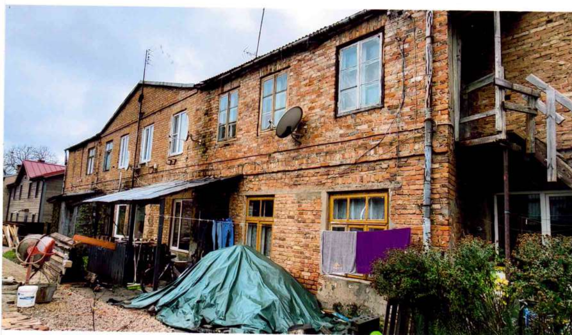
21. attēls. Ēkas iekšpagalma (Dienvidu) fasāde. Kopskats no DA puses. Ēkas Nr.28 gala sienai pēdējās pārbūvē (20.gs. 50.gadi) cieši piebūvēta ēkas Nr.30 gala siena. Apjomu savienojuma vietā izbūvēta ieeja 2.stāva dzīvoklī.
