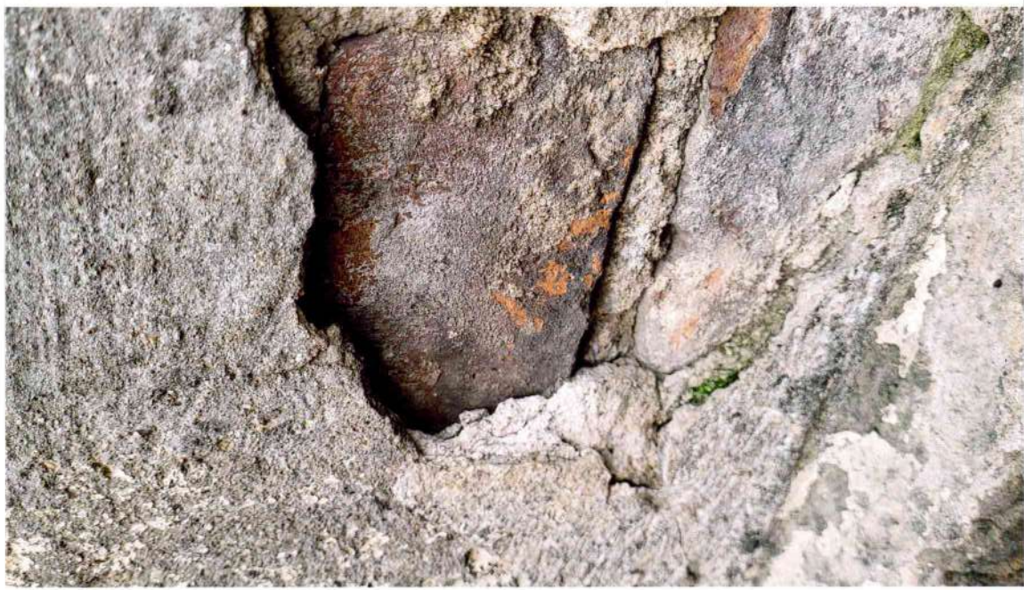
17. attēls. Ēkas ārsiena iela fasādē mūrēta no māla ķieģeļiem, apmesta ar kaļķu javu.
