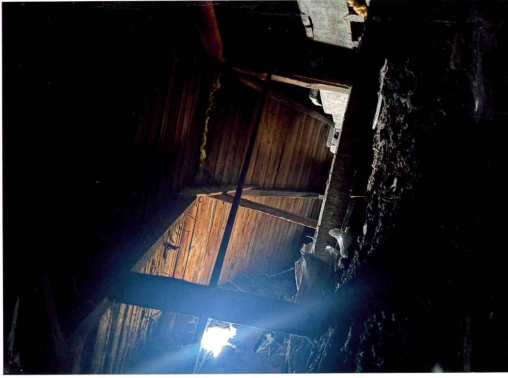
31.attēls. Mezonīna bēniņtelpa. Saglabājusies sākotnējā jumta konstrukcija. Skats uz bēniņtelpas vēdināšanas logu.
