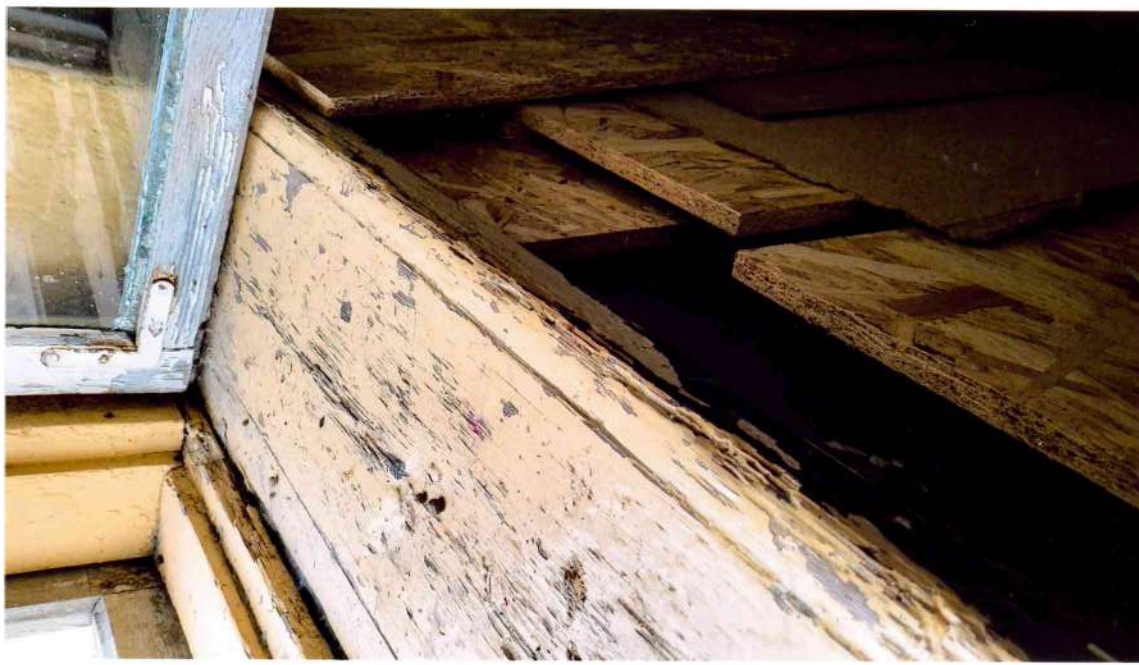
13. attēls. Logam L-2 saglabājusies sākotnējā kārba un palodze. Loga ārējās un iekšējās vērtnes nomainītas. Iekšējā vērtnē sākotnēji bijusi izcelama Ziemas vērtnē.
