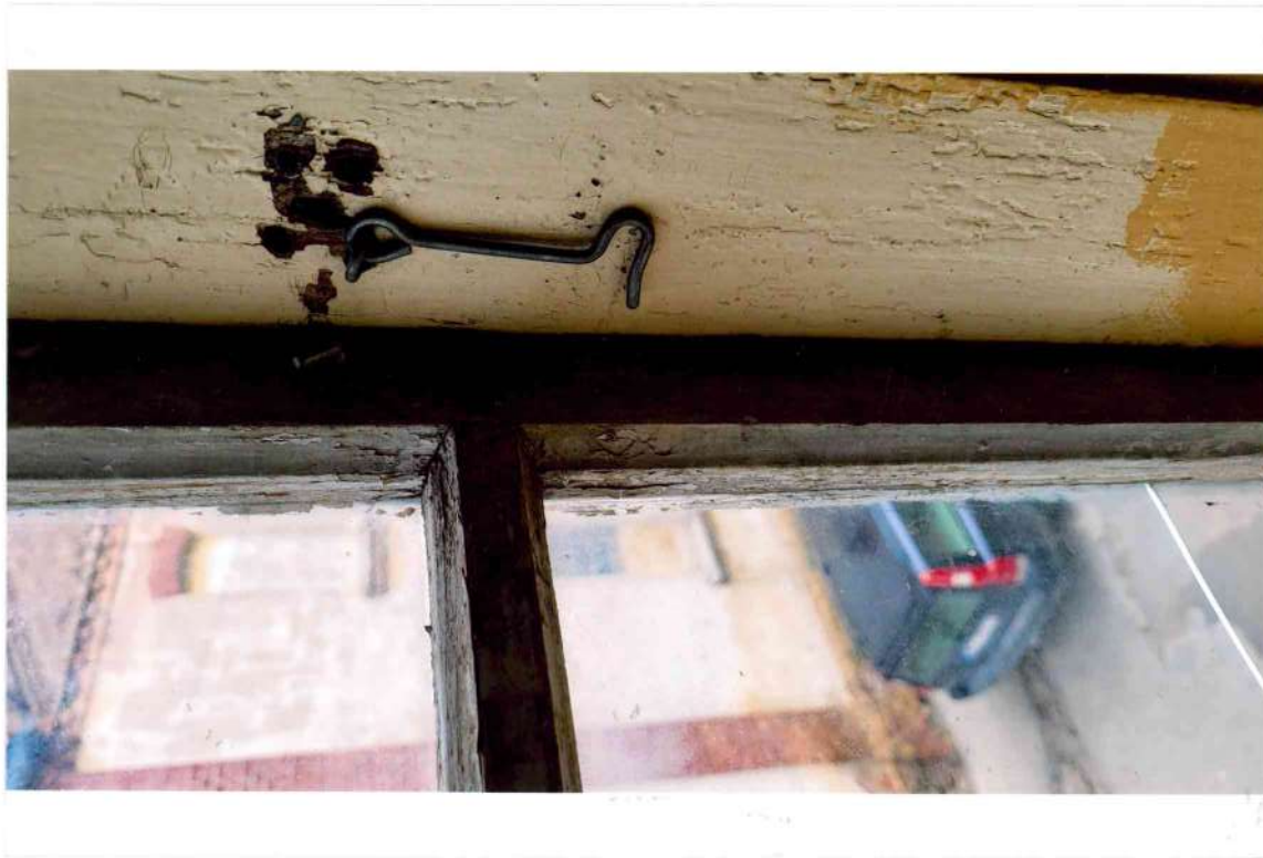
12. attēls. Mezonīna koka loga L-2 ārējās vērtnes fragments. Skats no iekšpuses. Nomainīts vērtnes fiksators (atvērtam logam).
