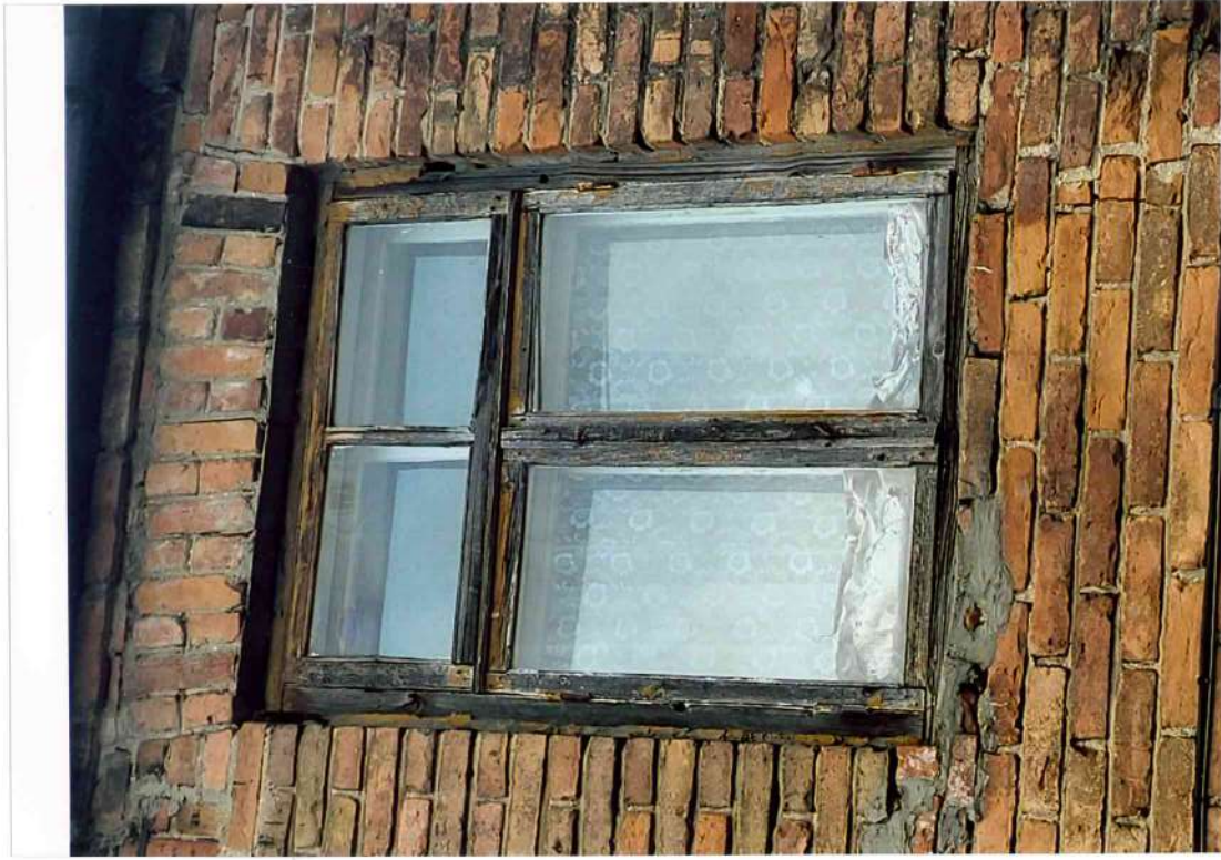
26. attēls. Koka logs L-6. Pagalma fasādē 2.stāvā 1. no kreisās puses. Koka dubultlogs (105x160 cm) ar horizontālo šķērskoku un 3 vērtnēm.
