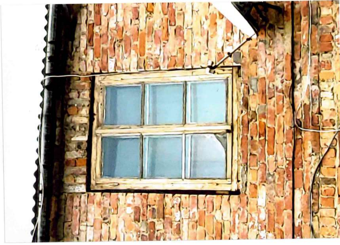
27. attēls. Koka logs L-2. Pagalma fasādē 2.stāvā (2. no labās puses). Koka logs ar divām ārējām vērtnēm (ar trīs rūtīm).
