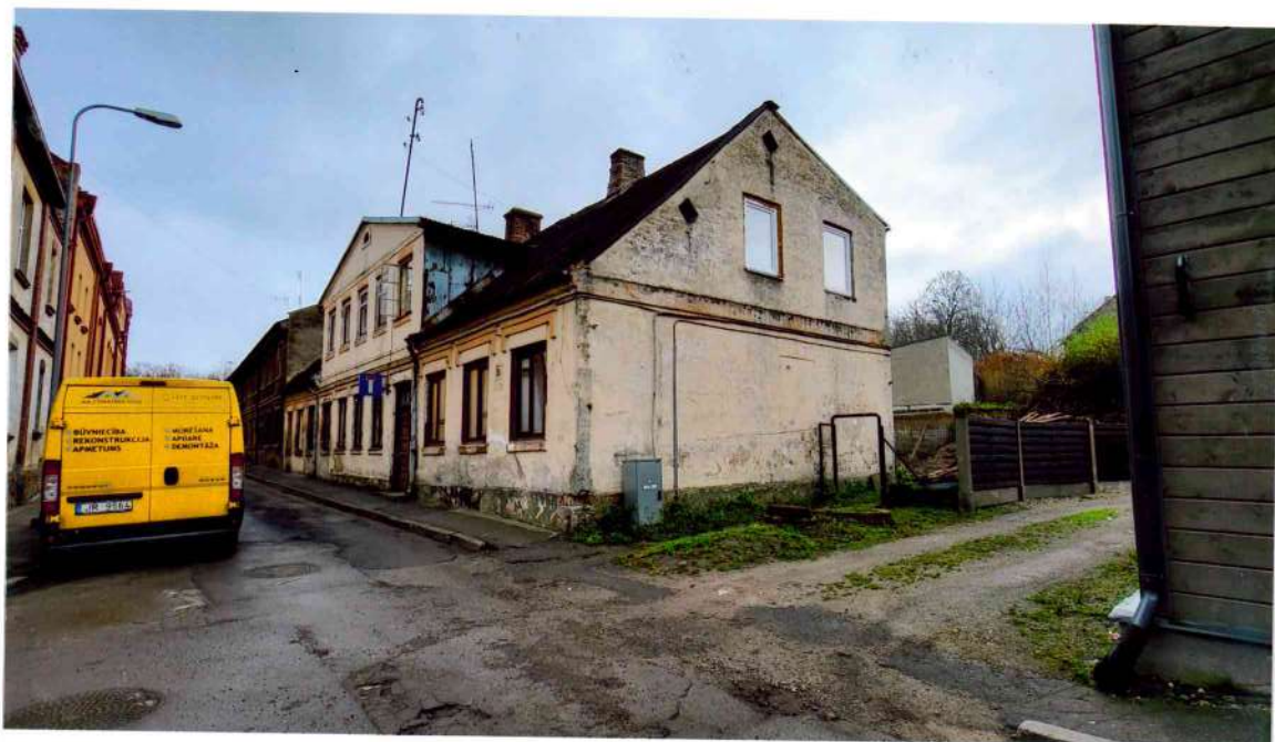
18. attēls. Kopskats uz dzīvojamo ēku no ZR puses ( no Rūpniecības un Strautnieku ielas krustojuma).
