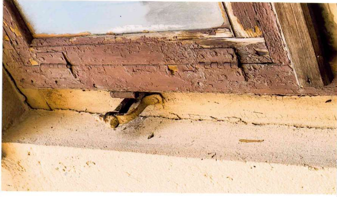
9. attēls. Kalts loga slēgu āķis, saglabājies logam L-1 Z fasādē.
