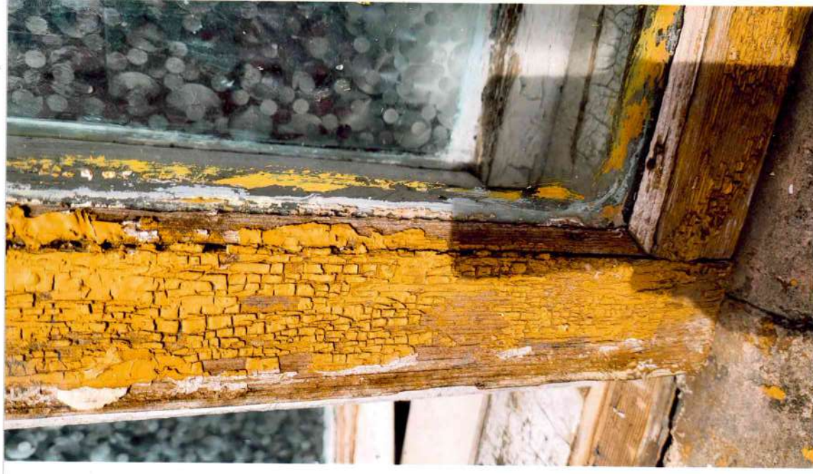
29. attēls. Koka loga L-4 ( 2. no labās puses. 1. stāvā pagalma fasādē) krāsojums.
