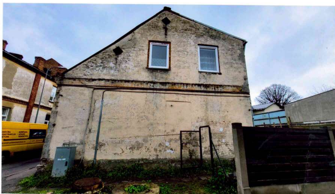
19. attēls. Ēkas gala fasāde (Rietumu). No sākotnējā ēkas apjoma saglabāties nepārbūvēta pret ielu vērstās puses apjoms, gala fasādē - bēniņu vēdināšnas rombiskie logi, starpstāvu dzega.
