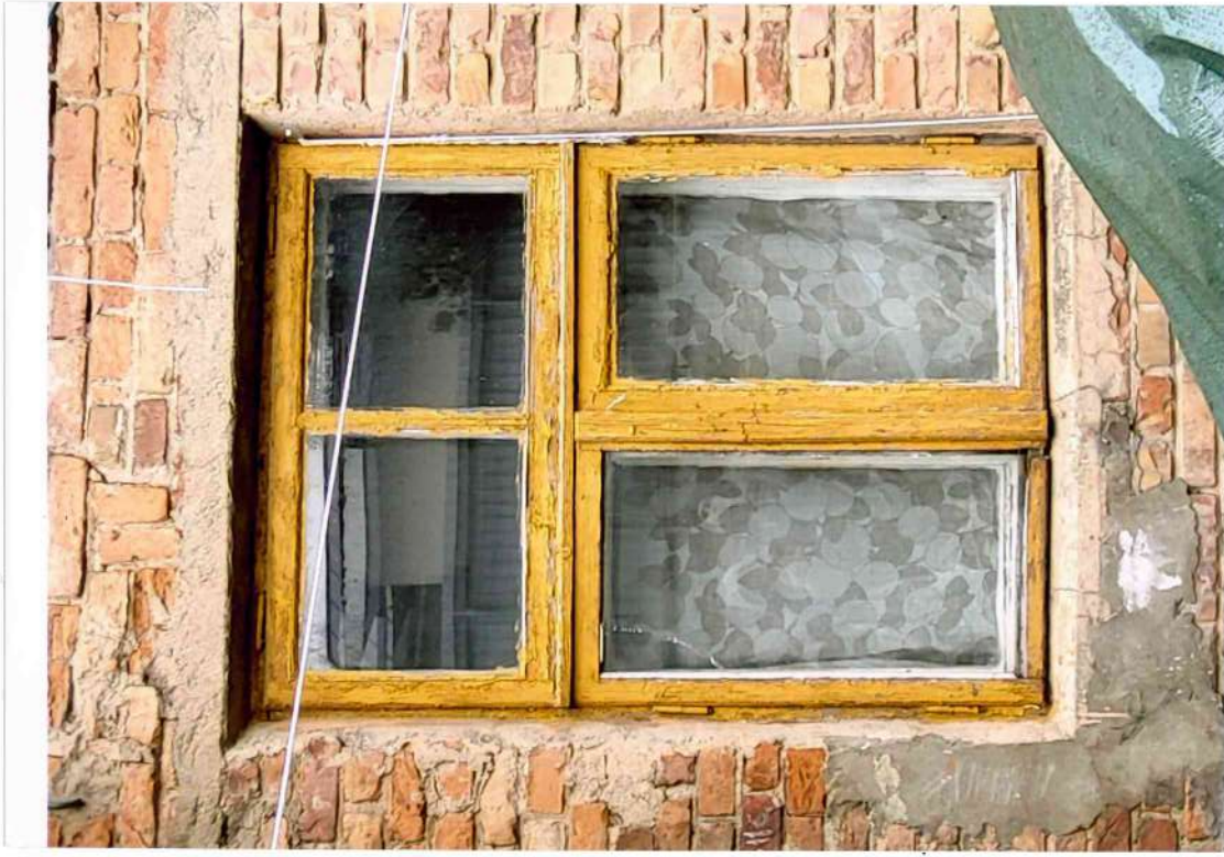
24. attēls. Iekšpagalma fasādes 1.stāva logs L-4 (2. no labās puses) ir koka dubultlogs (105x160 cm) ar ar horizontālo šķērskoku un 3 vētrnēm.
