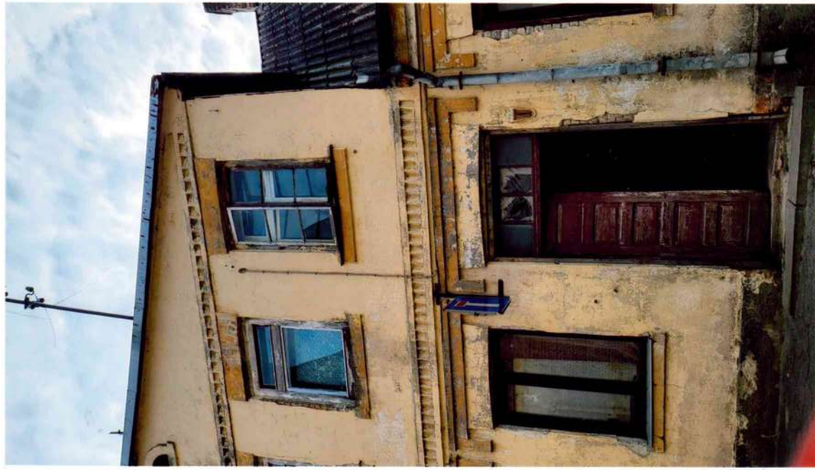
10. attēls. Ielas fasādes fragments. Saglabājušās sākotnējās koka pildīņu ārdurvis D-1 un sākotnējais mezonīna koka logs L-2.
