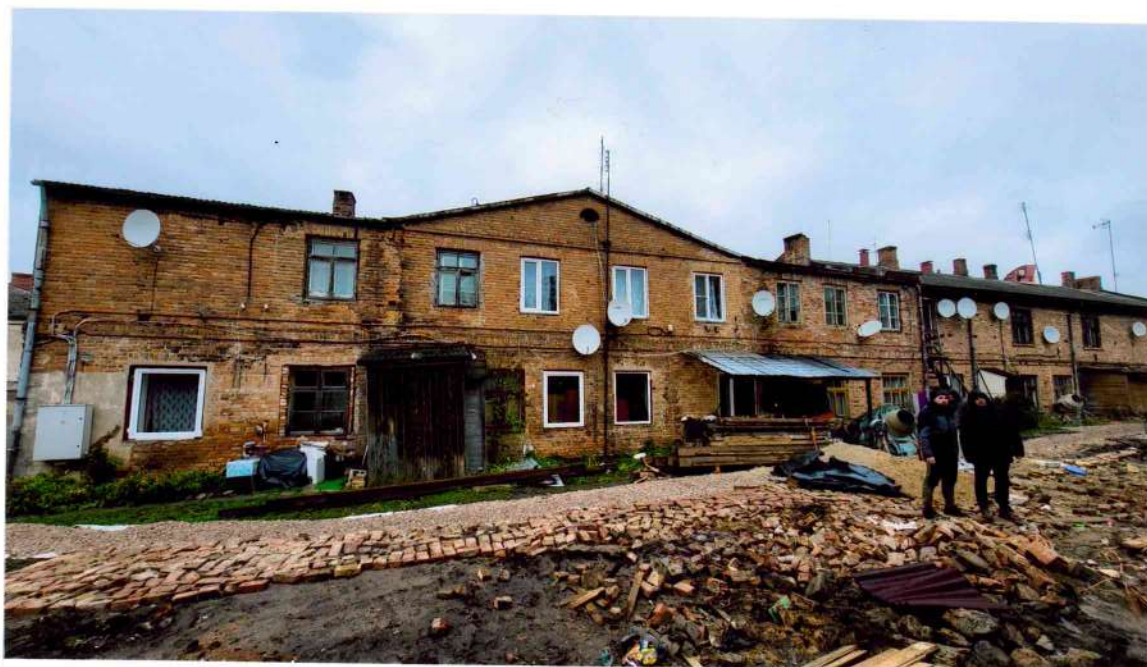
20. attēls. Ēkas iekšpagalma (Dienvidu) fasādes kopskats no D puses. Neapmesta māla ķieģeļu mūra fasāde ar pilnu 2.stāva izbūvi. Ārsiena fragmentāri pārmūrēta. Daļa no 1.stāva logu ailēm pārbūvētas (ar betona pārsedzēm), koka logi nomainīti ar PVC izstrādājumiem.
