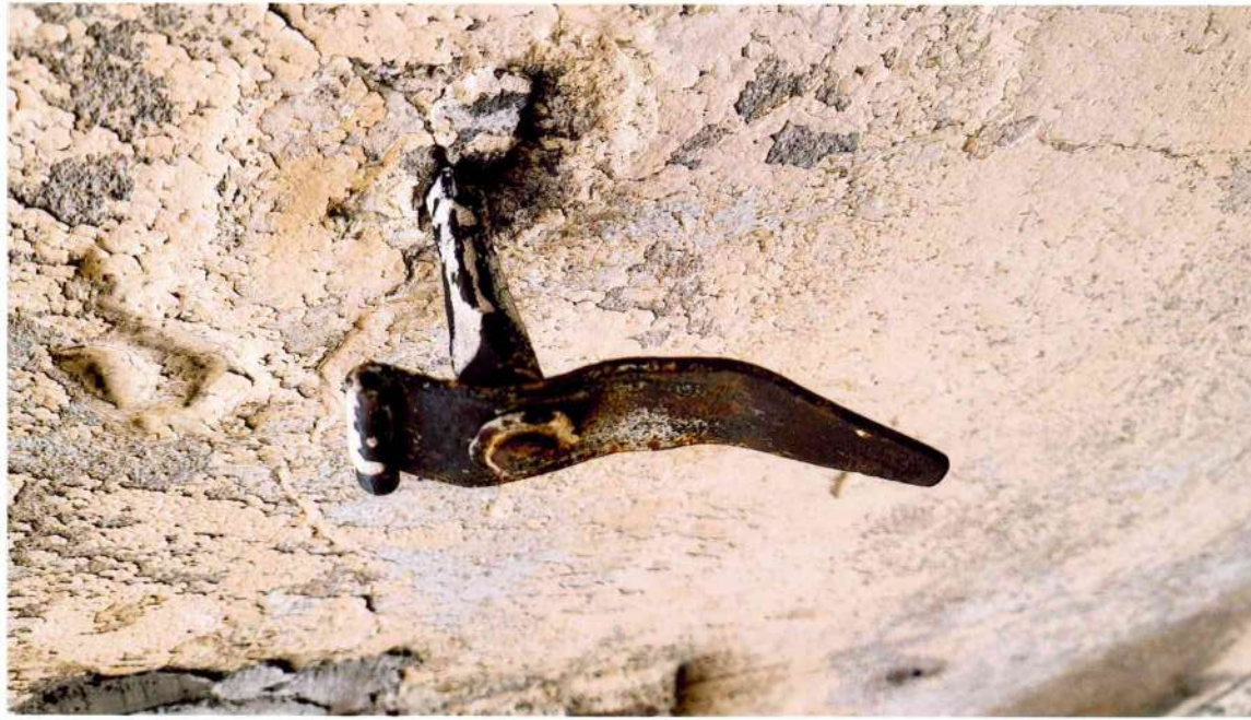
14. attēls. Kalts loga slēgu filisators (slēgu atvērtā stāvoklī). Saglabājies ielas fasādes kreisajā daļā.
