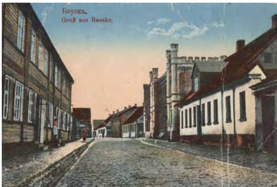
Ēka Rūpniecības 14. Sākotnējā divstāvu ēka neogotikas formās. Redzama arī bloķētā ēka. Bauskas novadpētniecības un mākslas muzeja attēls. (bauskasvecpilseta.lv)
