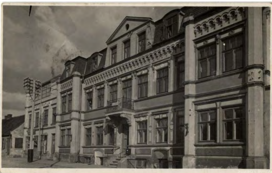
1930.g. Ēkā Rūpniecības ielā 14 - pamatskola. Bloķētajai ēkai trešajā stāvā izbūvētas telpas ar lielu stiklojumu.
