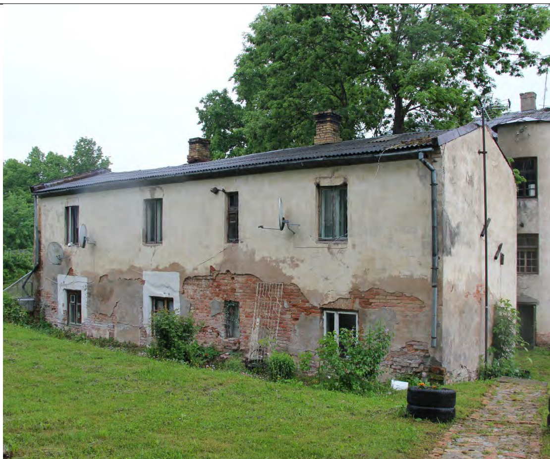
Sētas ēka. Dienvidu fasāde
