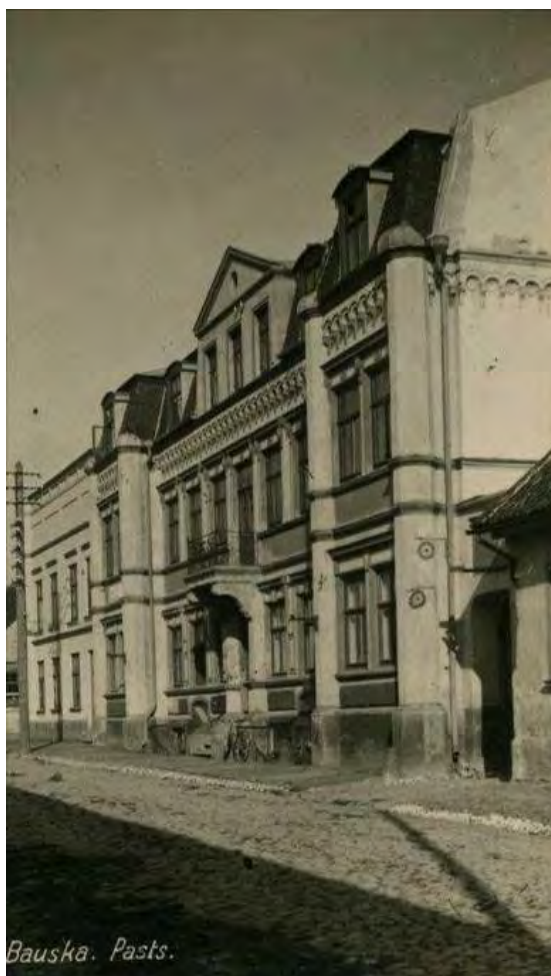
Starp 1919.-1925.g. Ēkai Rūpniecības 14 izbūvēts mansarda stāvs. Kārniņu iesegums mansarda daļā. Poligonālos neogotiskos izvirzījumus vainago skārda kupoliņi. Vārtus iebraukšanai pagalmā sedz eliptiska arka. Uz ielas granīta stabiņi. Kalti karogu turētāji un margas pie ieejām veikalos. Jumta segums - kārniņi Bauskas novadpētniecības un mākslas muzeja attēls. (Indb.lv)
