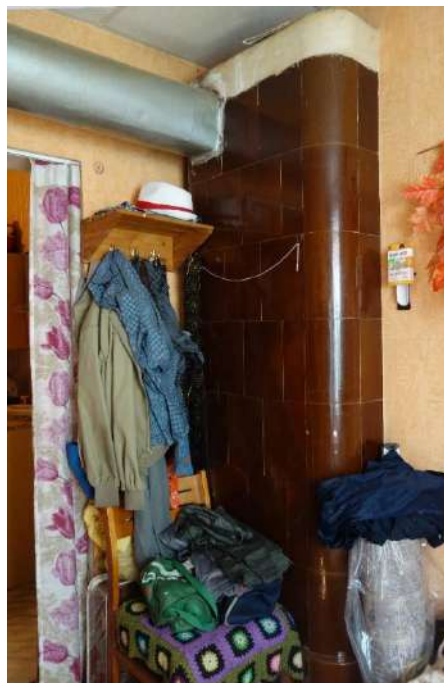
91., 92. attēls. Glazētu podiņu krāsns K1 divu telpu apsildīšanai dzīvoklī Nr. 7.
