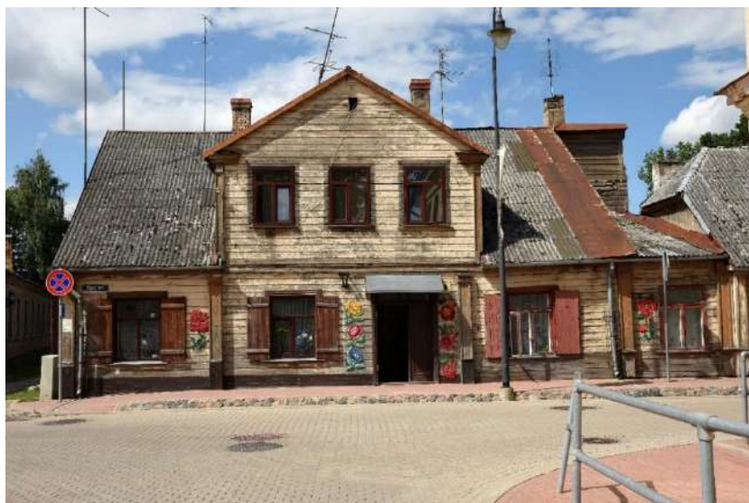
33. attēls. Ēka Rīgas ielā 9, D fasāde, kopskats uz ZR.
