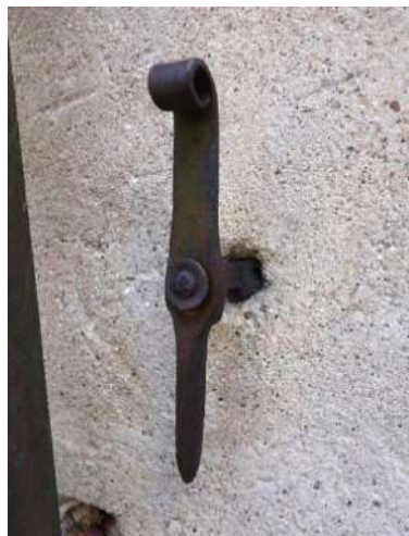
73. attēls. Tipa T3 slēgu fiksators ēkas Z fasādē, pie loga L11.
