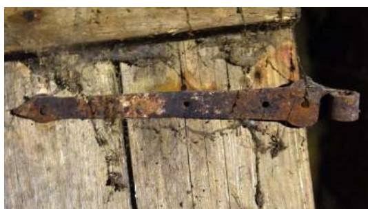
30., 31., 32. attēls. Sekundāri pagrabā izmantoto koka konstrukciju – durvju un, iespējams, slēgu vērtņu – fragmenti un to vēsturiskās furnitūras elementi.
