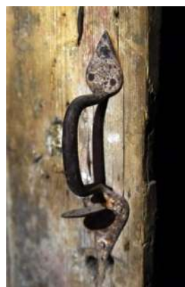
30., 31., 32. attēls. Sekundāri pagrabā izmantoto koka konstrukciju – durvju un, iespējams, slēgu vērtņu – fragmenti un to vēsturiskās furnitūras elementi.
