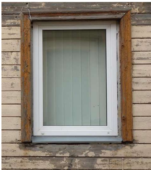
52. attēls Logaila L1-7, kurā saglabājusies sākotnējā apmale ar slēgu viru kāšiem. Vēsturiskās vērtnes un palodze zudušas.
