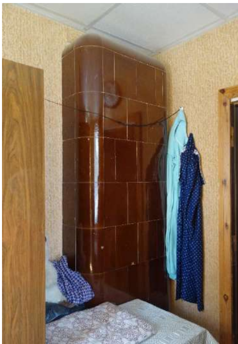
91., 92. attēls. Glazētu podiņu krāsns K1 divu telpu apsildīšanai dzīvoklī Nr. 7.
