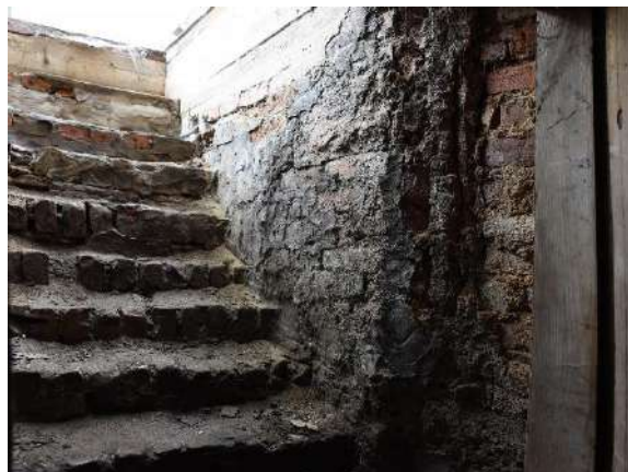
96. attēls. Neatbilstošie labojumi noejai uz pagrabu.
