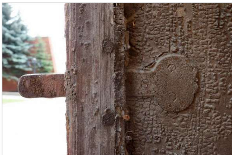
70., 71. attēls. Vēsturisko slēgu sākotnējā aizvērējmehānisma pie slēga vērtnes stiprinātā daļa.
