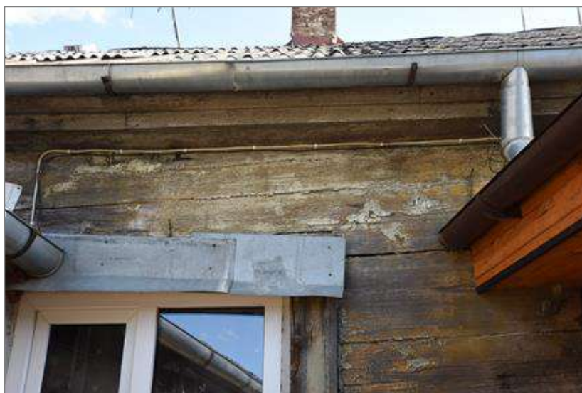
54. attēls. Ēkas Z fasādē, kur tā nav apšūta ar dēļiem, labi redzams, ka māja celta no guļšķautņiem un sākotnēji bijusi bez apšuvuma (tikai krāsota).
