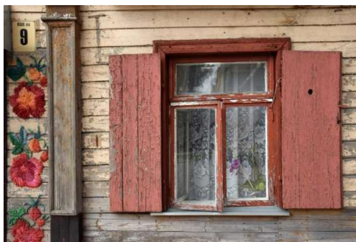
42. attēls. Logaila L1-2 ar sākotnējo loga apmali un slēgiem.
