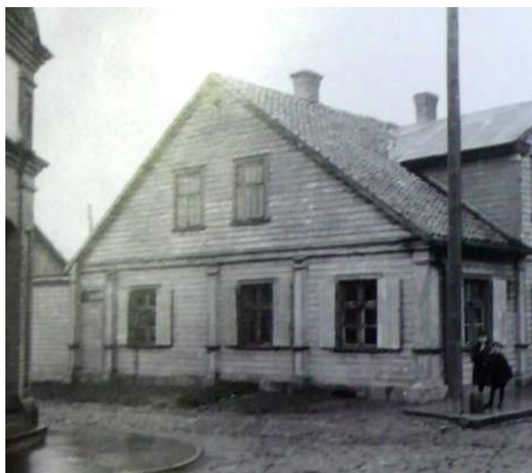
50. attēls. Ēkas R fasāde 1939. gadā. Redzamas durvis fasādes Z galā.
