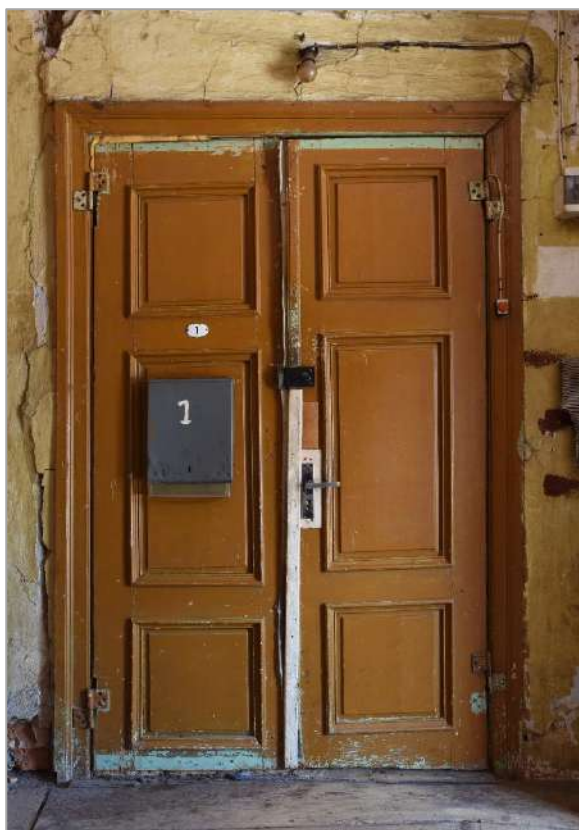
82. attēls. Durvis D1. Ierīkojot tām otras vērtnes, sākotnējās vērtnes pārceltas kārbas ārpusē, aprīkotas ar jaunām virām un mainīts to vēršanās virziens.
