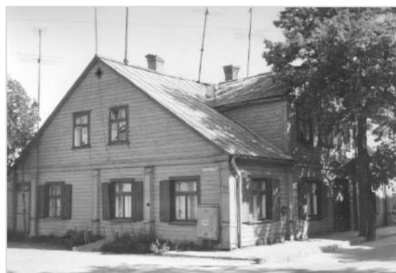
23. attēls. Skats uz ēkas D fasādi ap 1980. gadu
