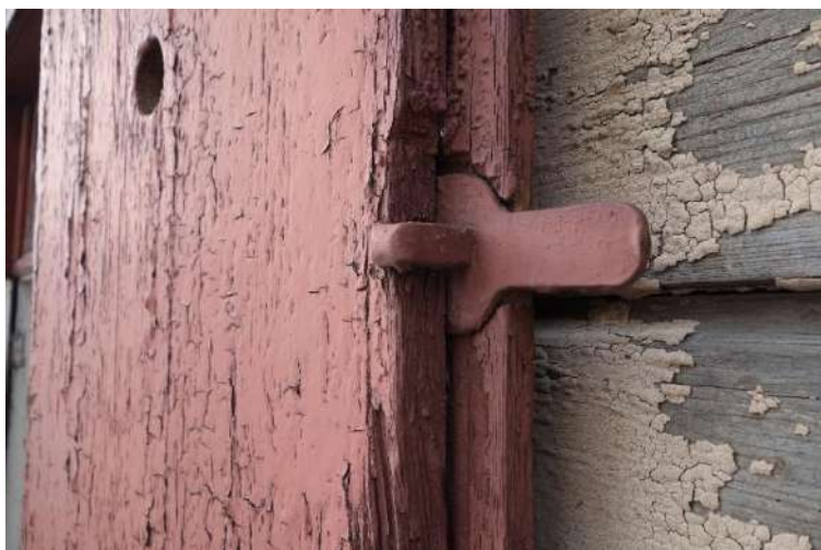
69. attēls. Slēgu viru kasis pie logailas L1-9 .
