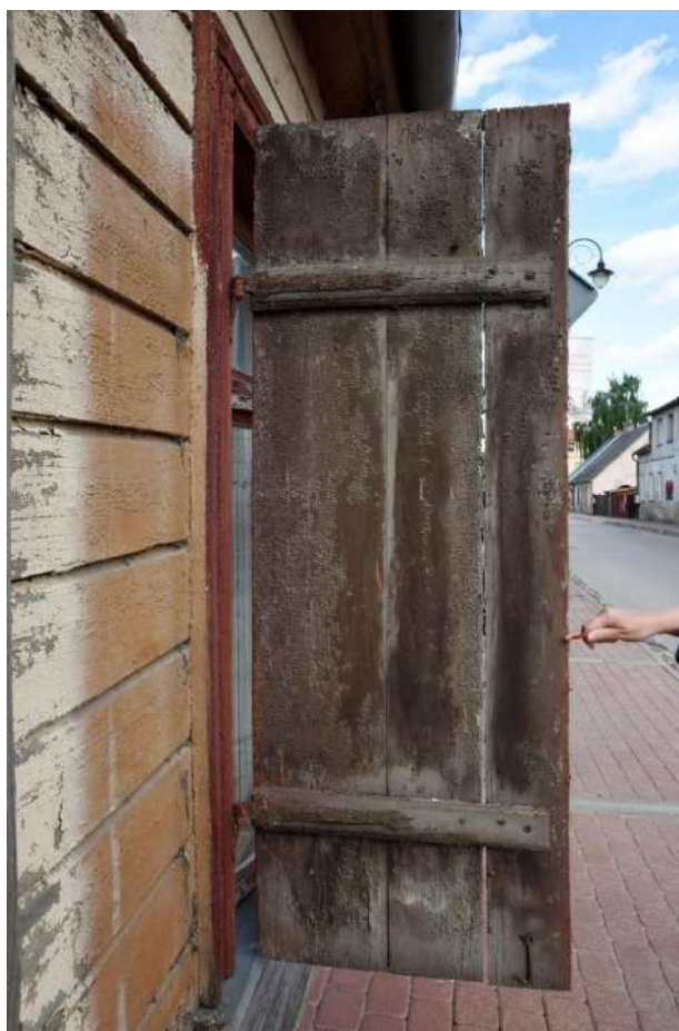
66., 67., 68. attēls. Sākotnējos slēgu detaļas – vētrnes horizontālais stiprinājums (šķērsdzītis), slēga lentes vira ar viras kāsi un krampītis slēga fiksēšanai atvērtā stāvoklī.
