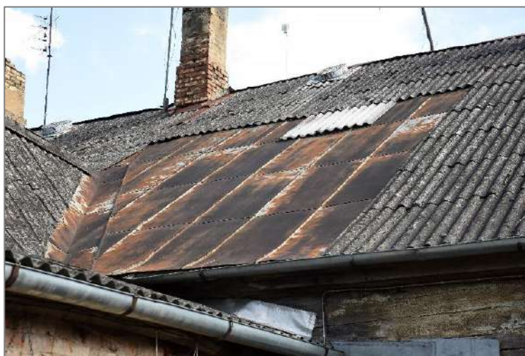
57. attēls. Pagalma pusē daļēji saglabājies 20. gs. sākumā liktais skārda lokšņu jumta segums.
