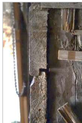
35. attēls. Fasādes apdares dēļu profilējums labi nolasāms pagalma kāpņu piebūvē augšstāva līmenī, kur pamatkorpusa sienā izzāgētas durvis.
