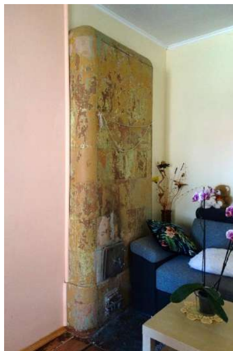
94. attēls. Neglazētu podiņu krāsns K3 dzīvoklī Nr. 2.
