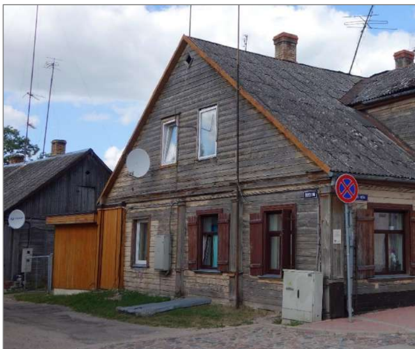
48. attēls. Skats uz ēkas R fasādi.
