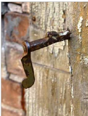
72. attēls. Tipa T2 slēgu fiksators ēkas Z fasādē, pie loga L12.
