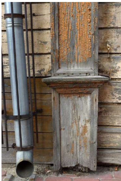
39. attēls. D fasādes dekoratīva pilastra sākotnējā bāze ar profilīstī pa perimetru.
