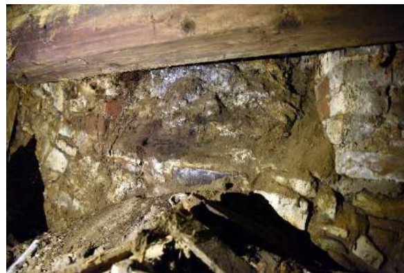
27. attēls. Ēkas R sienā pagrabā saglabājusies aizmūrēta arkas formas logaila
