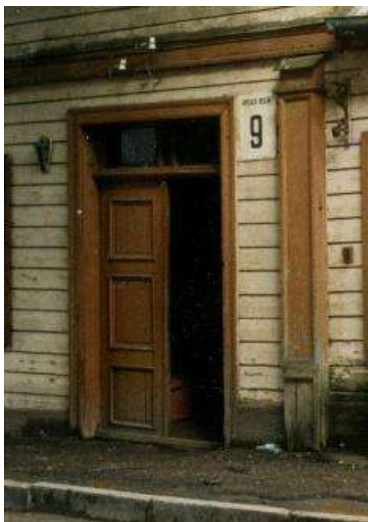
74. attēls. Sākotnējās pildīņu ārdurvis ar virsgaismu ēkas D fasādē (AD1). 2003. gada foto. NKMP PDC dokumentu fonds
