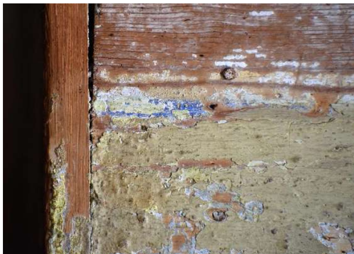
61. attēls. Atsevišķu vēsturisku krāsu slāņu fragmenti uz ēkas priekšnama A sienas.
