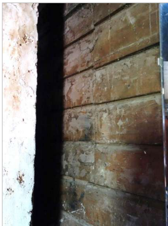
34. attēls. Fasādes apdares dēļu profilējums labi apskatās ēkas A puses piebūvē, kur kādreizējā ārsiena tagad kļuvusi par telpas starpsienu.
