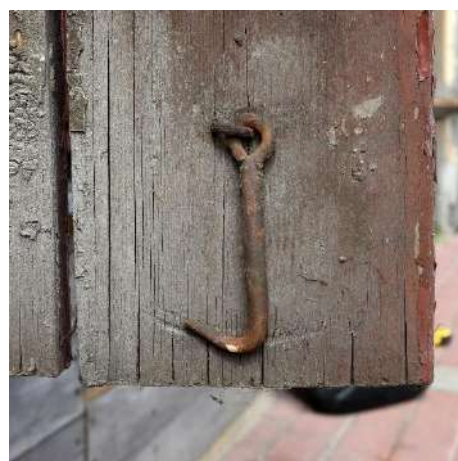
66., 67., 68. attēls. Sākotnējos slēgu detaļas – vētrnes horizontālais stiprinājums (šķērsdzītis), slēga lentes vira ar viras kāsi un krampītis slēga fiksēšanai atvērtā stāvoklī.
