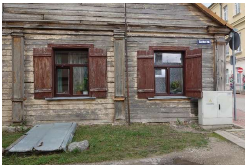
49. attēls. R fasādes fragments. Redzama ar skārdu klātā pagraba ieejas lūka, kā arī pa fasādes virspusi stiprinātie elektrības vadi
