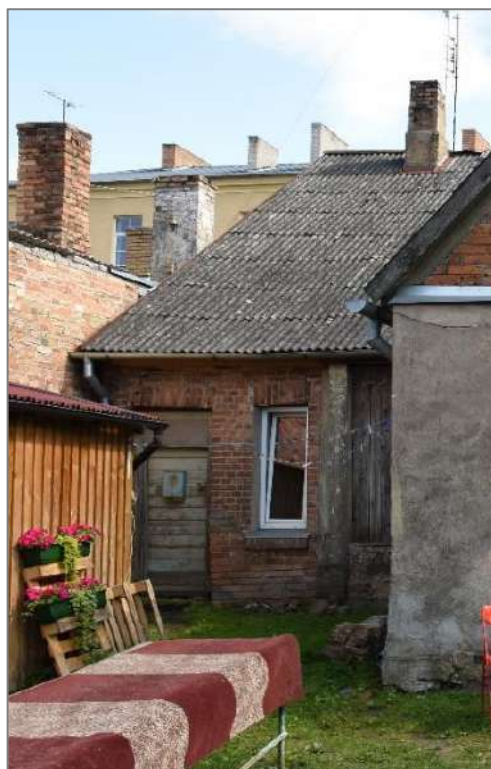
56. attēls. Ķieģeļu piebūve ēkas A galā. 2019. gada foto
