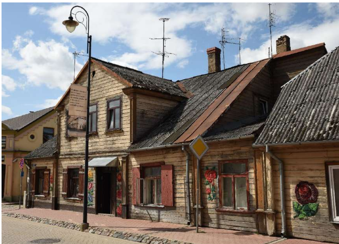
19. attēls. Ēka Rīgas ielā 9 D fasāde, kopskats uz ZR.
