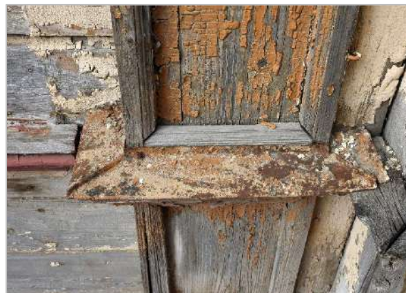
98. attēls. Skārda jumtiņš virs pilastru profillīstēm.
