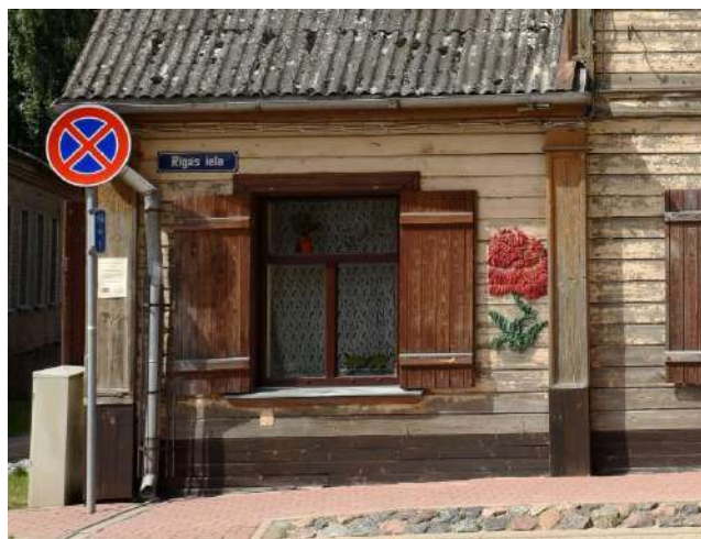
38. attēls. Daļā no ēkas D fasādes dekoratīvās pilastra bāzes aizstātas ar nesen uzstādītām kastes formas konstrukcijām.
