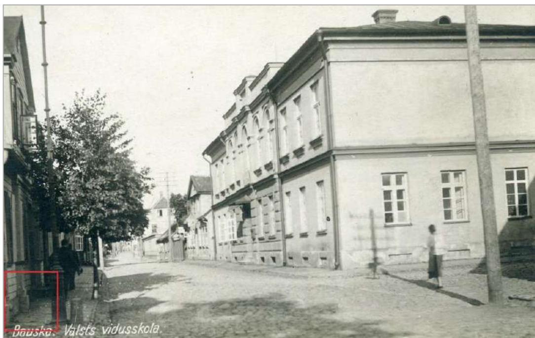
20. attēls. 20. gs. 20. gadu fotogrāfijā redzams, ka ielas līmenis bijis zemāks. Ēkas fasādes daļā redzami virspamati un pakāpieni pie ieejas durvīm. Foto BM, inv. Nr. BPM 30098
