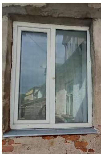
203. attēls. L1/ 10. Daļēji verams vienas vērtnes divdaļīgs, balts PVC logs
