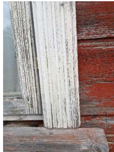
199. attēls. Profilēta sākotnējā loga apmale
