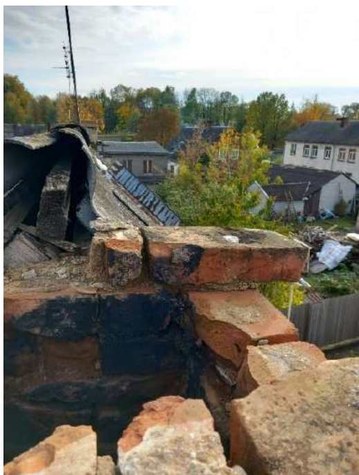
48. attēls. Sākotnējā skursteņa "galva" nobrukusi līdz jumta līmenim
