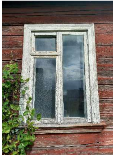
196. attēls. Logs L 1/ 5. Trīsdalīgs, daļēji verams koka logs ar vēdlodziņu.
