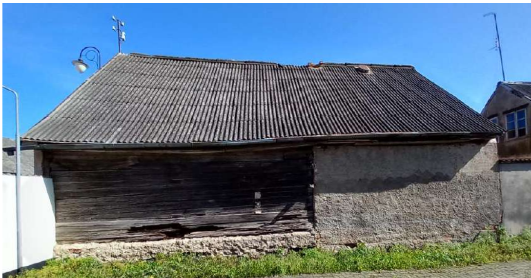
31. attēls. Skats uz ēku no rietumiem. Redzama 18.gs.beigu plānā attēlotās ēkas guļbaļķu siena.
