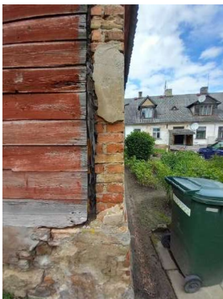
171. attēls. Ēkas DA stūris ar stūra apšuvuma dēļa stiprinājuma pēdām.
