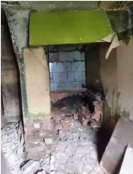
163. attēls. Plīts vieta un skurstenis pirmā stāva dzīvoklī
