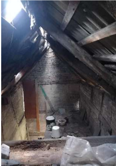
34. attēls. Skats no ēkas pamatapjoma bēniņiem uz piebūves bēniņu daļu
