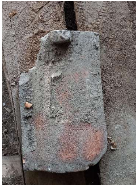
42. attēls. Ēkas bēniņos atrastā dakstiņa fragments ar zīmi K
