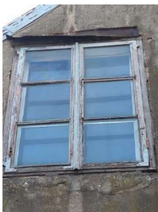
152. attēls. Ziemeļu fasādes otrā stāva austrumu puses logs, plānā L2/1
