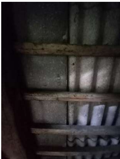
182. attēls. Skārda un šīfera jumta seguma savienojuma vieta
