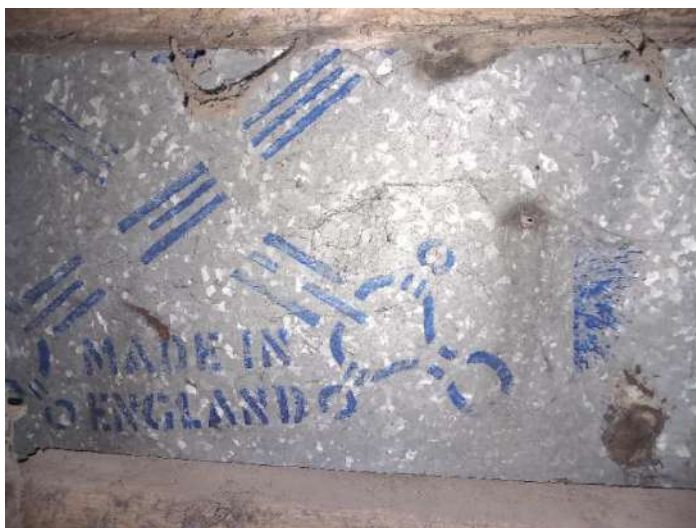
183. attēls. Jumta skārda loksne ar ražotāja zīmi.
