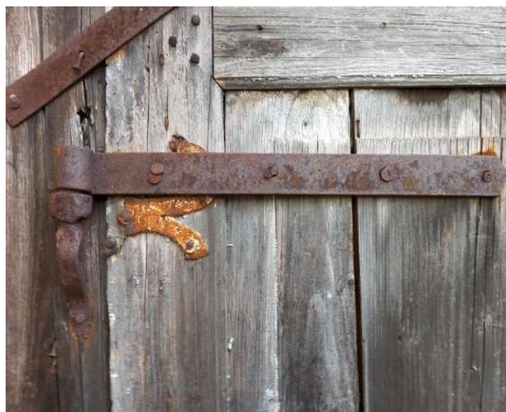
76. attēls. Sirpja eņģes fragments un eņģe D1/3 durvīs
