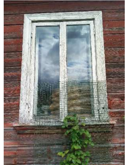
197. attēls. Logs L 1/ 6. Divdalīgs, daļēji verams koka logs.
