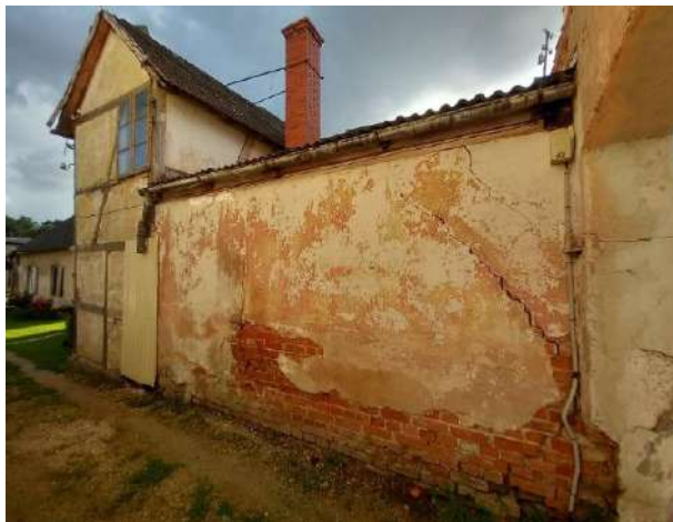
23. attēls. Ēkas piebūves, skats uz dienvidrietumiem
