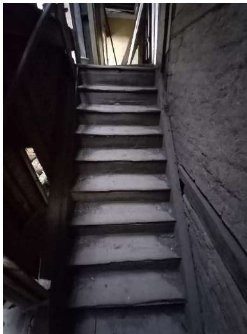
87. attēls. Kāpnes uz bēniņu stāvu pildrežģa piebūvē, skats uz rietumiem
