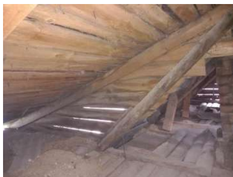
186. attēls. Jumta izbūve, skats uz ziemeļiem
