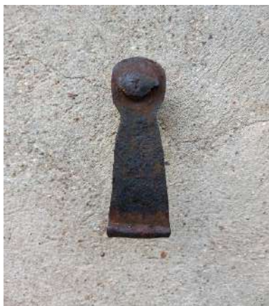
128. attēls. Loga L1/1 slēga kreisās puses fiksators
