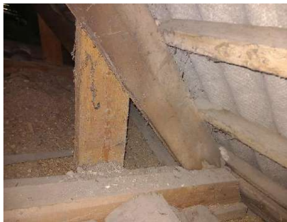
178. attēls. Sijas stiprinājums ar vertikālu koka balstu.
