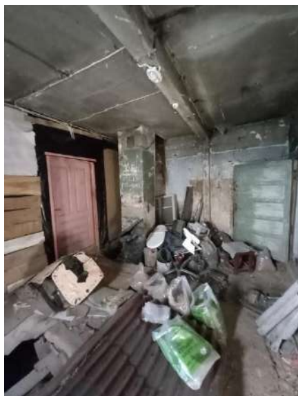
84. attēls. Telpa nr. T 4, skats uz ziemeļrietumiem
