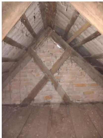
33. attēls. Pamatapjoma jumta konstrukcijas kopskats uz dienvidiem
