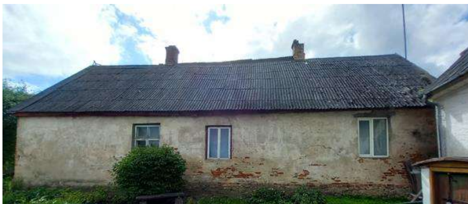
176. attēls. Ēkas austrumu fasāde.
