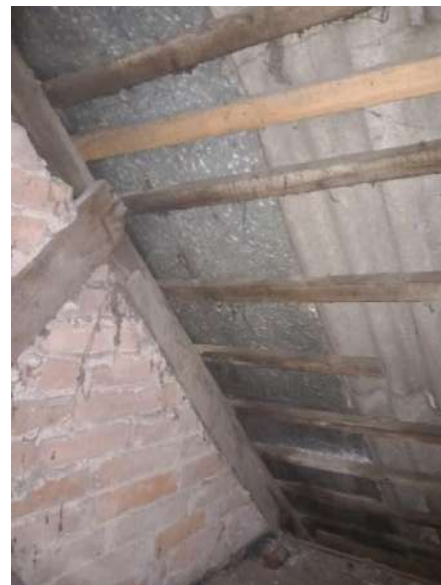
37. attēls. Virs sijām uznaģlotais latojums, kas balsta viļņotā šīfera loksnes.
