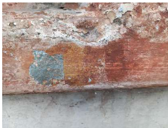
28. attēls. Krāsu kārtas uz ziemeļu fasādes starpdzegas
