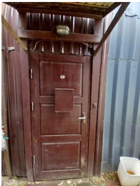
209. attēls. D1/1. 20 gs. otrās puses koka durvis ziemeļu fasādē
