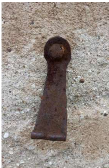
141. attēls. Loga L1/2 slēga kreisās puses fiksators
