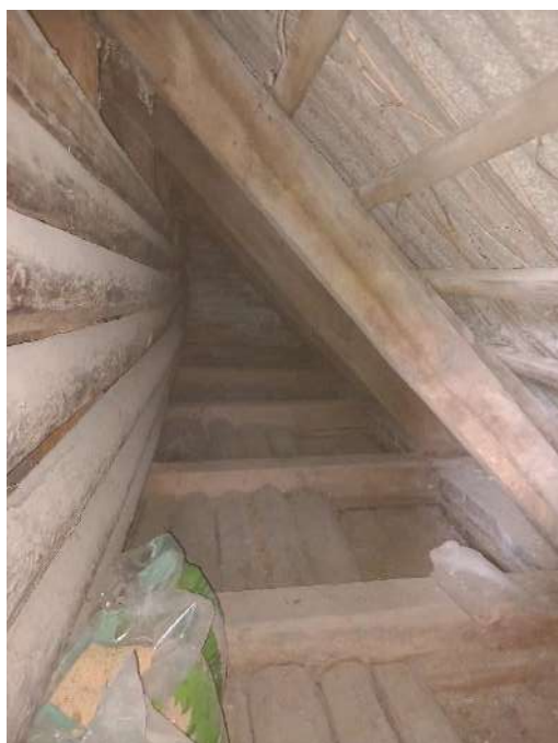
115. attēls. Ēkas austrumu puses bēniņi, skats uz ziemeļiem
