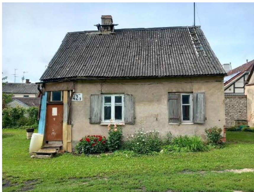
108. attēls. Ēkas kopskats, skats uz austrumu fasādi, plānā nr. 3.
