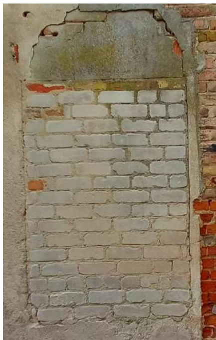
147. attēls. Aizmūrēta loga aila ziemeļu fasādē
