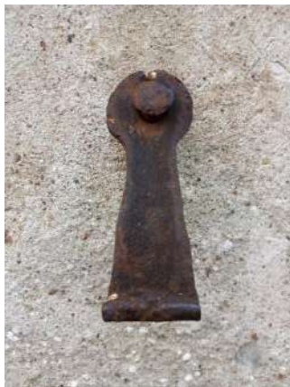
129. attēls. Loga L1/1 slēga labās puses fiksators
