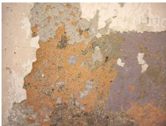
27. attēls. Krāsu kārtas ziemeļu fasādes plaknē
