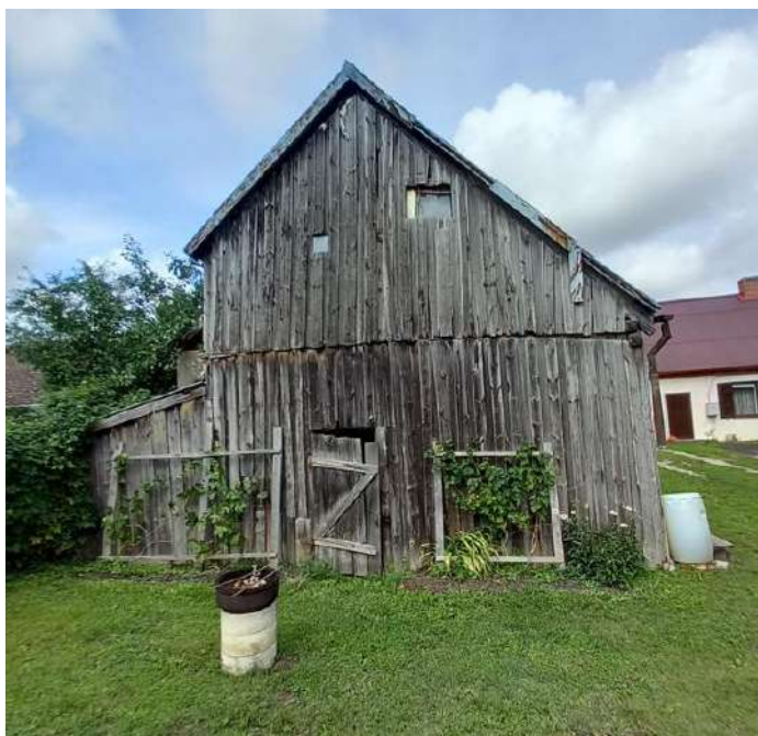
109. attēls. Koka piebūve ēkas dienvidu sienā.
