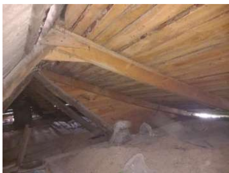
185. attēls. Jumta izbūve, skats uz dienvidiem
