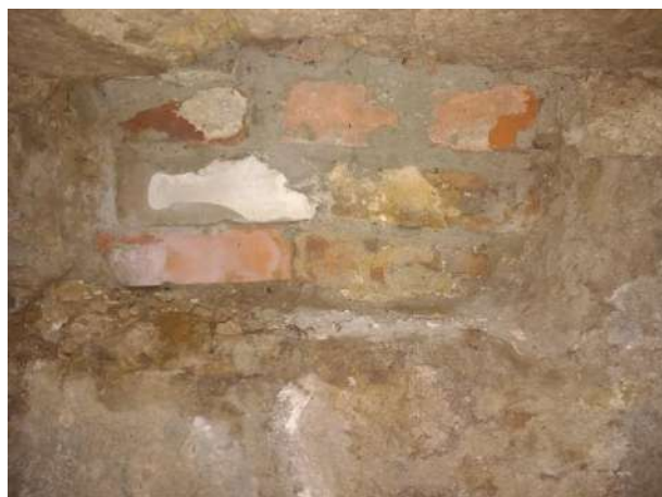
228. attēls. Aizmūrētais pagraba logs, skats uz austrumiem.
