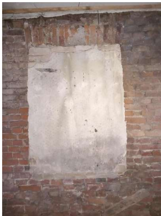
148. attēls. Aizmūrēta loga aila, skats no ēkas iekšpus
