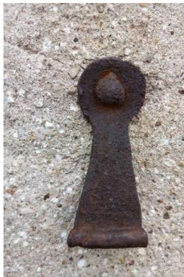
142. attēls. Loga L1/2 slēga labās puses fiksators
