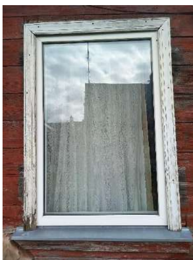
193. attēls. Logs L 1/2 neverams viendaļīga balts PVC logs
