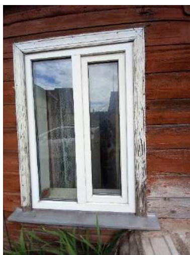
192. attēls. Logs L 1/1 daļēji verams vienas vētnes divdaļīgs balts PVC logs.
