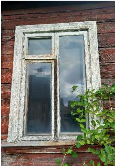
195. attēls. Logs L 1/ 4. Trīsdalīgs, daļēji verams koka logs ar vēdlodziņu.
