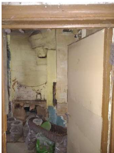
215. attēls. Krāsns un sagraudā plīts dzīvoklī nr. 3
