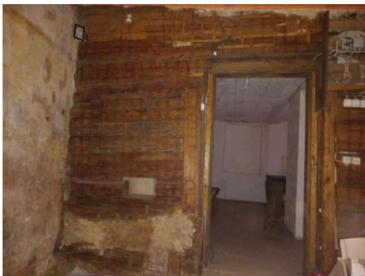
82. attēls. Telpa nr.T3 , skats uz ziemeļiem
