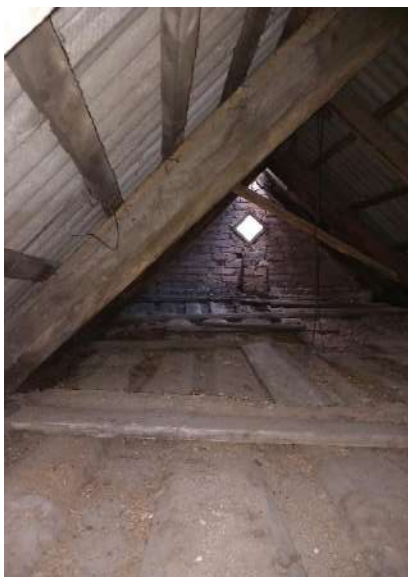
32. attēls. Pamatapjoma jumta konstrukcijas kopskats uz ziemeļiem
