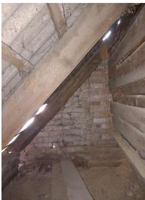
114. attēls. Ēkas rietumu puses bēniņi, skats uz ziemeļiem
