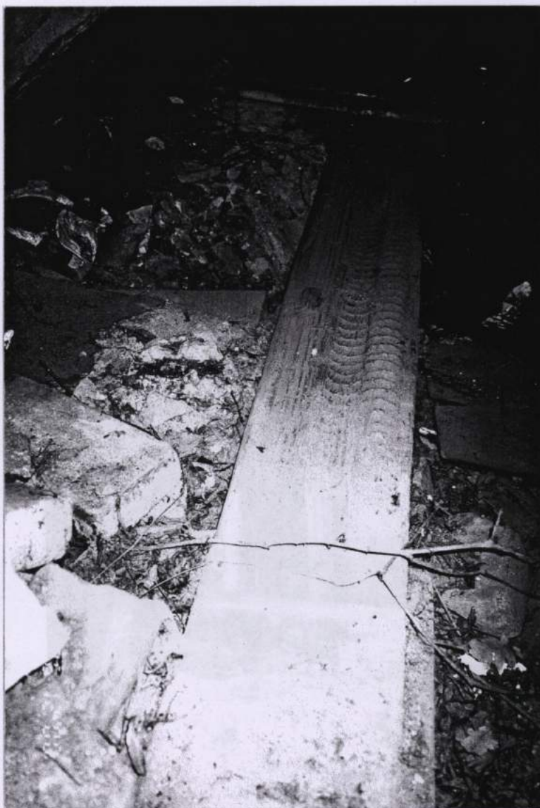
F-18 Pārseguma sija ar kokgriezumiem izmantota satrupējušo siju galu stiprināšanai kalpo kā iekarsija.
