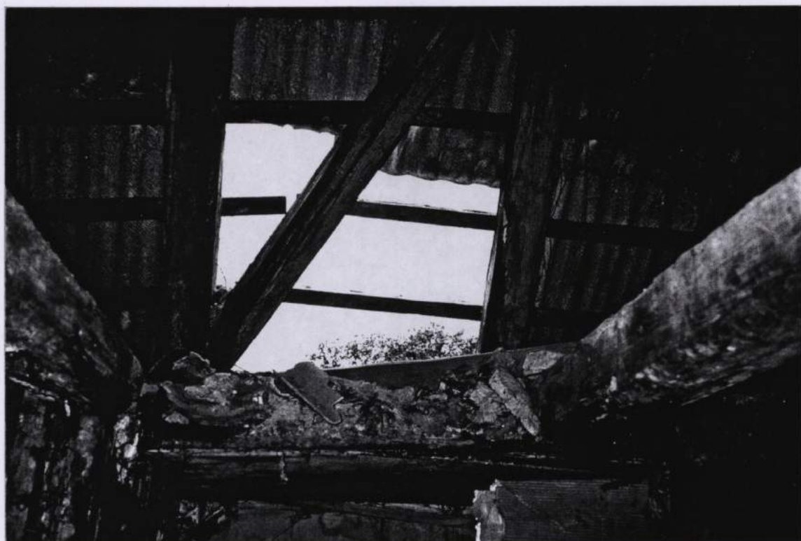
F-16 Satrupējis, iebrucis otrā stāva pārsegums.
