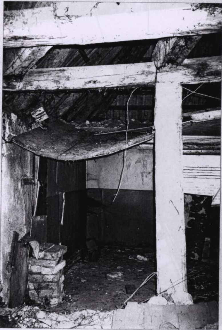
F-25 Iebrucis 2.stāva pārsegums.
