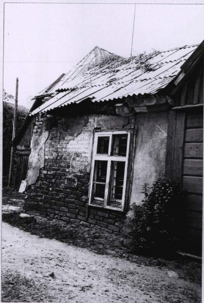
F-4 Sētas fasādes fragments ķieģeļu mūra piebūve.
