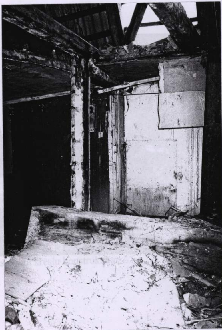
F-19 Iebrucis 2.stāva pārsegums.
