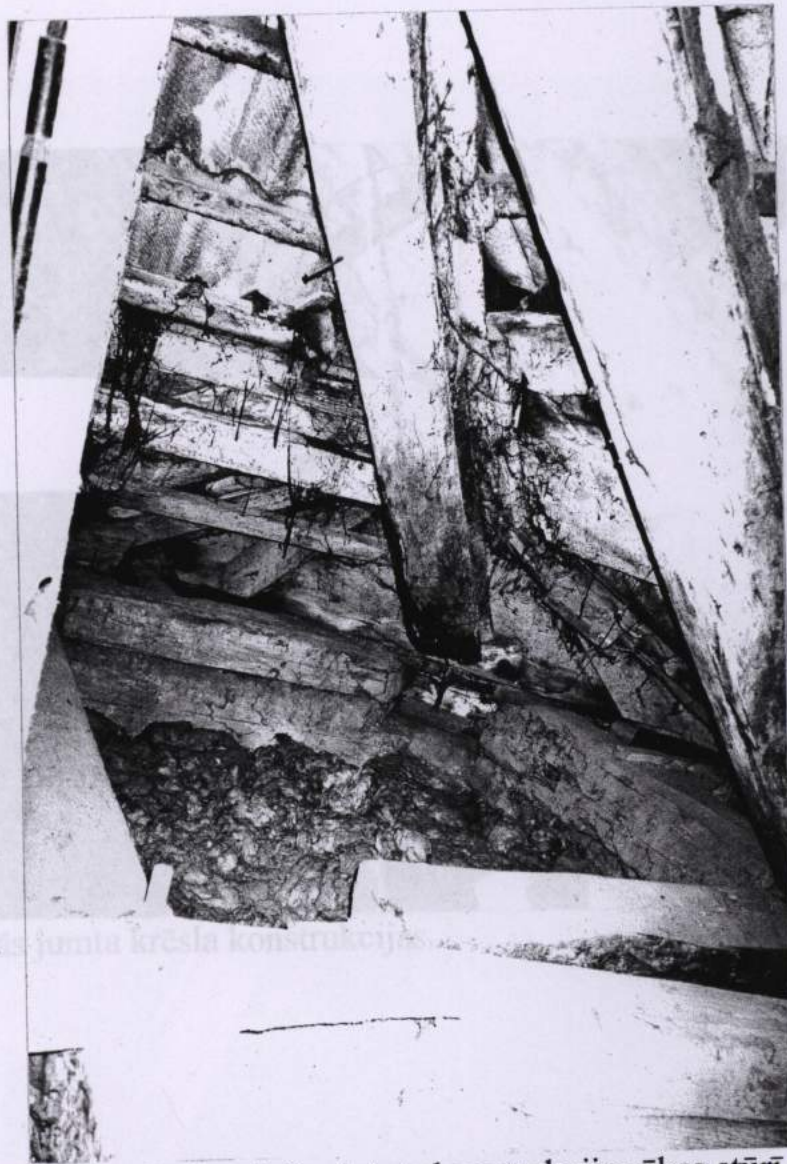
F-22 Satrupējušas jumta konstrukcijas ēkas stūrī.
