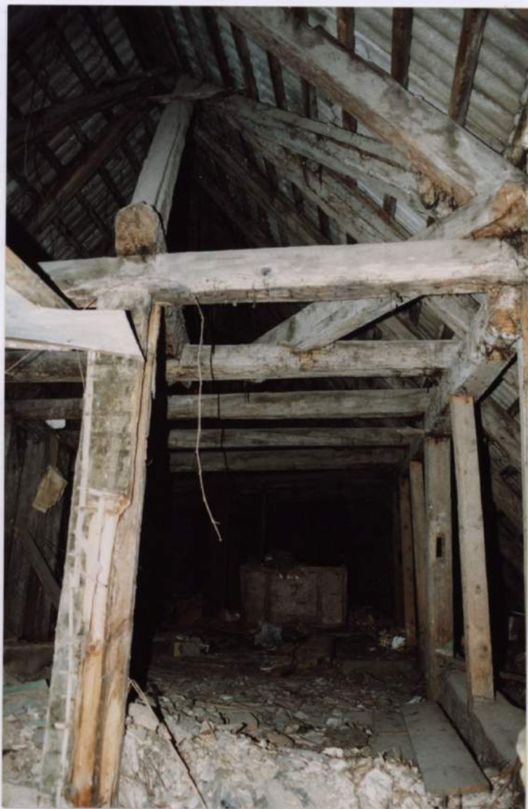
T205. Ēkas II etapa piebūves zeltiņa daļa ar pusšļaupto jumtgali. Tā iekļauta jumta konstrukcijā, ēku pagarinot 19.gs. 3.ceturksnī.
