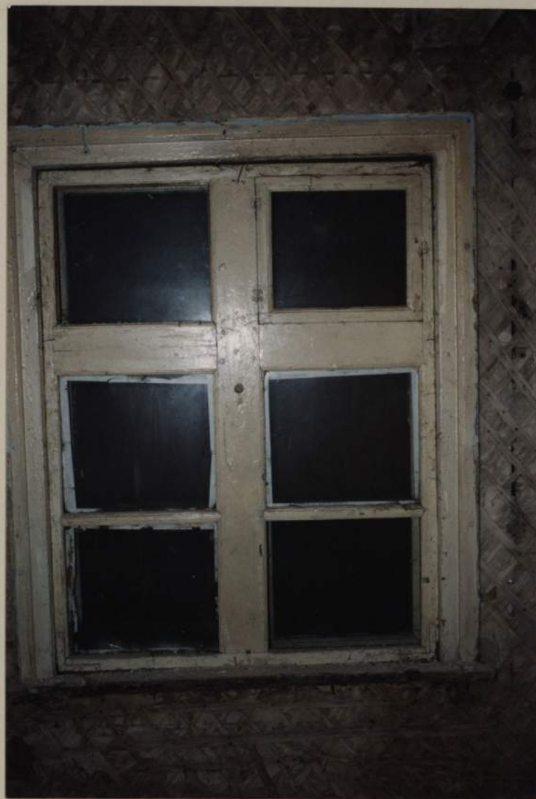
F-26 L115 ar ziemas vērtņi. Centrā caurums slēga fiksācijas skrūvei. 19.gs. vidus.
