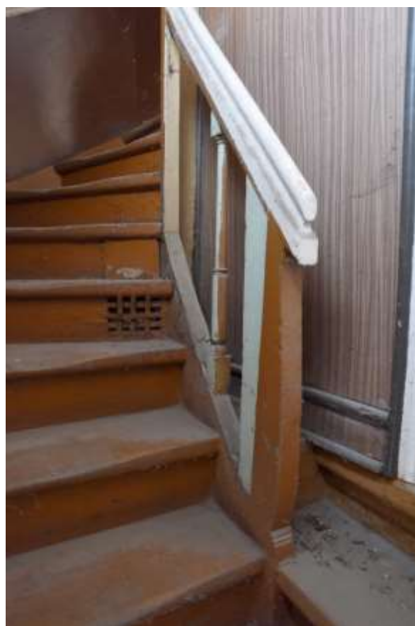
150. attēls. Kāpņu margu apakšējais balsts un viens saglabājies balustrs, skats uz DA.
