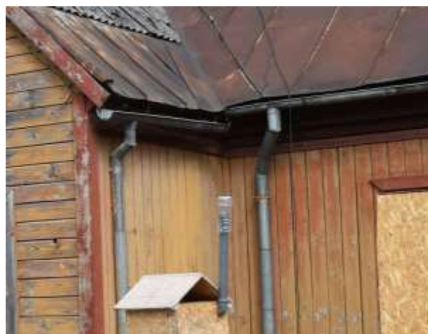
64. attēls. Ēkas pamatkorpusa un šķērskorpusa sadures vieta D fasādē ar lietus ūdens teknēm un notekcaurulēm, skats uz ZR.
