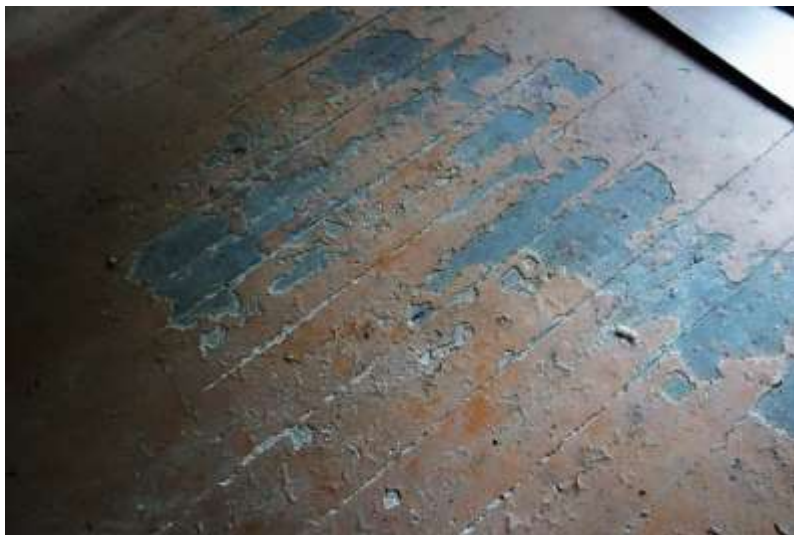
157. attēls. Padomju laikā ieklāta krāsotu dēļu grīda telpā T-I/10.
