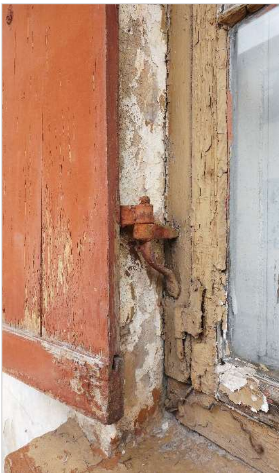
184. attēls. 19. gs. slēģu viras Bauskā, Plūdoņa ielā 52.
