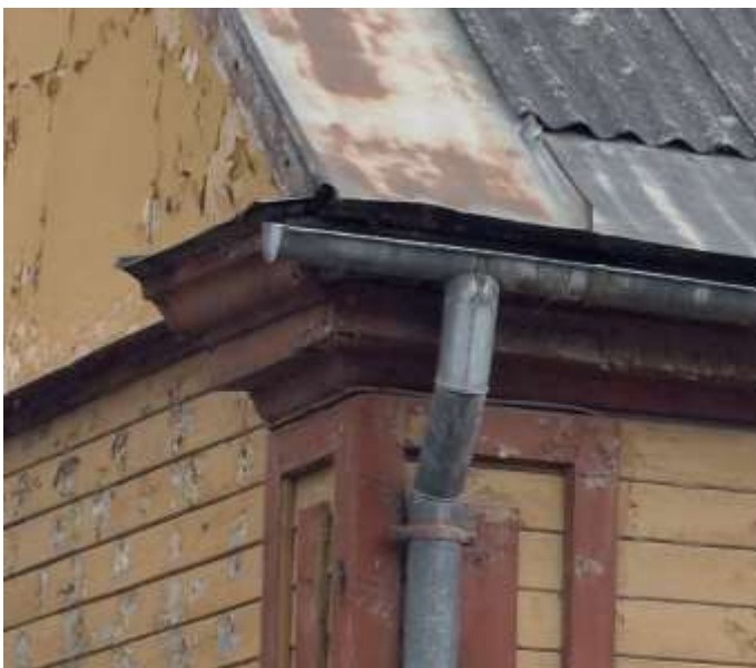
29. attēls. Skats uz pirmā stāva dzegu.
