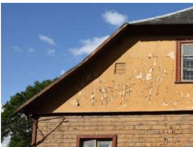
63. attēls. Ēkas A gala fragments, skats uz R. Labi redzama apakšdaļā “lauztā” jumta līnija.
