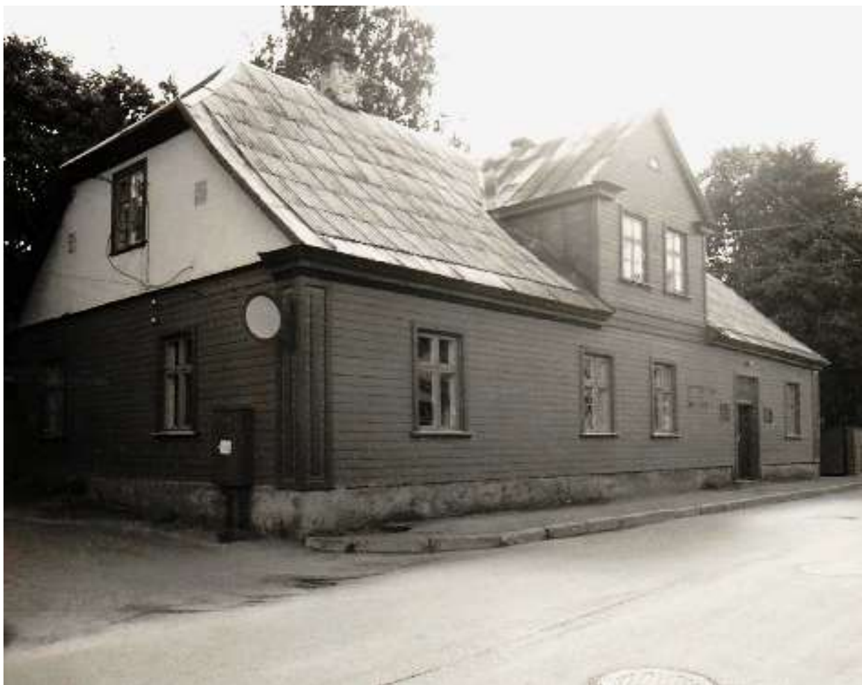
22. attēls. Ēka Rīgas ielā 20, skats uz DR. Foto ap 1985. gadu. VKPAI PDC, Bauskas vecpilsētas lieta
