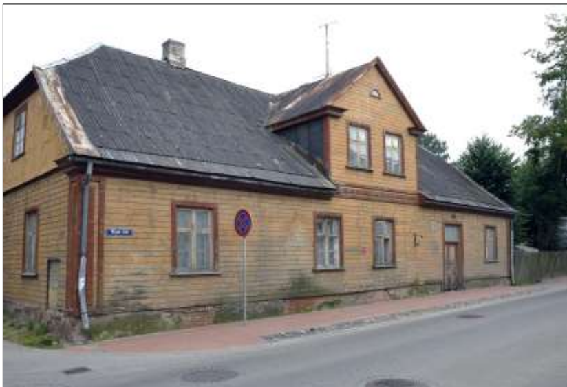
1. attēls. Ēka Rīgas ielā 20, skats no ZA.
