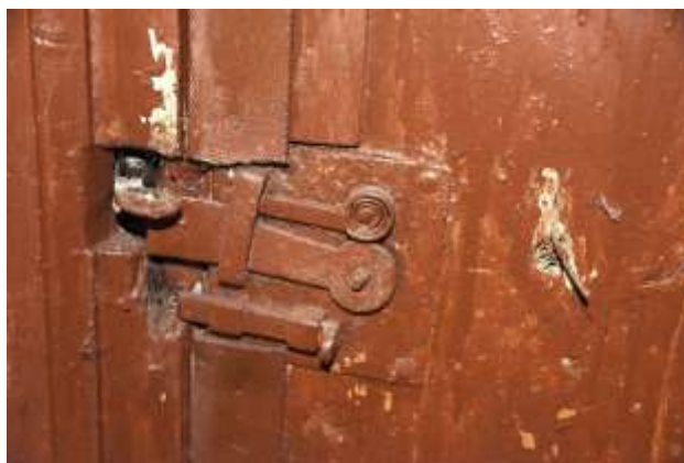
143., 144., 145. attēls. 19. gs. beigu durvis D-II/9 un to furnitūra.
