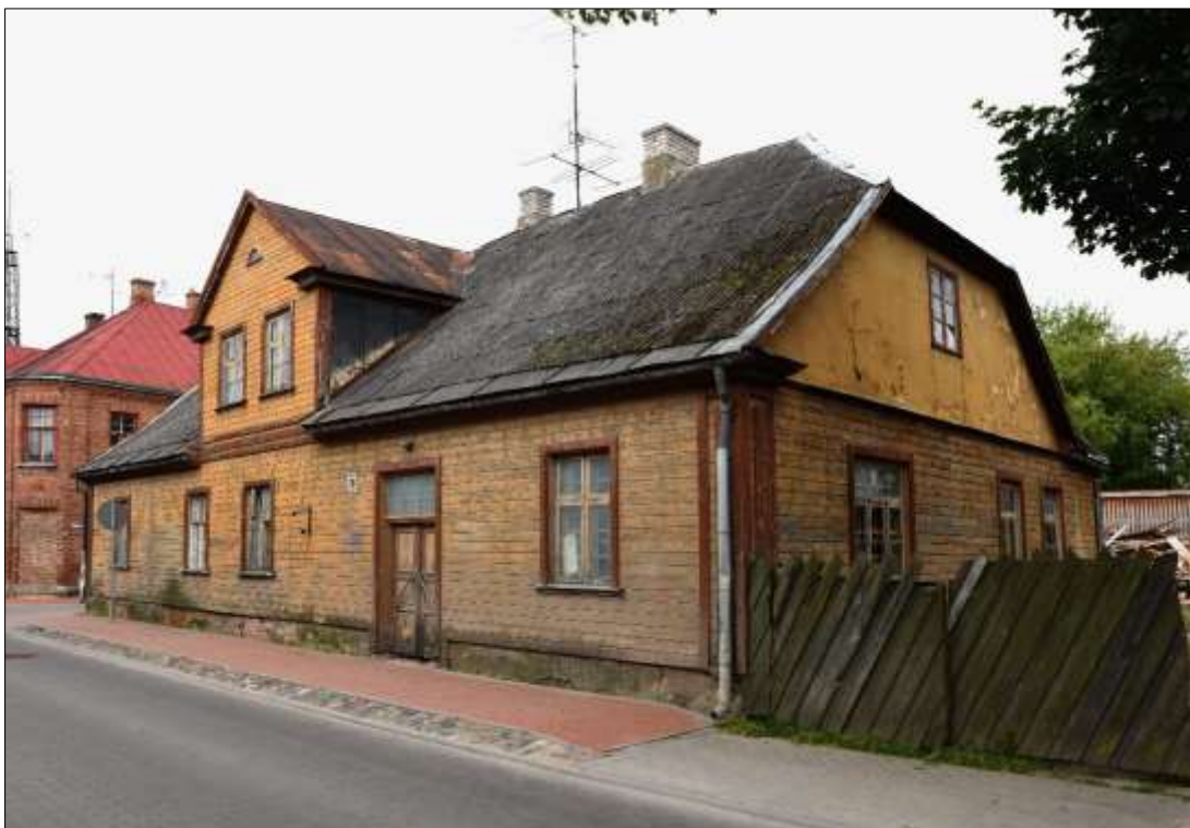
23. attēls. Ēka Rīgas ielā 20, Z fasāde, kopskats uz DA.
