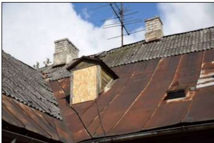
57. attēls. Daļa ēkas pamatkorpusa D plaknes un šķērskorpusa A plaknes (skats uz DR), uz kurām redzams gan cinkotā skārda, gan gofrētā azbestcements lokšņu segums.
