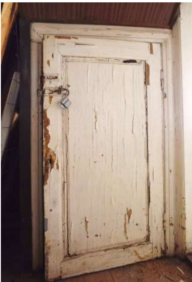
131. attēls. 18. gs. beigu durvju D-I/8 vērtnes profila skice. Rundāles pils muzejs, Zinātniskais arhīvs
