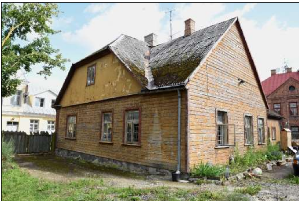
52. attēls. Ēkas R fasāde, skats uz ZA.
