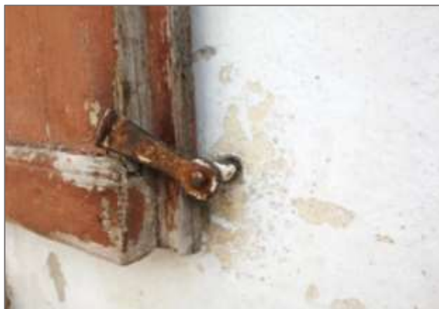
182. attēls. 19. gs. slēģu fiksatori Bauskā, Plūdoņa ielā 52.
