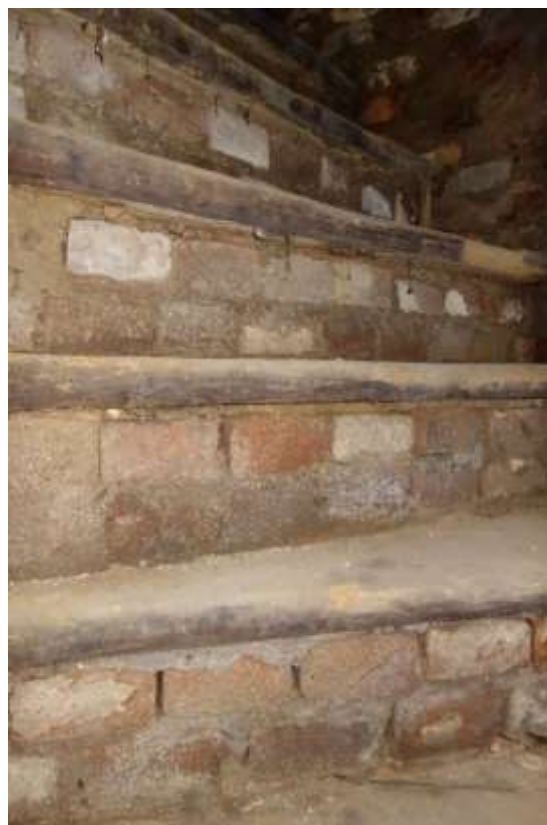
26. attēls. Sākotnējās kāpnes uz pagrabu. Redzams, ka pakāpieni mūrēti no ķieģeļiem un iesegti ar bieziem koka dēļiem.
