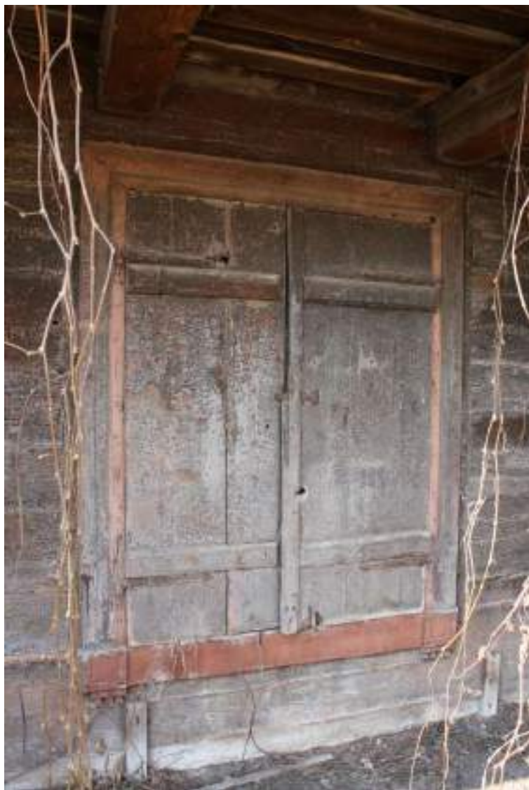
Pluudonja_26_1_detala1 1839.-1882.g. slēģu komplekts, loga apmales, neapšūta guļbalķu fasāde un portika pārseguma sijas.
