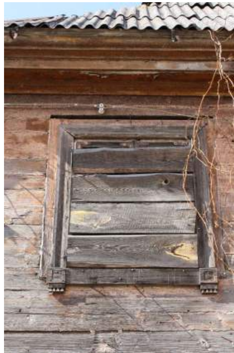
Pluudonja_26_1_detala2 1839.-1882.g. loga apmales, neapšūta guļbalķu fasāde un dēļu dzega.
