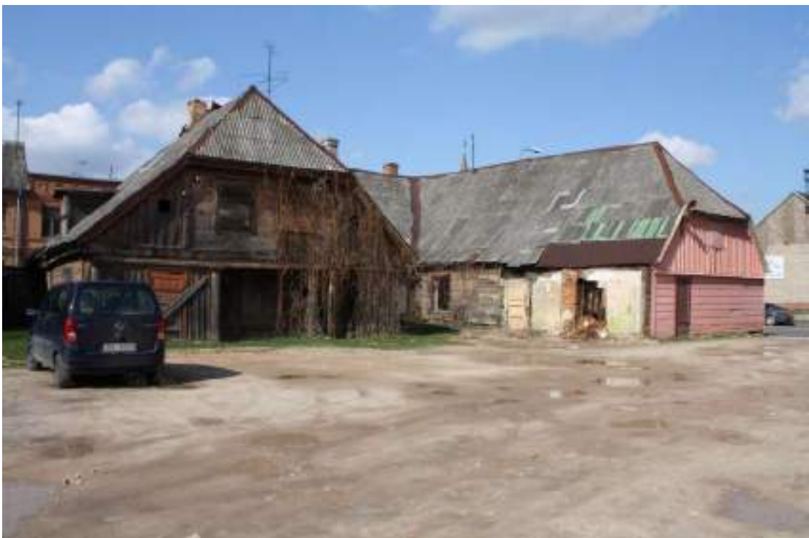
Pluudonja_26_1_fasade2 Skats uz ēku no dienvidrietumiem. Redzamas 1839.-1882.g. uzceltās piebūves. Gar Kalna ielu esošā piebūve sākotnēji bijusi vienā garumā ar pagalma piebūvi. Laikā līdz 1882.g. tā pagarināta līdz pašreizējam apjomam.
