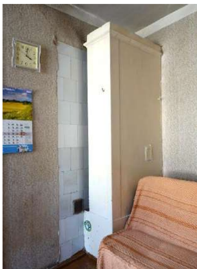
142. attēls Vecākā mājā saglabātā neglazētu podiņu krāsns dzīvoklī Nr. 5.
