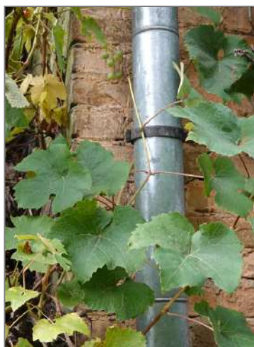
77. attēls. 20. gs. otrās puses vai 21. gs. sākuma ūdens noteku caurule, kas stiprināta pie sienas ar vecāku melnā metāla skavu.
