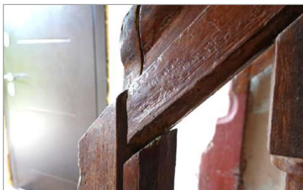
136. attēls. Profilēta paroceņa fragments, visticamāk, izgatavots 20. gadsimta 50. gados pēc oriģinālā paroceņa parauga.
