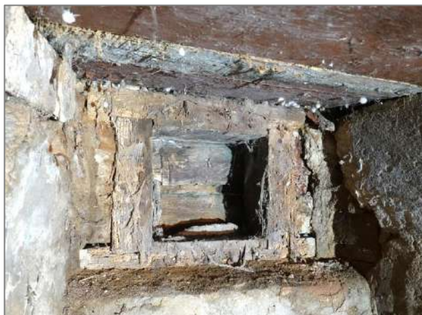
46. attēls. Pagraba ventilācijas lūkas kārbā.
