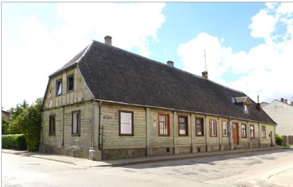
1. attēls. Ēka Plūdoņa ielā 18. Skats uz DR.
