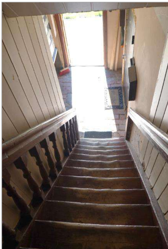
137. attēls. Profilētie kāpņu pakāpieni ar izstaigātu vidusdaļu.
