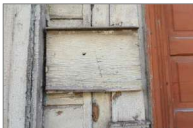
74. attēls. Informācijas plāksnītes pamatne uz ēkas Z fasādes.
