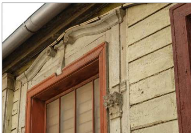
49. attēls. Z fasādes daļa ar portālu, kur redzams, ka plakne, uz kuras tas būvēts, salīdzinot ar dēļiem apšūto daļu, ir nedaudz iedziļināta.
