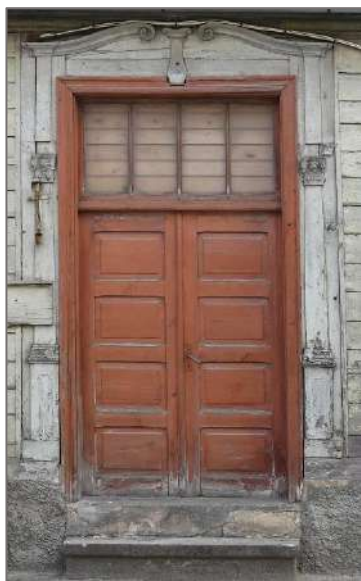
116. attēls. Skats uz ēkas galvenajām ārdurvīm D2 pret Plūdoņa ielu vērstajā fasādē.
