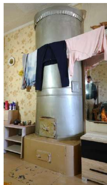
147. attēls. Apaļa skārda čaulas krāsns dzīvoklī Nr. 7, mūrēta uz vecākas krāsns (kvadrātiskas ar noapļotiem stūriem) pamatnes.
