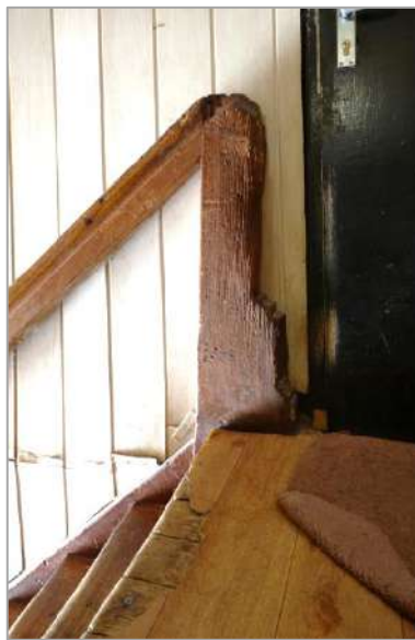
132. attēls. Kāpņu paroceņa balsts ēkas pirmajā stāvā.
