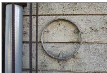
73. attēls. Padomju laika atkritumu tvertnes detaļa uz ēkas Z fasādes.
