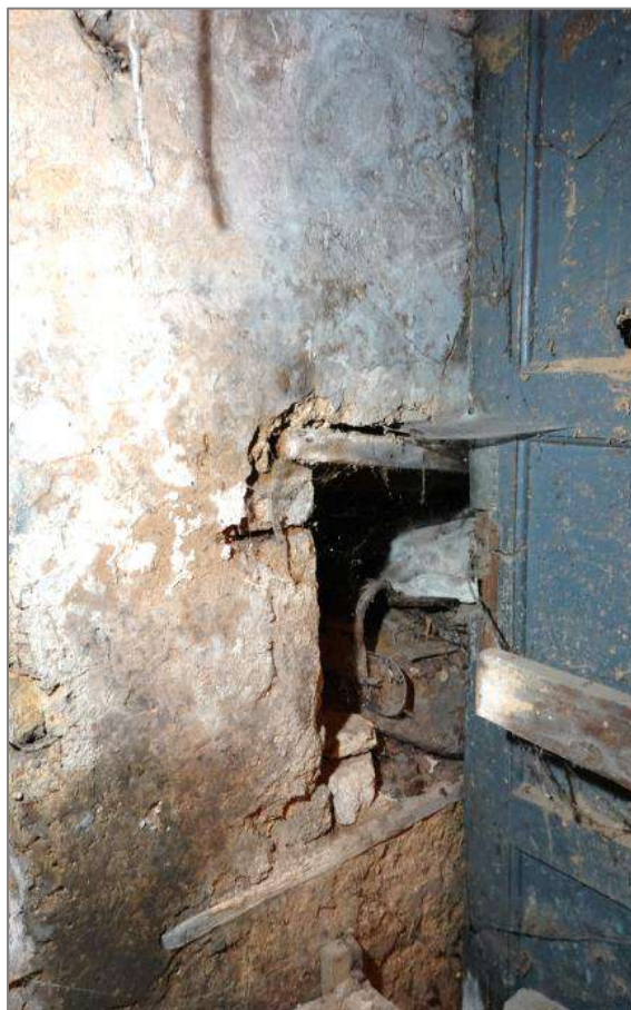
47. attēls. Niša pagraba sienā. Attēlā redzams, ka starpsienas veidošanai pagrabā izmantota kādu pildīņu durvju vērtne.
