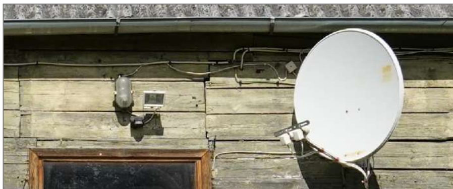
76. attēls. Haotisks dažādu vadu, apgaismes ierīču un satelīta šķīvja izkārtojums uz ēkas fasādes.
