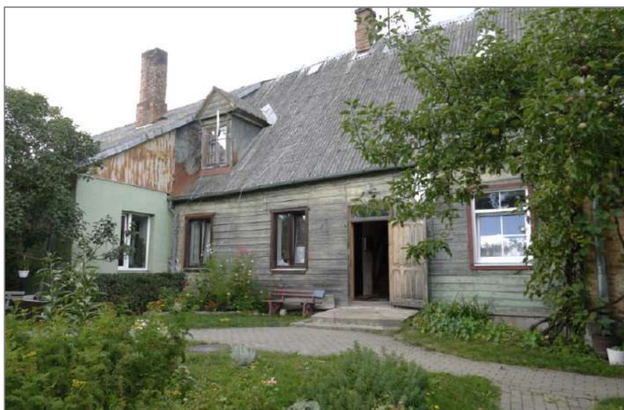
68. attēls. Ēkas D fasādes R daļa.
