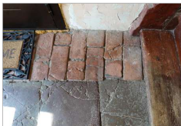
140. attēls. Ķieģeļu grīdas segums kāpņu telpā.
