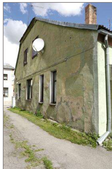
118. attēls. Skats uz aizmūrēto ārdurvju ailu ēkas DR fasādē.
