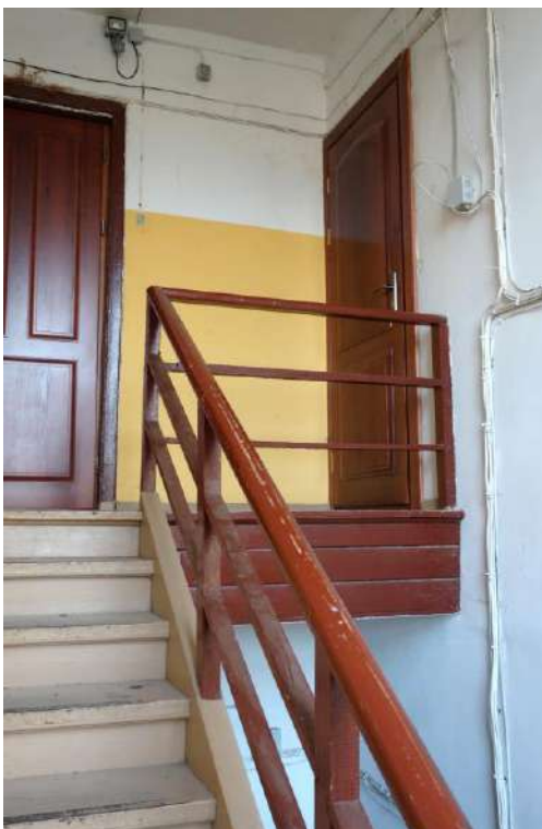
87. attēls. Padomju laikā kāpnes un kāpņu margas.
