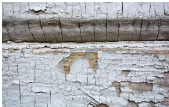
66., 67. attēls. Sākotnējā krāsojuma paliekas uz ēkas z fasādes apšuvuma dēļiem.
