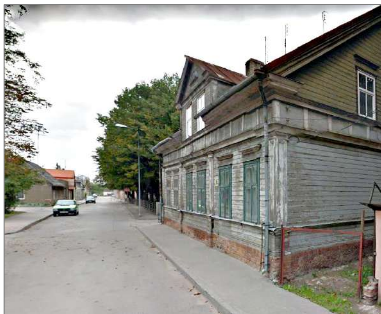
1. attēls. Ēka Plūdoņa ielā 15, skats uz ZR. 2011. gada foto
