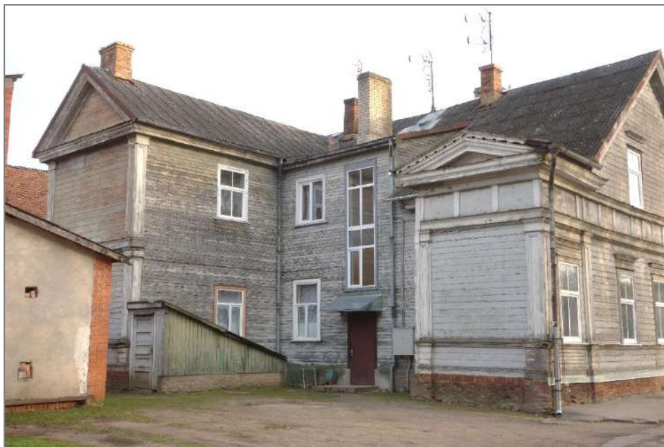
56. attēls. Ēkas Z fasāde, skats uz DA.
