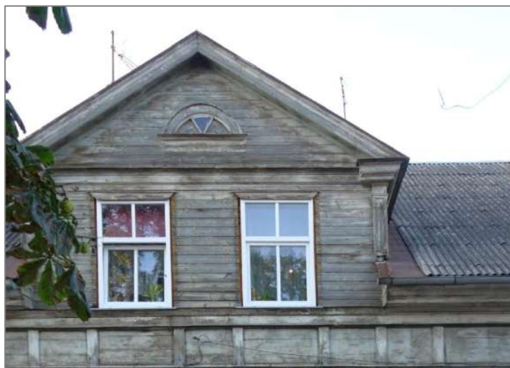
44. attēls. Skats uz mezonīna izbūvi ēkas D fasādē.
