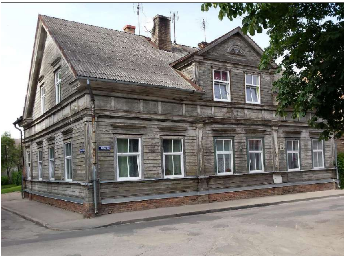
24. attēls. Ēka Plūdoņa ielā 15, D fasāde, kopskats uz ZA.
