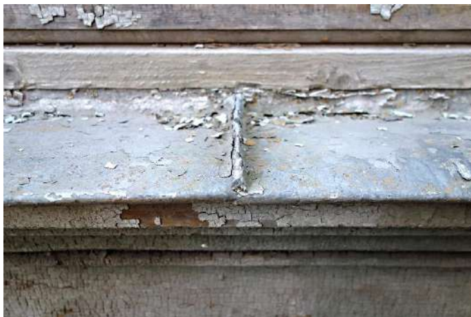
38. attēls. Sākotnējais skārda lasmenis virs trīspakāpju profiljoslas.
