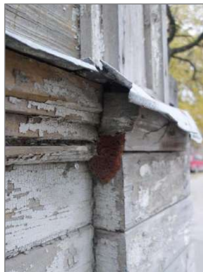
97. attēls. Profiljoslas bojājuma aizpildījums ar celtniecības putām ēkas R fasādē.
