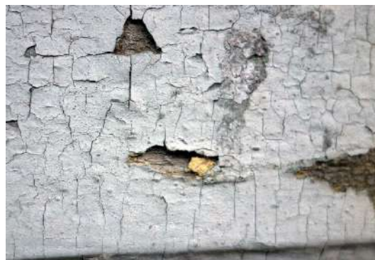
66., 67. attēls. Sākotnējā krāsojuma paliekas uz ēkas z fasādes apšuvuma dēļiem.
