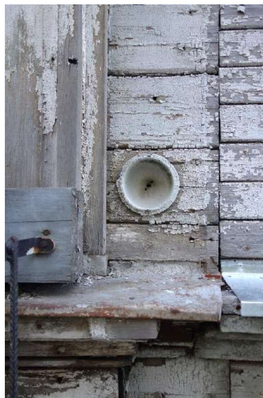
51. attēls. Kādreizējā durvju zvana detaļa R fasādē, skats uz A.
