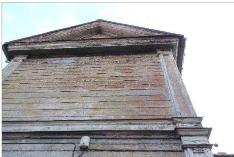
62. attēls. Skats uz saimniecisko telpu šķērskorpusu Z fasādē.
