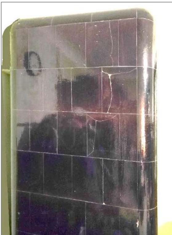
90., 91., 92., 93. attēls. Glazētu podiņu krāsns K3 divu telpu apsildīšanai dzīvoklī Nr. 5.
