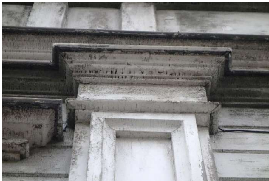
49. attēls. Skats uz pilastra augšdaļu ēkas R fasādē.
