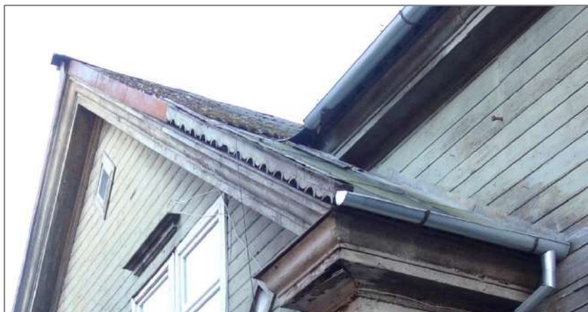
71. attēls. Oriģinālais robdēlis ēkas A fasādes jumta slīpnē.
