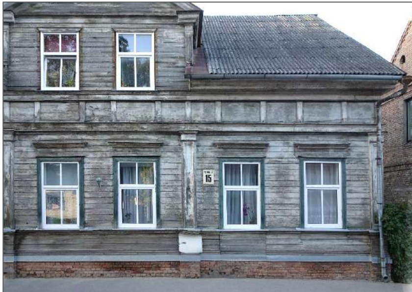
42. attēls. Ēkas D fasādes A gals, Skats uz Z.
