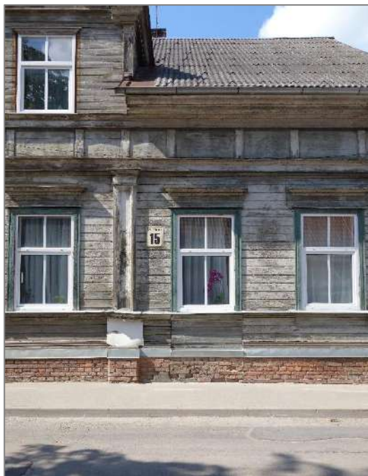
46., 47. attēls. D fasādes fragmenti ar bojājumu vietām – bojāto pilastra bāzi, kas aizsegta ar kartonu, un trūkstošajā profiljoslām zem loga Nr. L1/6.
