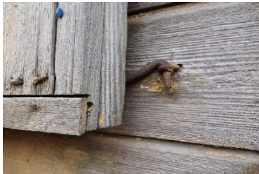
100. attēls. 19. gs. slēga fiksators Bauskā, Rīgas ielā 24.
