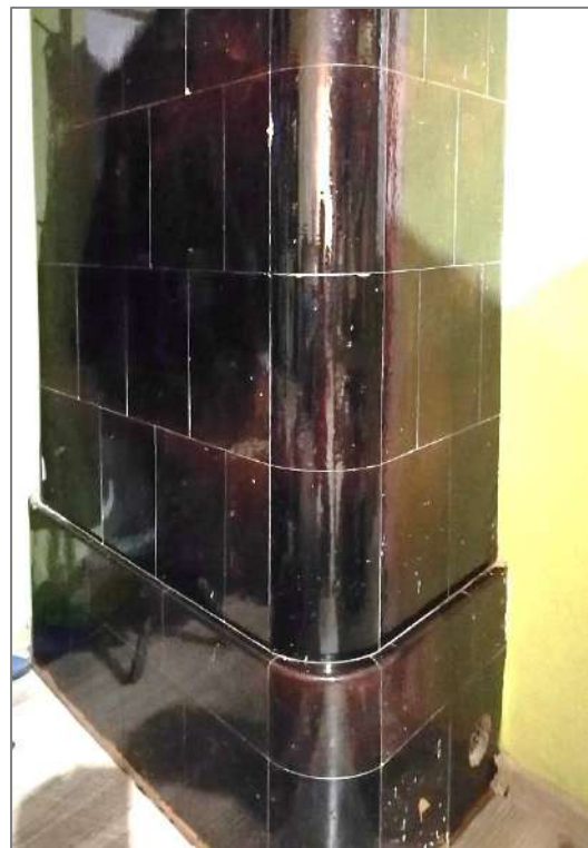
90., 91., 92., 93. attēls. Glazētu podiņu krāsns K3 divu telpu apsildīšanai dzīvoklī Nr. 5.
