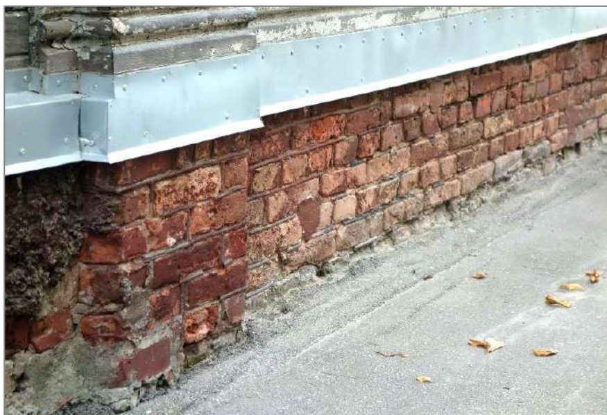
29. attēls. Ēka Plūdoņa ielā 15, skats uz virspamatiem D fasādē.
