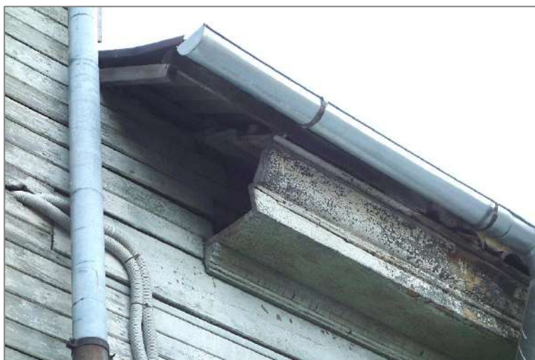
63. attēls. Skats uz sākotnējo kastes dzegu Z fasādē, kas 1971. gada remonta laikā pārzāģēta, uzceļot kāpņu telpas piebūvi. Redzams, ka dzega sākotnēji bijusi tumši (zaļganbrūni?) krāsota.
